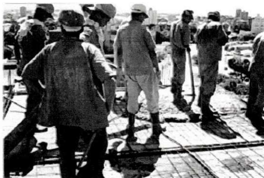
Fig. 7.2.1.d Lançamento do concreto
