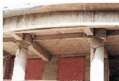
Figura 7.2.1.b Laje maciça e blocos de transição
