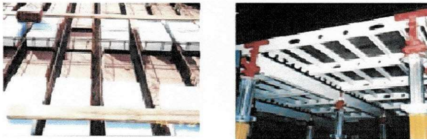
Figura 7.2.3.c e 7.2.3.d Laje nervurada formada por lajes pré-fabricadas com incorporação de blocos de isopor (cortesia lajes Anhanguera) e estrutura de cimbramento de alumínio (cortesia Peri)
