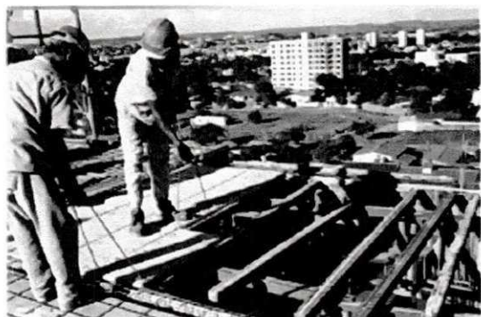
Fig 7.2.1.c Colocação dos elementos pré-moldados
