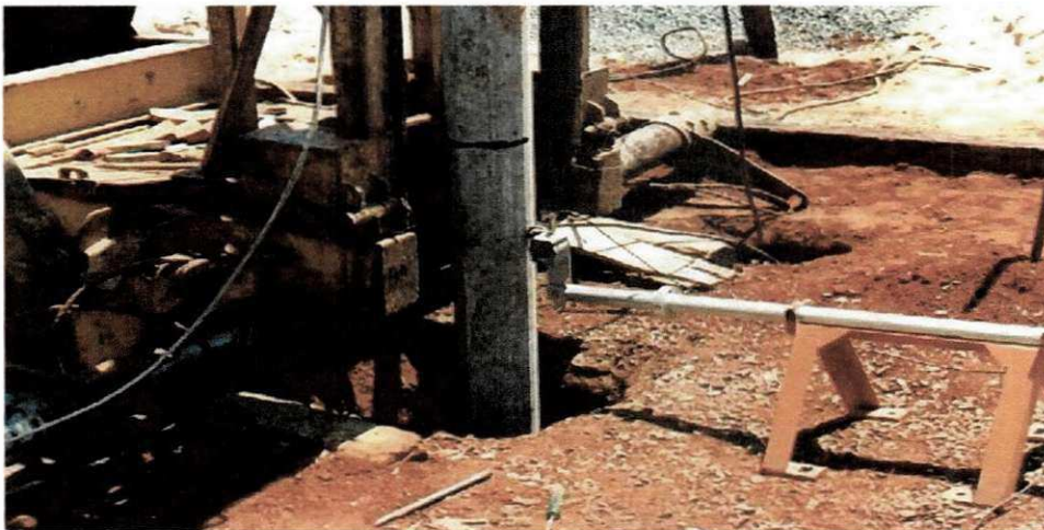
Cravação de estaca pré-moldada.
