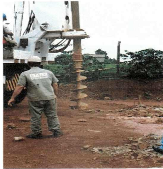
Detalhe do elemento de escavação.
