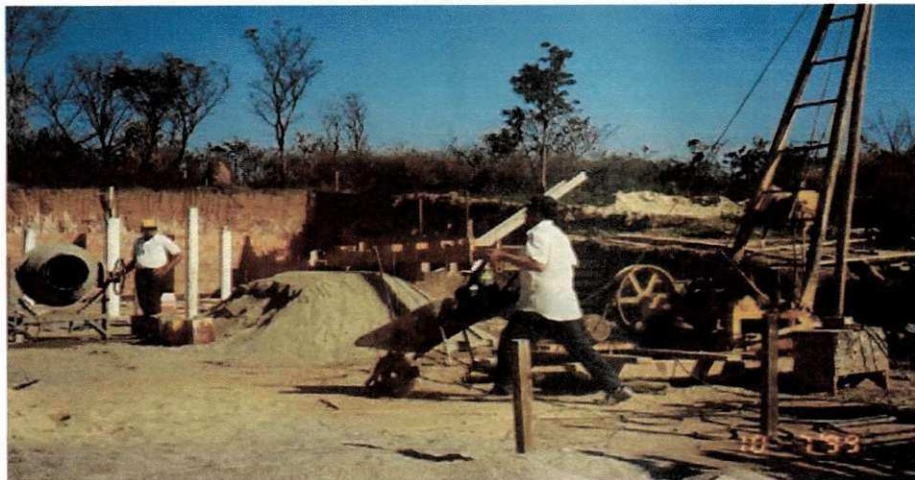
Execução de estaca Strauss.
