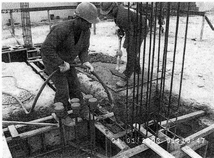
Foto 8: Concretagem das vigas baldrames Foto: João Figueiredo Rosas
