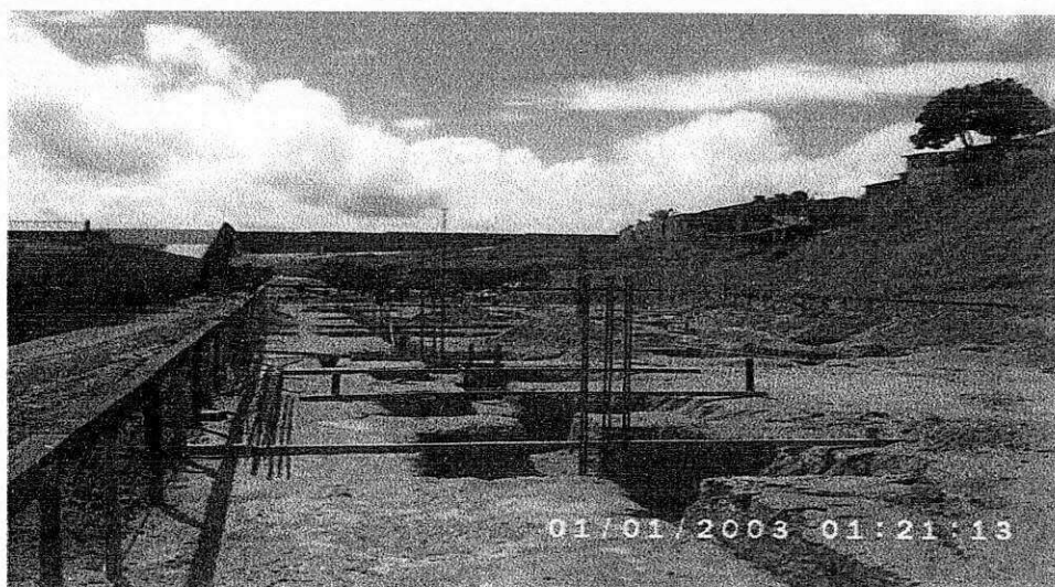
Foto 4: Locação de sapatas e pilares (Gabarito) Foto: João Figueiredo Rosas
