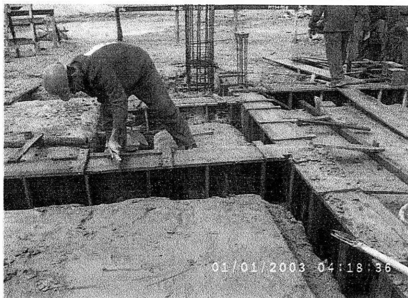
Foto 8: Término da concretagem das vigas baldrame Foto: João Figueiredo Rosas
