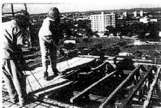
Fig 7.2.1.c Colocação dos elementos pré-moldados
