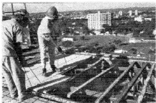
Fig 7.2.1.c Colocação dos elementos pré-moldados
