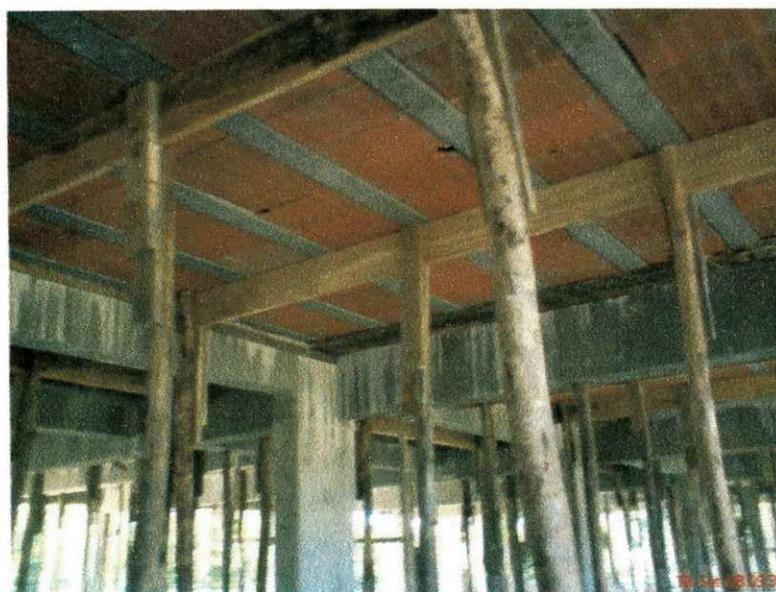
**Exemplo de estronca para apoiar lajes pré - moldadas**
