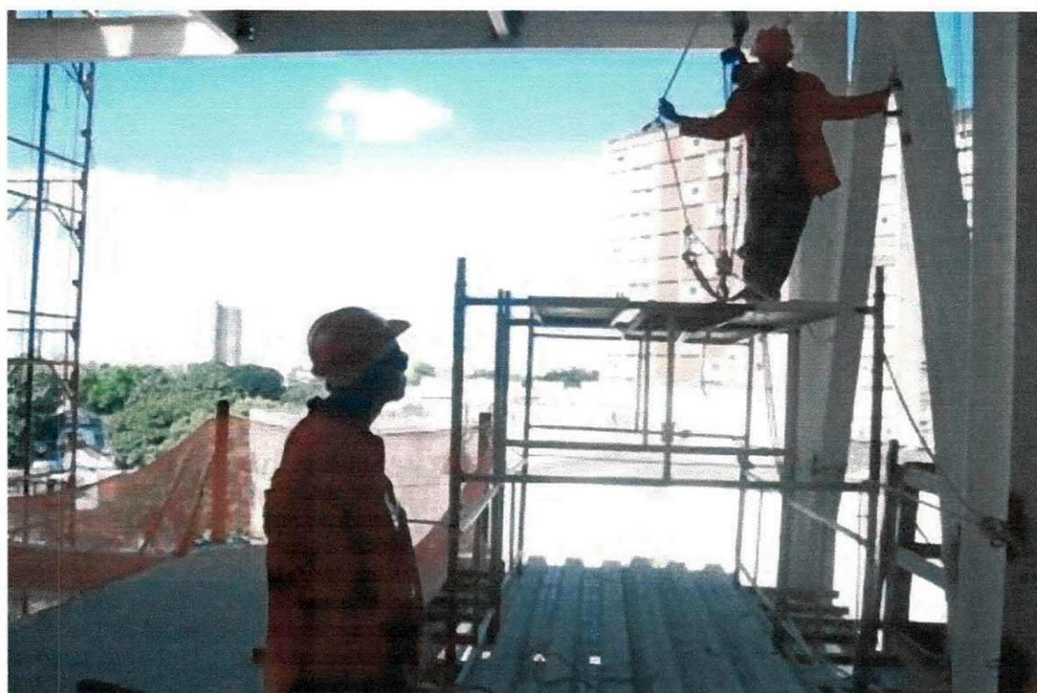
**Figura 61 - Utilização dos andaimes na fixação de parafusos.**
