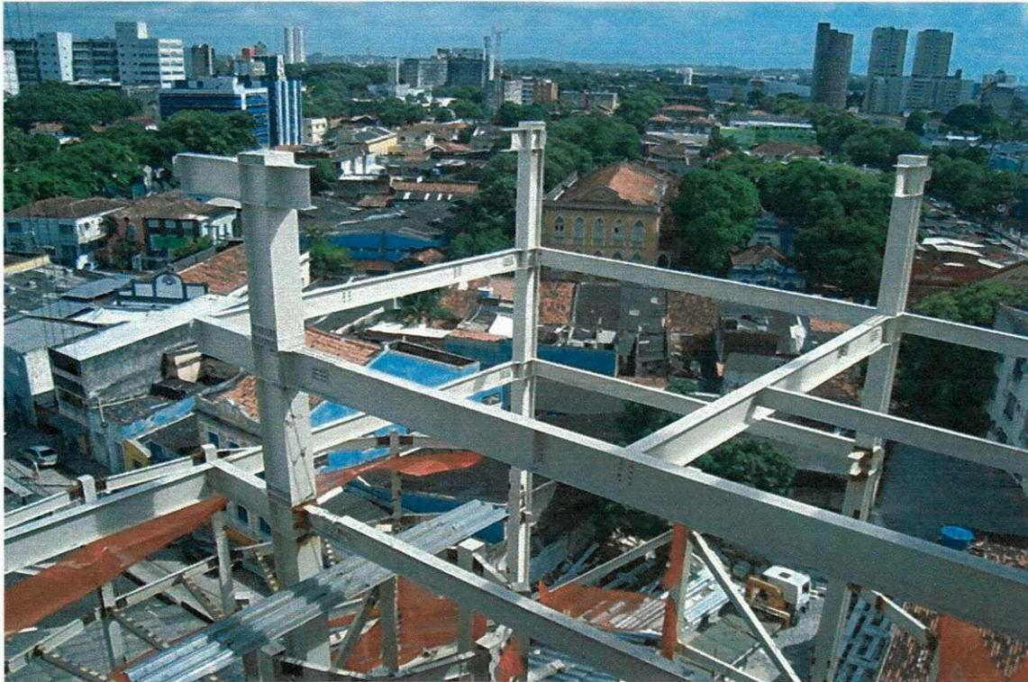
**Figura 66 - Vigas e Pilares do 10º e 11º pavimentos.**
