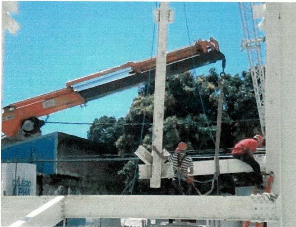
**Figura 45 - Montagem do pilar referente ao 7º pavimento.**
