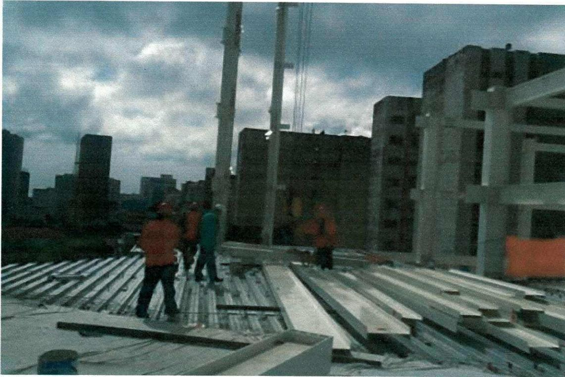
**Figura 70 - Descarrego de vigas e pilares na lajes 9°.**
