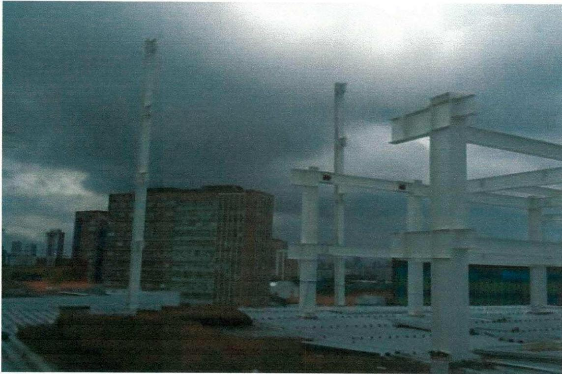
**Figura 68 - Montagem dos pilares do 10º e 11º pavimento.**
