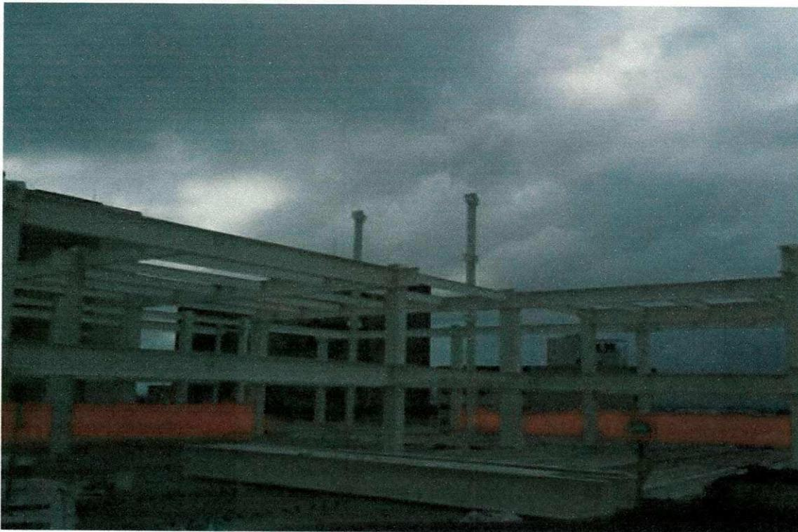
**Figura 71 - Montagem de vigas do 10° e 11°.**
