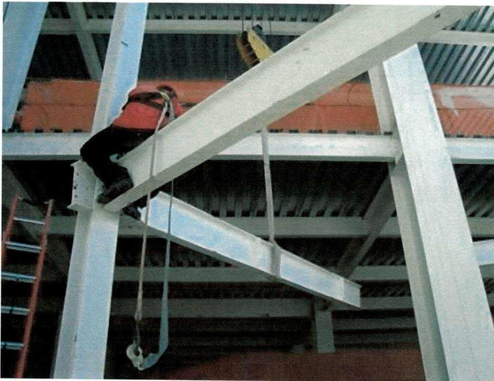
**Figura 43 - Montagem de vigas do 6º pavimento.**
