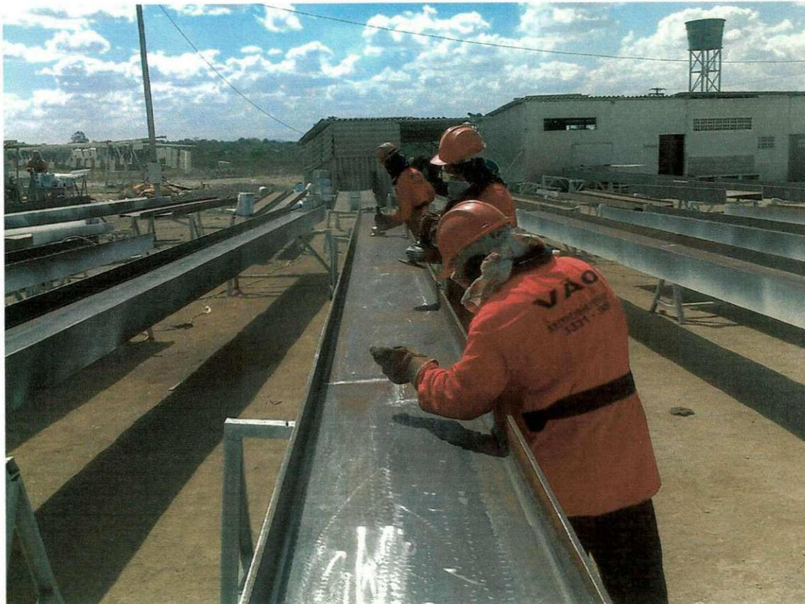
**Figura 39 - Processo de acabamento utilizando a escova de aço trançada de 4”.**
