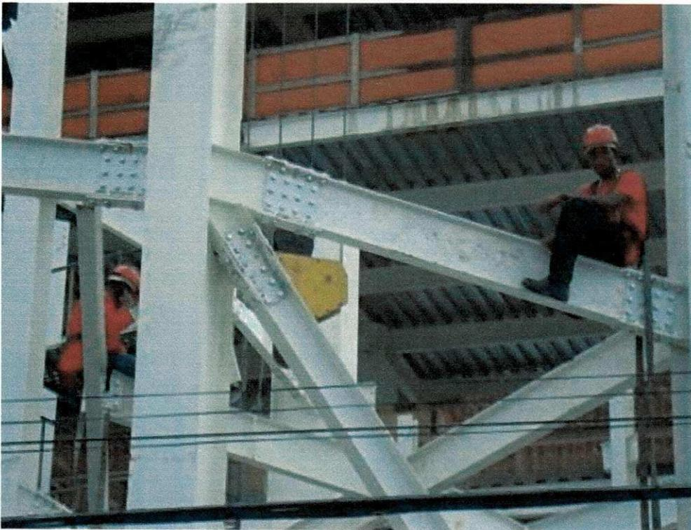
**Figura 47 - Vigas montadas referente ao 6º pavimento.**
