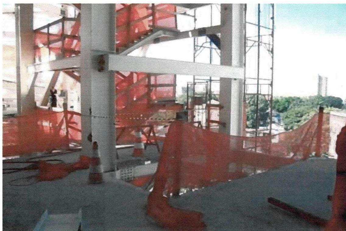
**Figura 59 - Pilares e vigas montadas do 8º e 9º pavimentos.**
