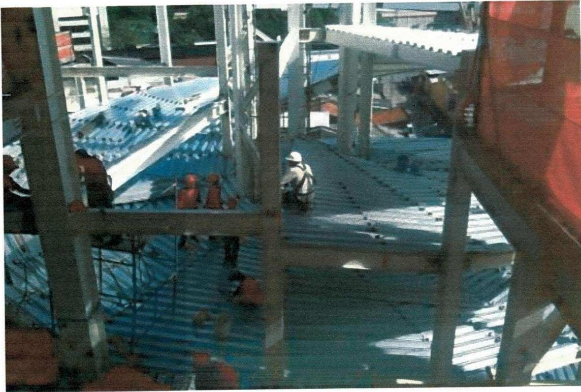
**Figura 50 - Colocação de lajes steel decks, etapa final da rampa curva.**
