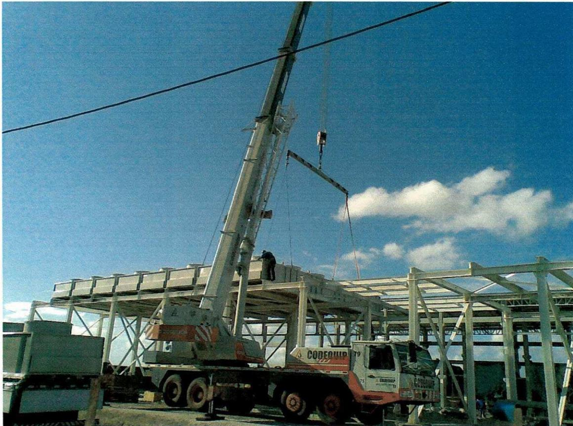
**Figura 16 - Içamento de viga com um guindaste G70.**
