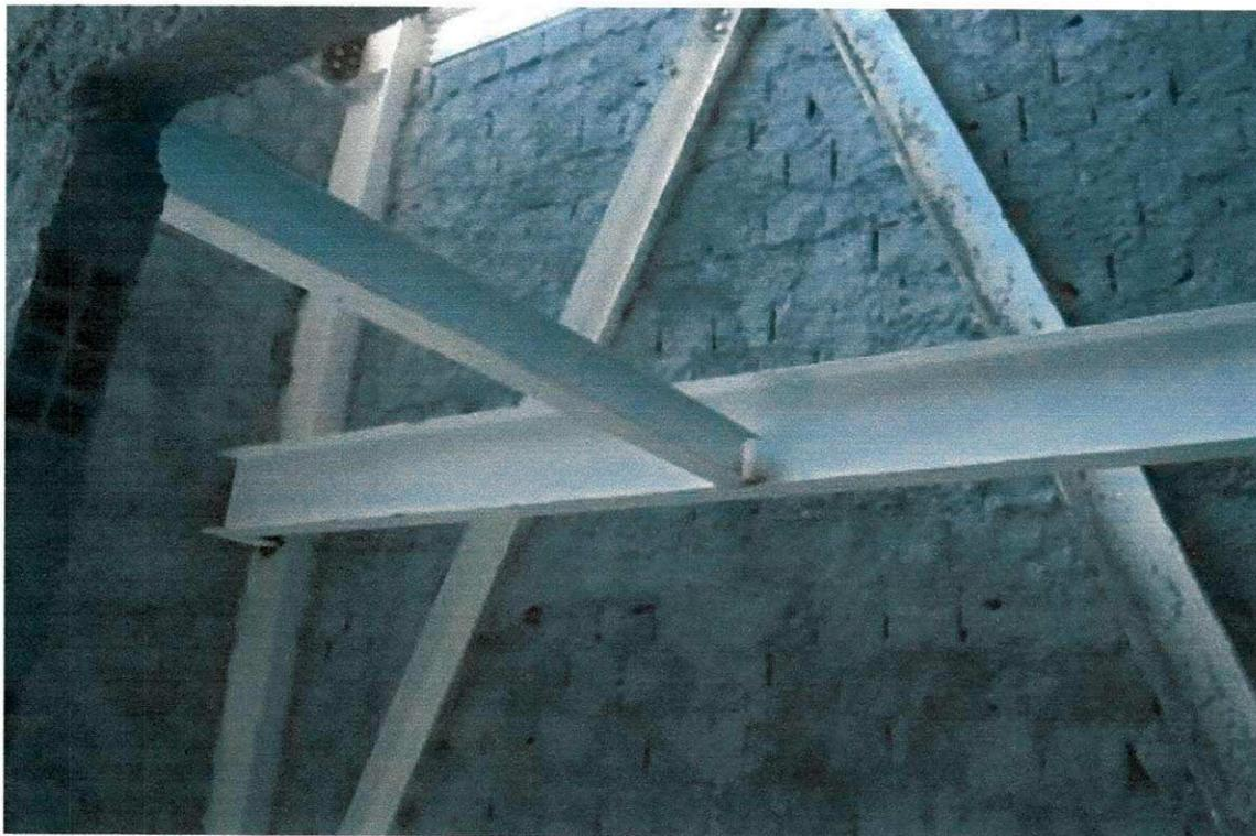
**Figura 57 - Estrutura de contraventamento.**
