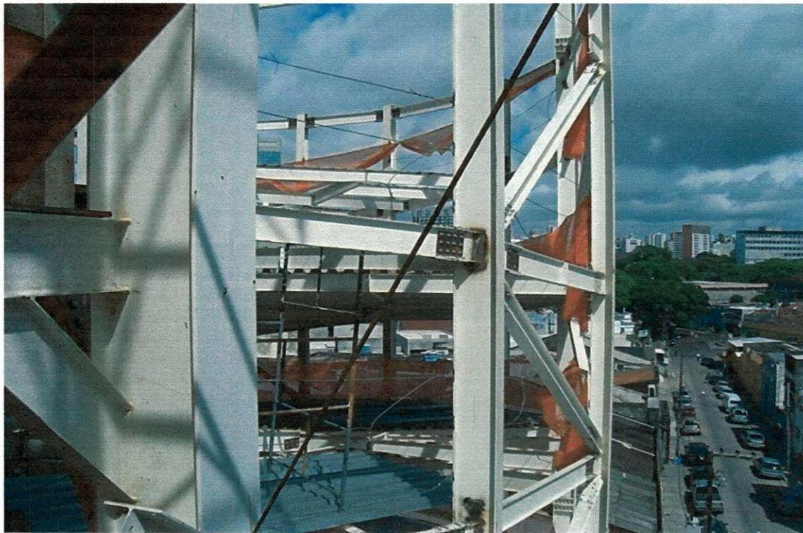
**Figura 65 - Estrutura de contraventamento do 10º e 11º pavimentos.**
