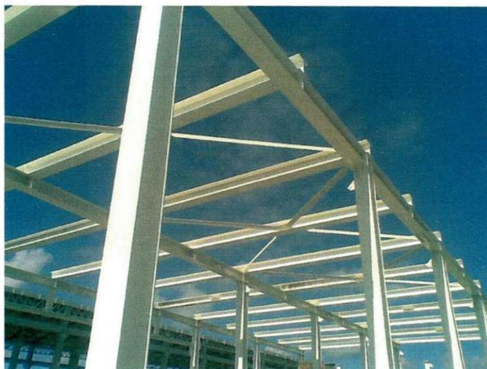
**Figura 23 - Núcleo de contraventamento em estruturas de edifícios**
