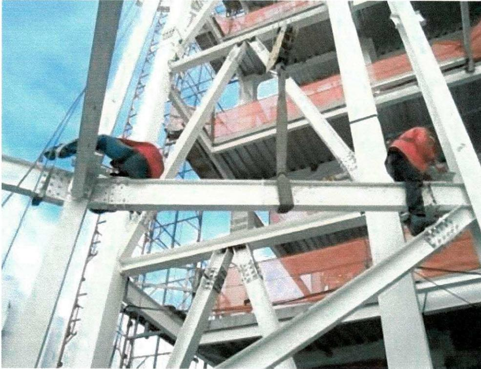
**Figura 44 - Montagem de vigas do 6º pavimento.**
