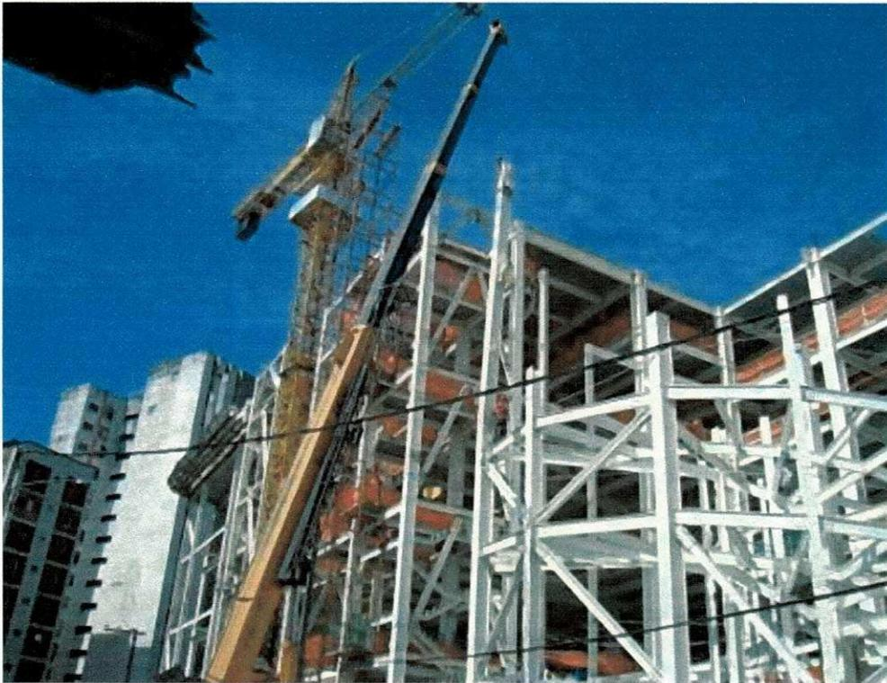
**Figura 46 - Içamento de pilar, utilizando o guindaste G70.**
