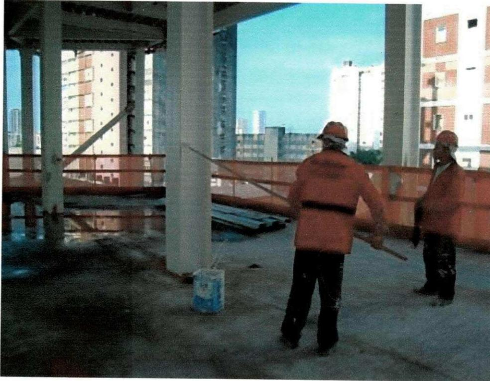
**Figura 48 - Acabamento de pilares, utilizando tinta ERD POXI 9010 RAL BRANCO.**
