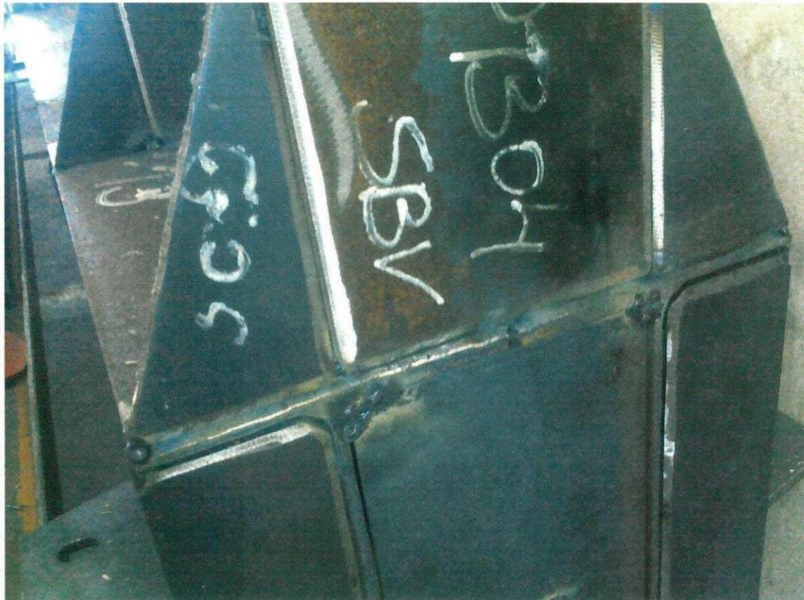
**Figura 37 - Chanfo bisel de 60° com solda garganta efetiva de 6mm, dado em uma pilar da obra.**
