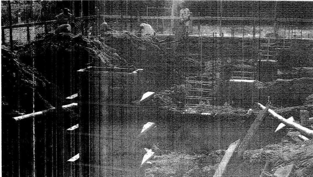
*Figura 27. Confeção dos tocos dos pilares da obra do Laboratório de Resíduos Sólidos.*
