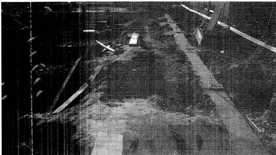
*Figura 02. Serviço de movimento de terra para nivelção do terreno com o baldrame da obra Laboratório de Resíduos Sólidos.*
