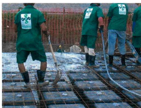
Figura 5 – Concretagem da laje usando o concreto usinado
