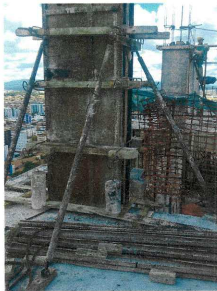
Figura 20 - Fôrmas e escoramentos para pilares
