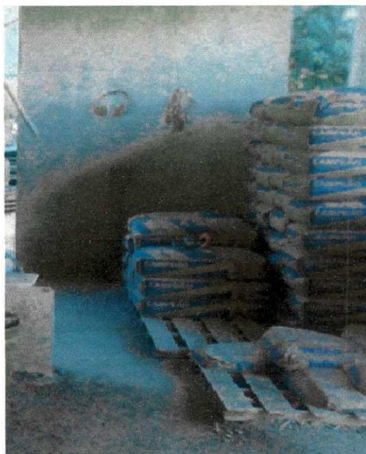
Figura 24 – Armazenamento do cimento
