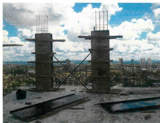
Figura 7 - Laje pré-fabricada concretadas.
