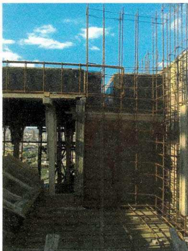
Figura 8 - Verificação dos espaçamentos das ferragens
