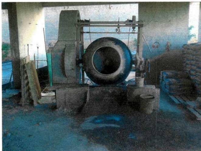
Figura 3 - Processo de fabricação do concreto “in locu”
