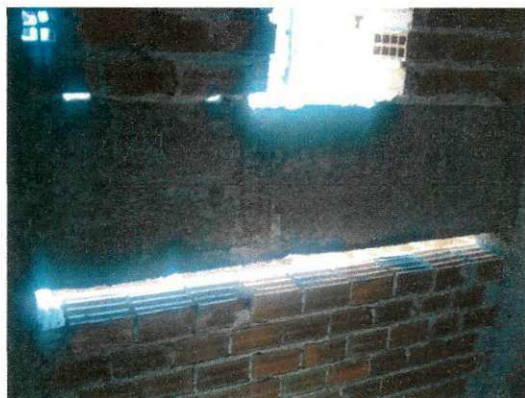
Figura 10 – Alvenaria de uma vez
