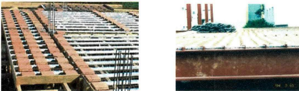
Figura 1 - Operação de alinhamento das vigotas e painéis treliçados
