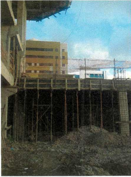
Figura 19 - Fôrmas e escoramentos para lajes e vigas
