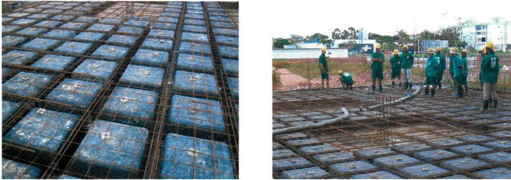
Figura 2 – Disposição das formas para laje nervurada.
