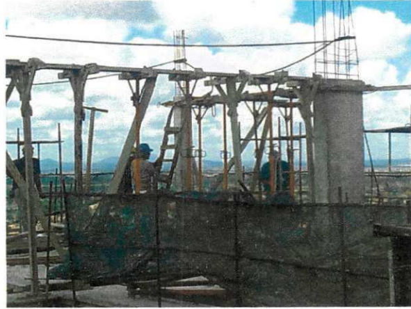
Figura 19 - Fôrmas e escoramentos para lajes e vigas
