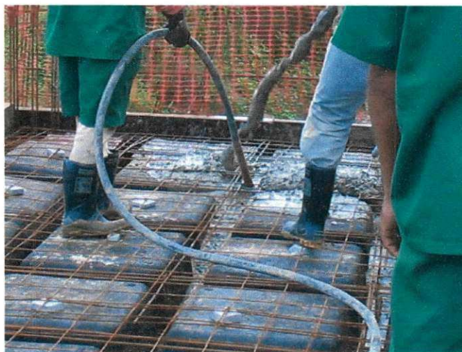
Figura 22 – Utilização do vibrador de imersão
