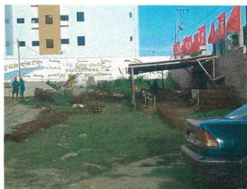
Figura 15 – Disposição do canteiro
