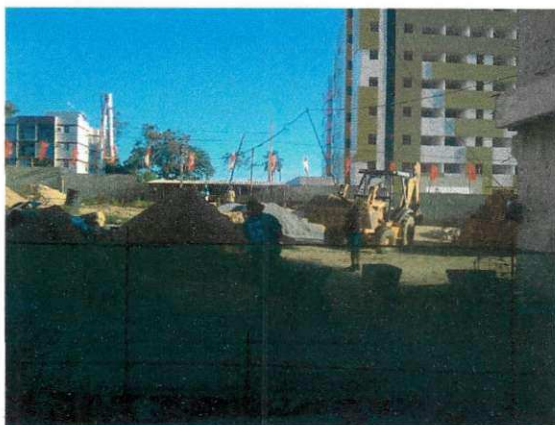
Figura 14 – Estocagem de agregados
