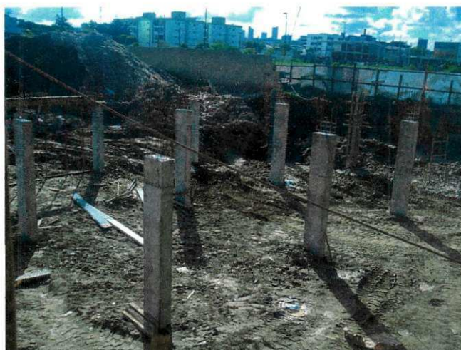
Figura 21 - Pilares depois de retirada a fôrma
