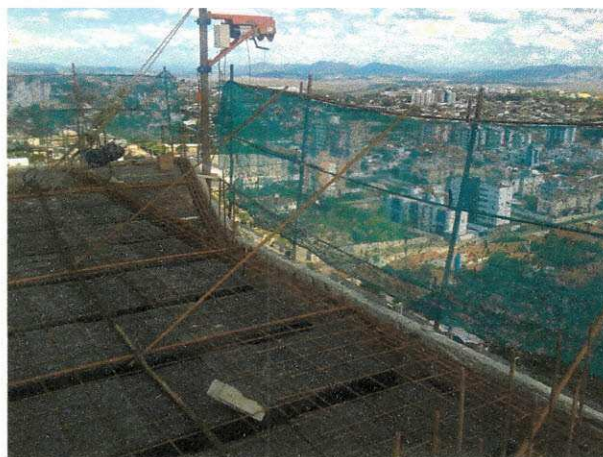
Figura 9 - Armadura à espera do concreto
