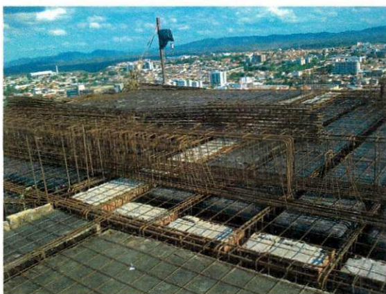
Figura 6 – Laje antes da concretagem
