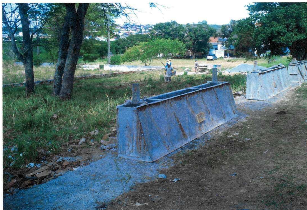
Fig. 09_ Formas de chapas de aço montadas.
