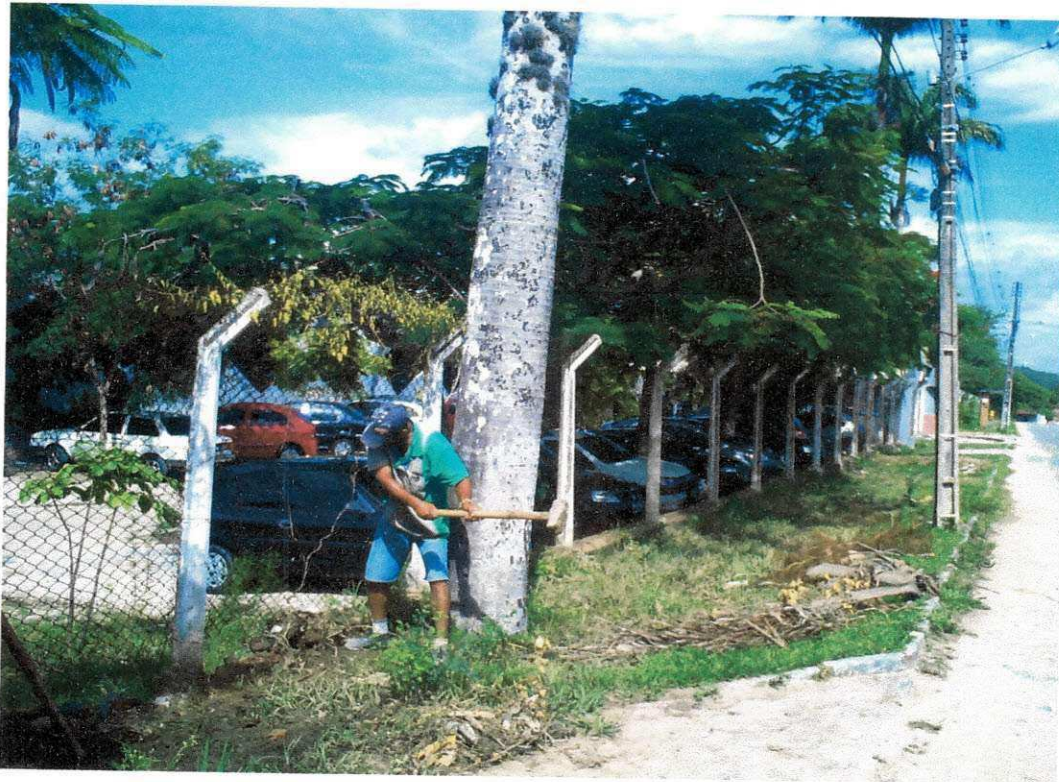
Fig. 06_ Processo de Demolição da Base.
