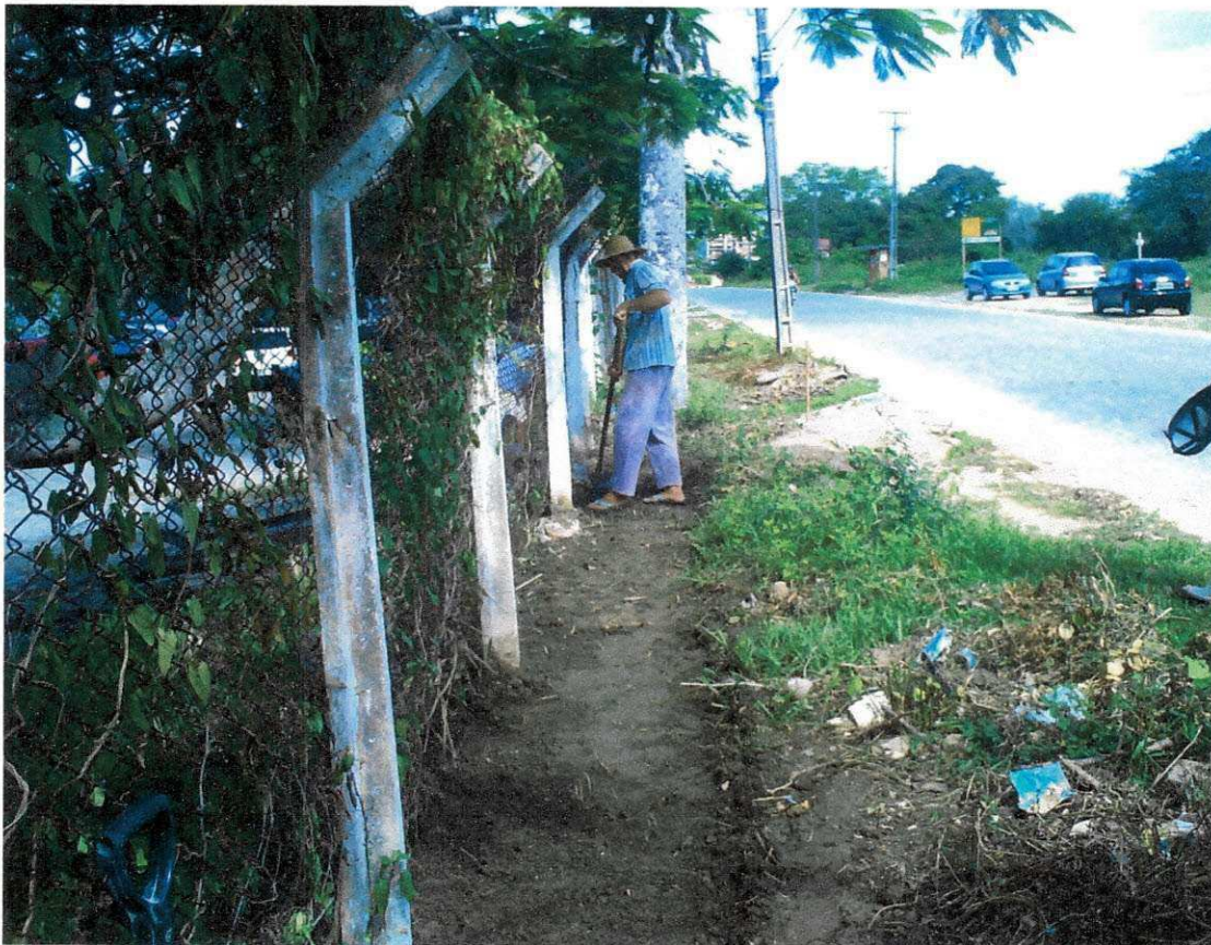
Fig. 1,2 e 3_ Processo de Capinagem e limpeza
