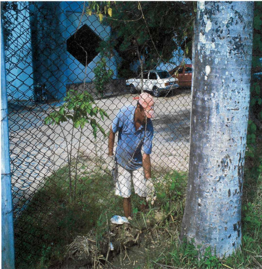
Fig. 04 _ Processo de Remoção da Tela de Aço.
