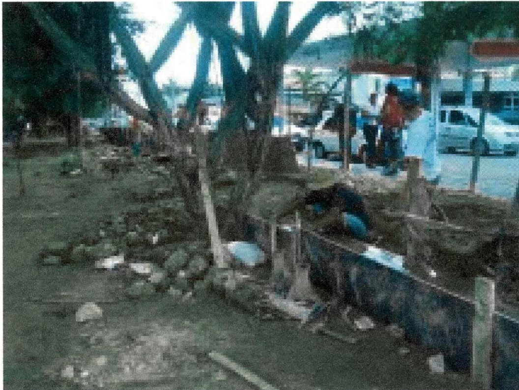
Fig. 10_ Processo de execução da fundação da Mureta.
