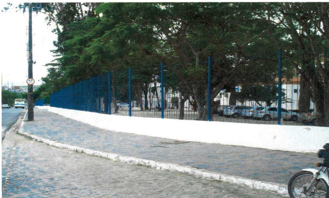
Fig. 21 _ Muretas com as grades montadas e pintadas da entrada.
