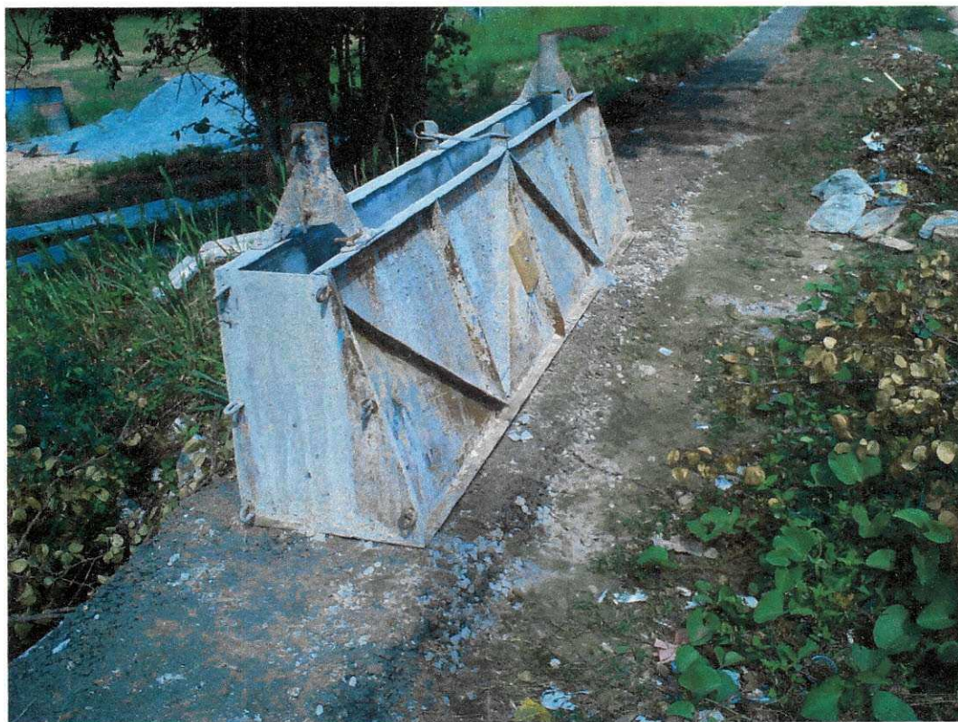
Fig.13_ Sub-base pronta, regularizada com forma de aço montada.
