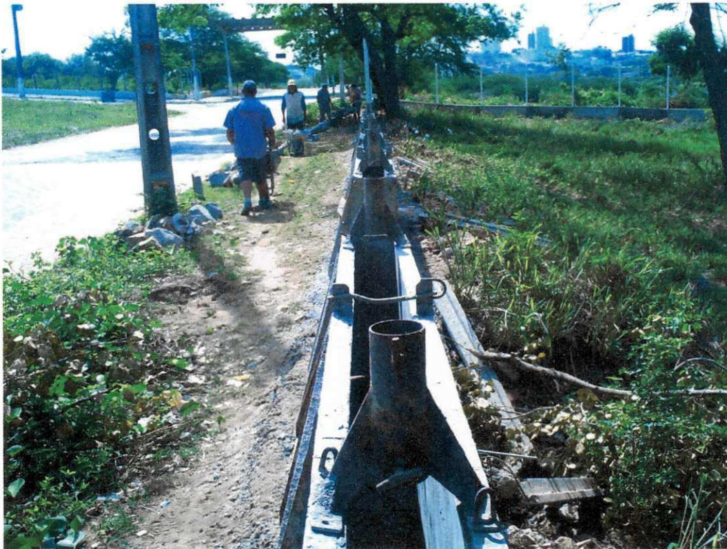
Fig. 14_ Processo de Transporte do concreto.
