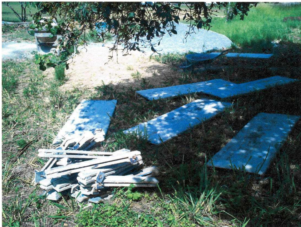
Fig. 08_ Formas de madeira desmontadas, betoneira e Carrinho de mão.
