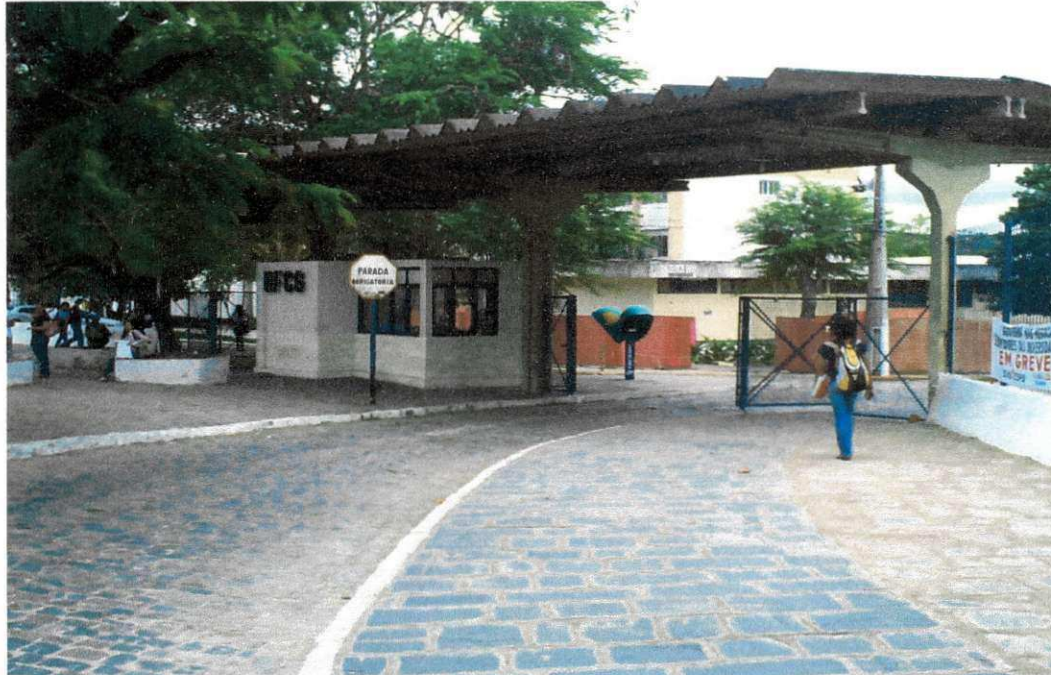
Fig. 22 _ Portões de entra da entrada principal, montados e pintados.
