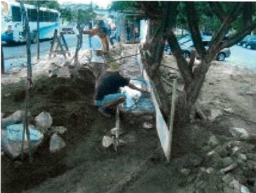
Fig.11_ Processo de execução da fundação da Mureta.
