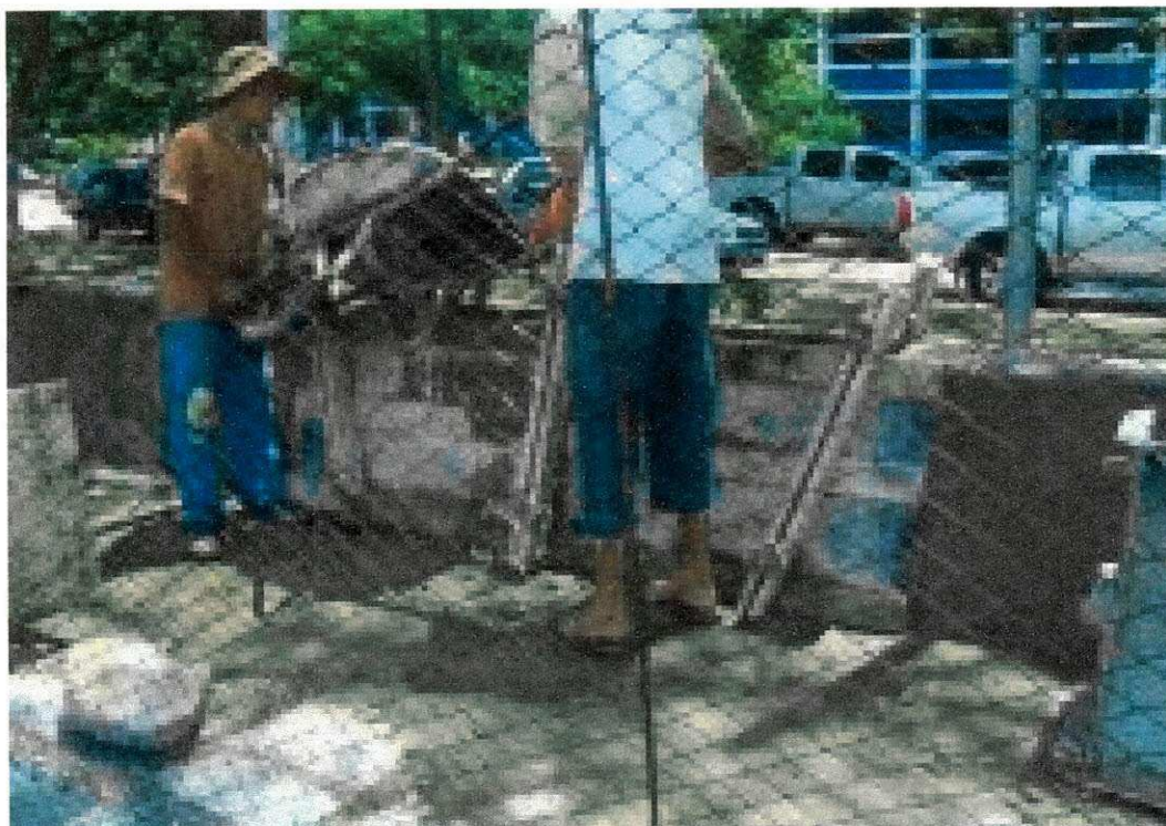
Fig. 15_ Processo de concretagem e lançamento do concreto.
