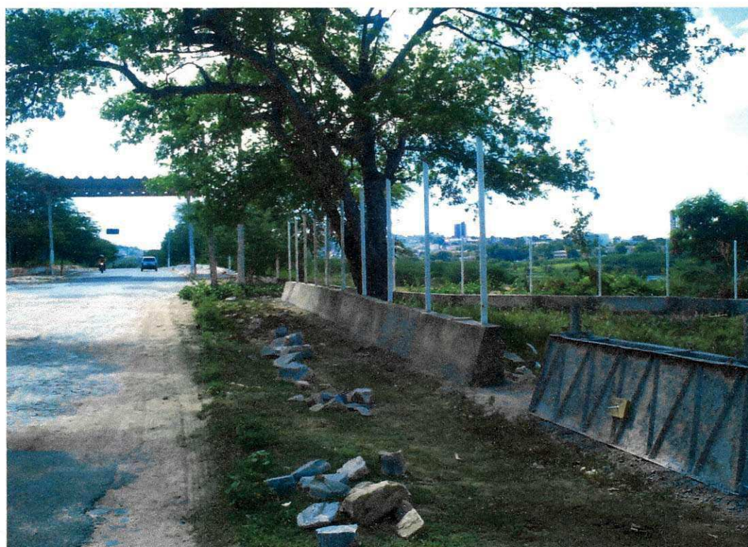
Fig. 17 _ Base concretada já sem a forma.
