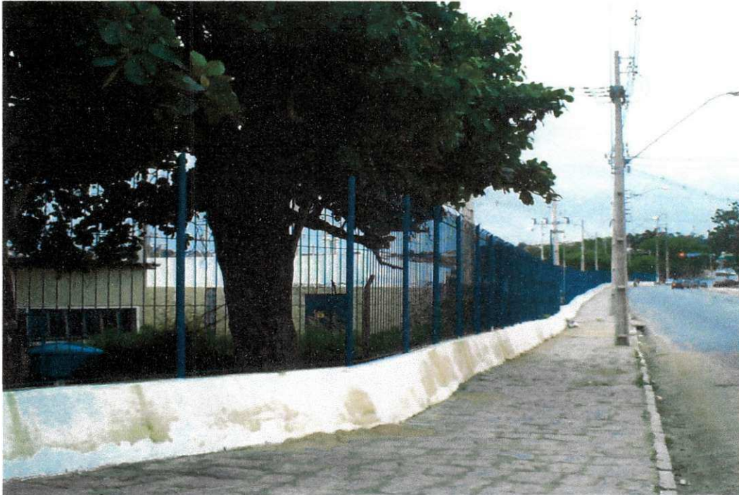
Fig. 20 _ Muretas com as grades montadas e pintadas.
