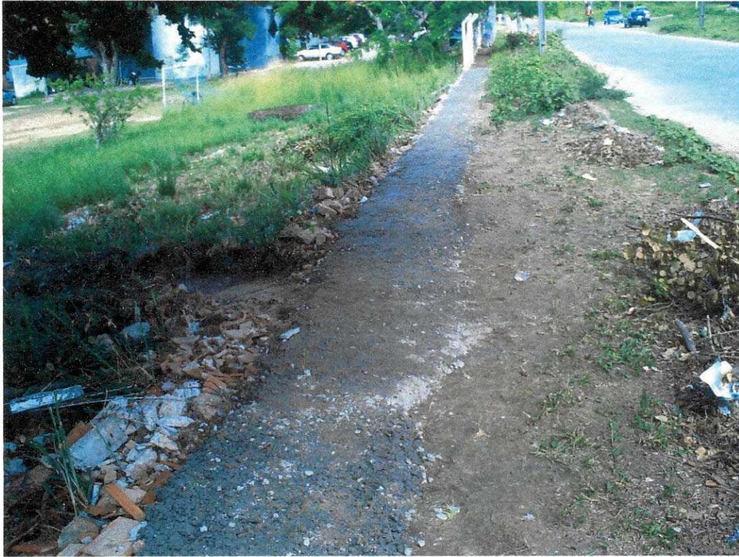
Fig. 12_ Sub-base pronta e regularizada.
