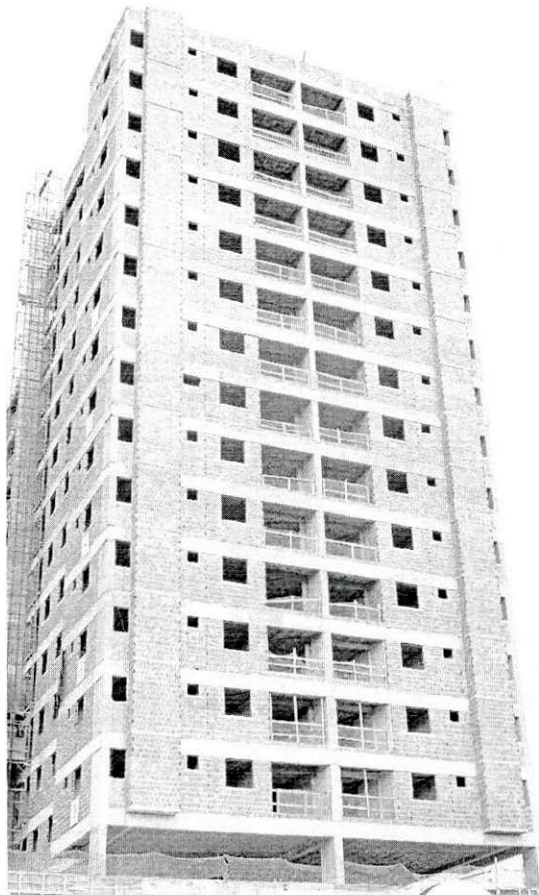
Figura 2 – Fachada leste do condomínio.
