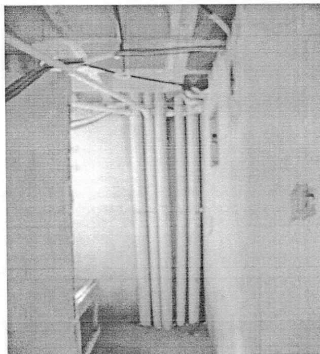
13 Figura 9 - Tubos de queda instalados na área de serviço.
