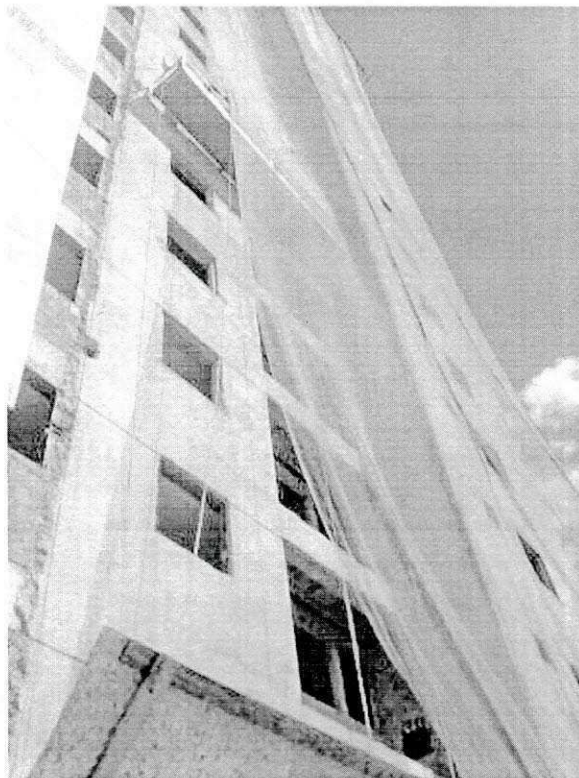
Figura 18 - Revestimento da fachada.
