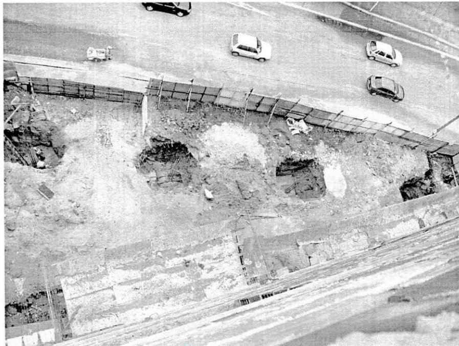
4 Figura 2 - Escavações das sapatas. ?
