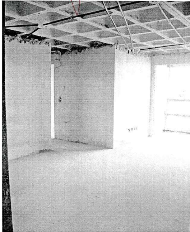
Figura 14 12 - Revestimento interno (Emboço). 7
