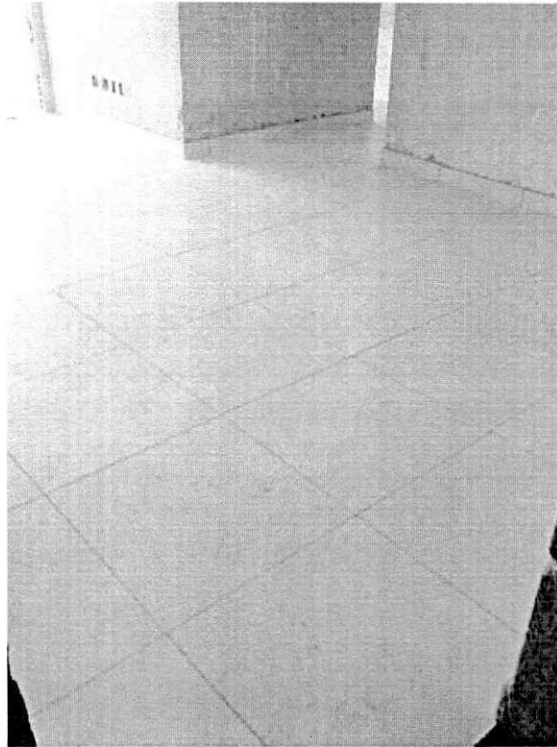
Figura 13 - Assentamento de porcelanato. ?
