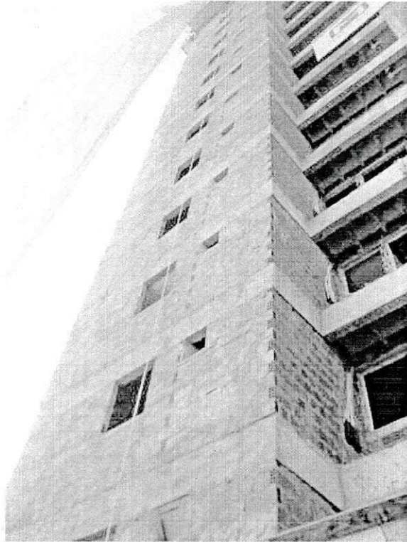
Figura 17 - Chapisco da fachada.
