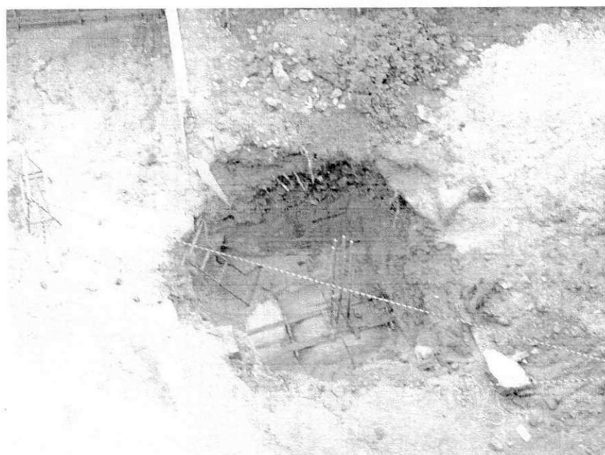
5 Figura 3 - Sapata concretada e pescoço de pilar. 5-
