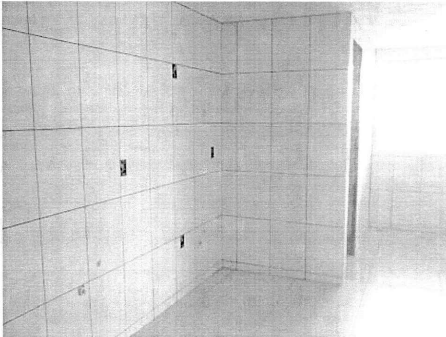
17 Figura 18 - Revestimento cerâmico das paredes internas.
