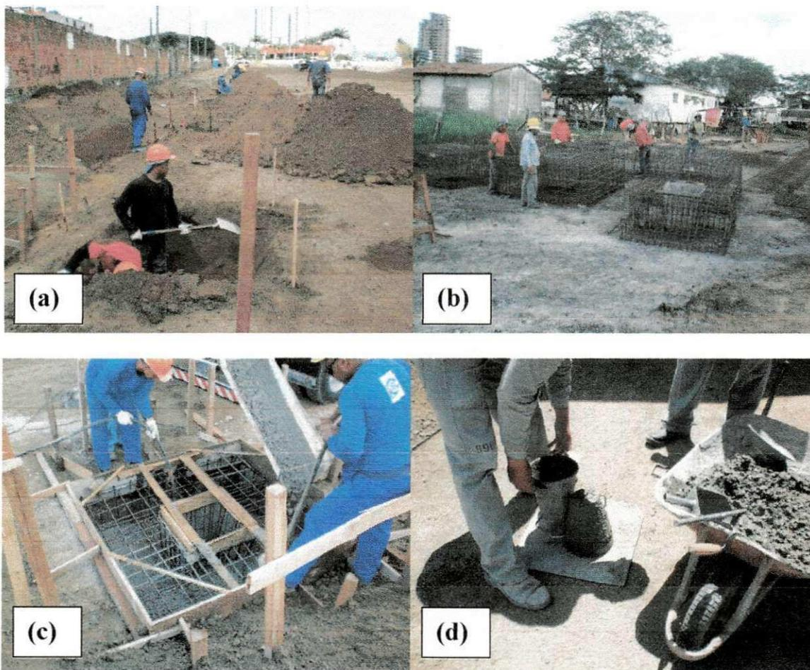
FIGURA 3 (a), (b), (c) e (d) – Execução da sapata isolada (bloco) (c)
