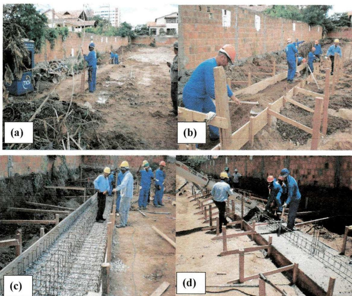
FIGURA 2 (a), (b), (c) e (d) – Execução da sapata corrida do muro de fechamento
