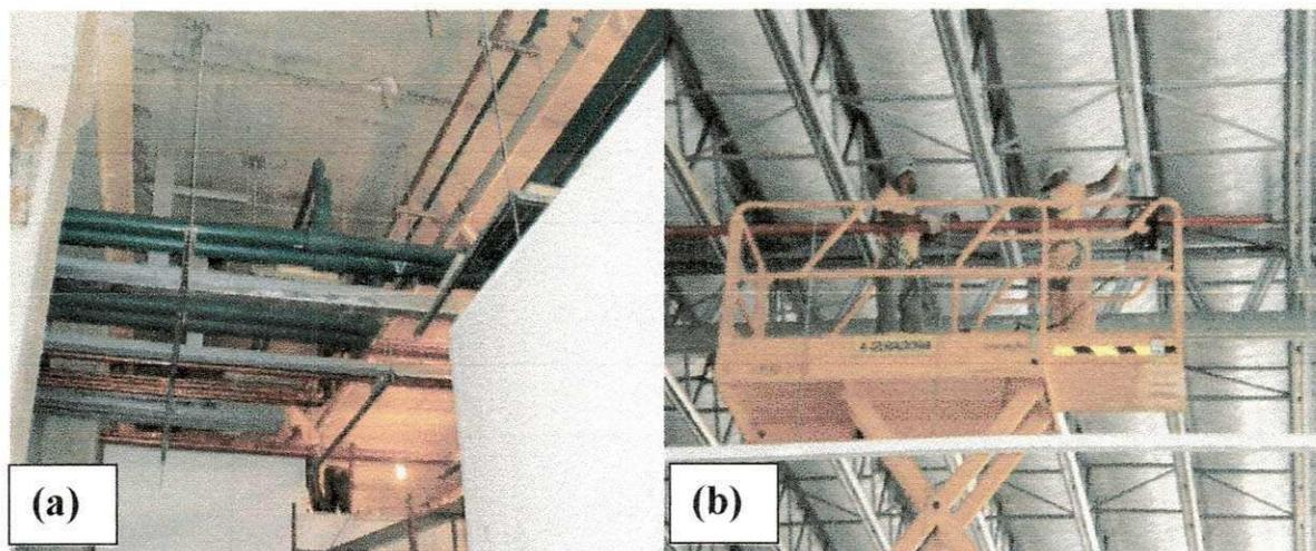
FIGURA 11(a) e (b) – Execução da tubulação refrigeração e hidrantes
