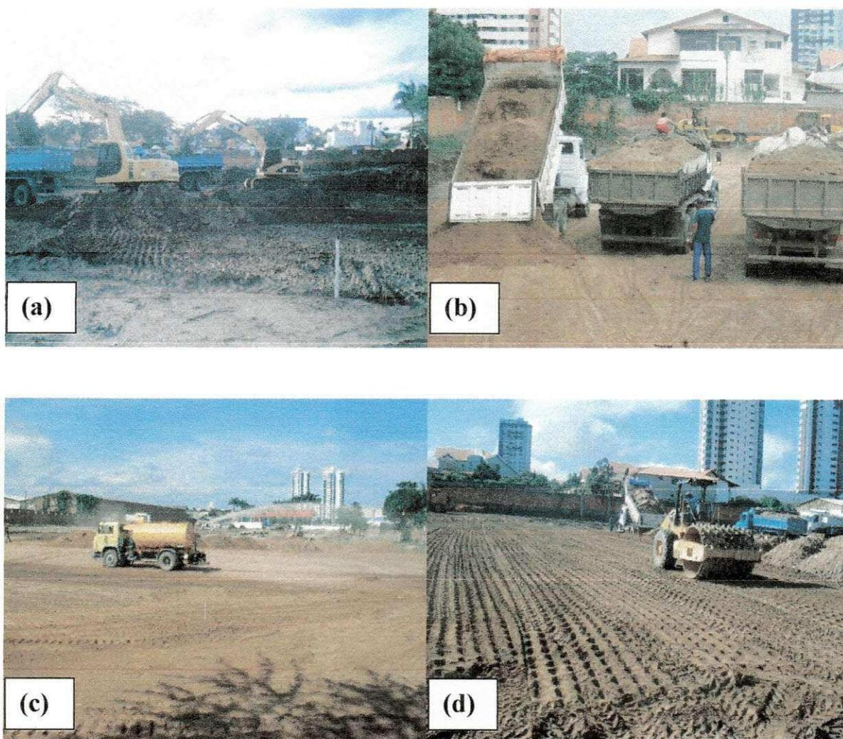
FIGURA 1 (a), (b), (c) e (d) – Execução da terraplenagem.
