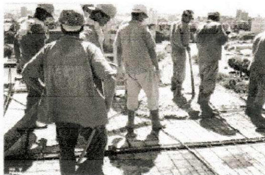
Fig 7.2.1.c Colocação dos elementos pré-moldados Lançamento do concreto
