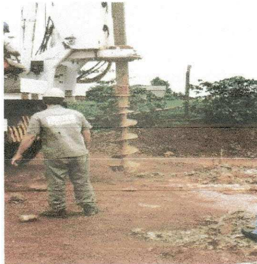
Detalhe do elemento de escavação.
