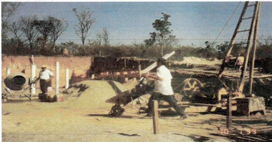
Execução de estaca Strauss.
