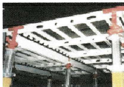
Figura 7.2.3.c e 7.2.3.d Laje nervurada formada por lajes pré-fabricadas com incorporação de blocos de isopor (cortesia lajes Anhanguera) e estrutura de cimbramento de alumínio (cortesia Peri)
