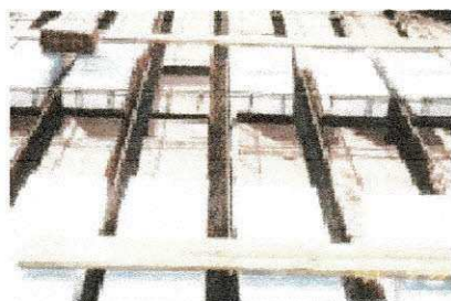
Figura 7.2.3.c e 7.2.3.d Laje nervurada formada por lajes pré-fabricadas com incorporação de blocos de isopor (cortesia lajes Anhanguera) e estrutura de cimbramento de alumínio (cortesia Peri)
