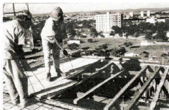
Fig 7.2.1.c Colocação dos elementos pré-moldados Lançamento do concreto
