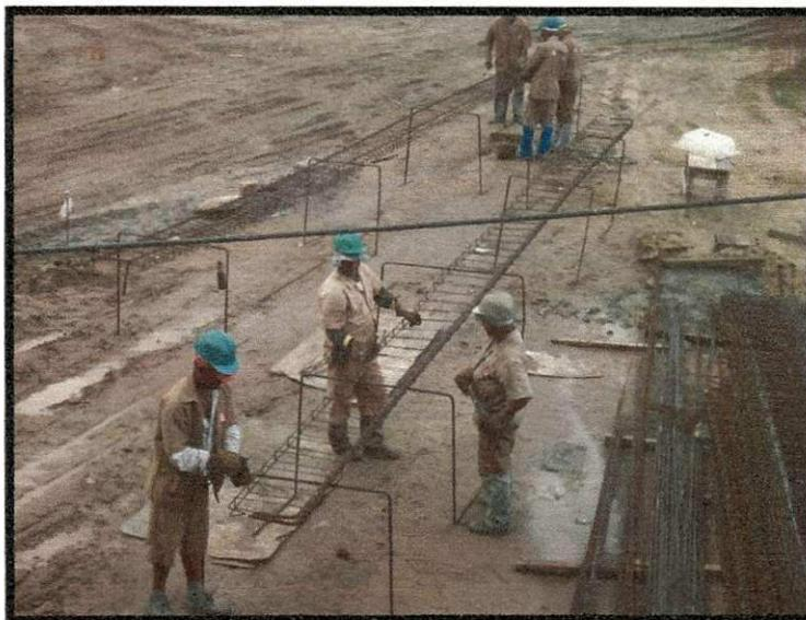
**Figura 10 Montagem das armaduras.**
