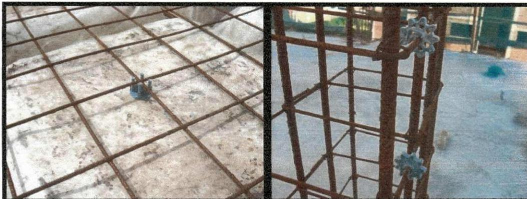
**Figura 13 Espaçadores de pilares e lajes.**
