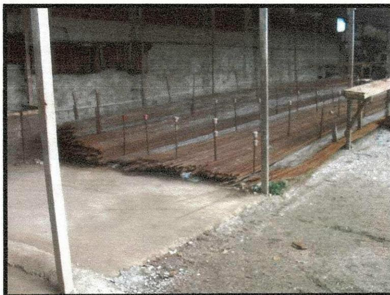
**Figura 28 Armazenamento das barras de aço.**
