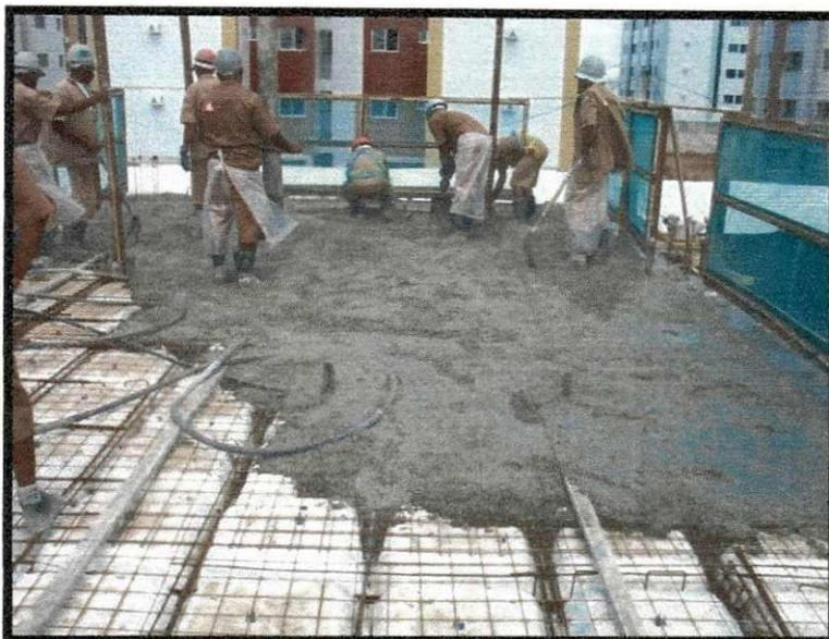
**Figura 21 Acabamento do concreto.**
