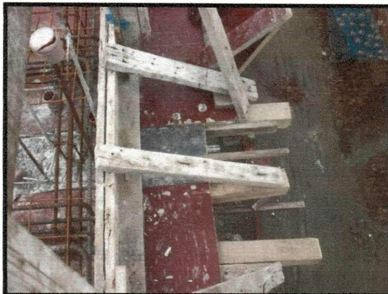
**Figura 18 Lateral da forma da laje.**
