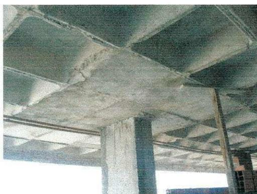
Foto 8 (Encontro da laje nervurada com o pilar)
