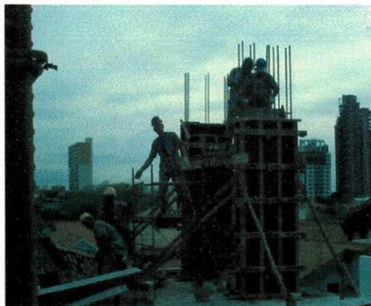
Figura 31 – Lançamento de concreto no pilar
