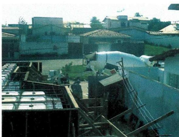
Figura 13 – Fôrma das vigas
