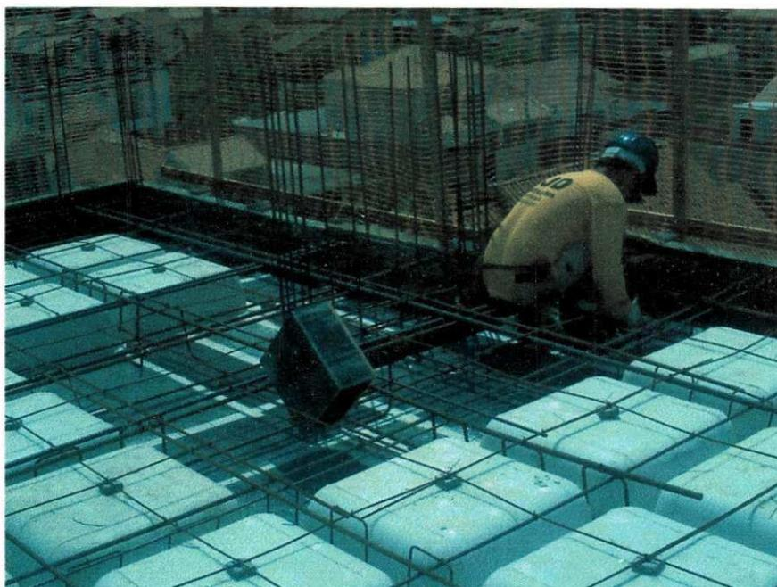
Figura 11 – Montagem da armadura da laje nervurada
