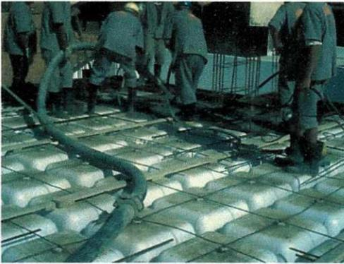
**Figura 34 – Lançamento do concreto**
