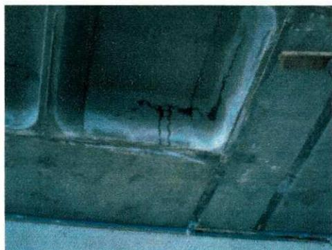
**Figura 39 – Água passando pela fissura de retração**
