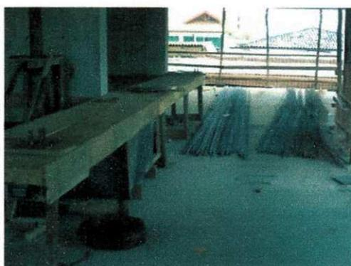
Figura 3 - Armazenamento da ferragem
