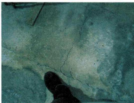
Figura 38 – Fissuras de retração
