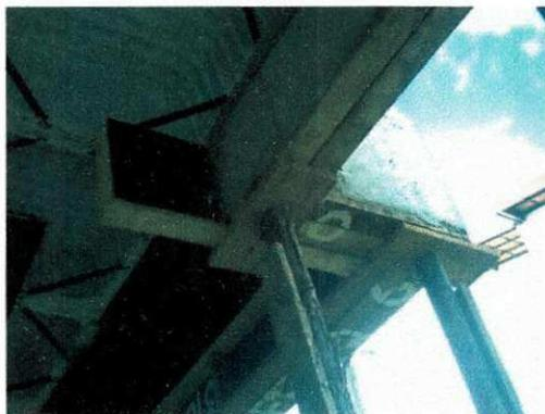
Figura 26 – Preenchimento do encontro entre a viga e a laje com chapa de madeira
