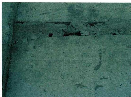
Figura 33 – Armadura exposta
