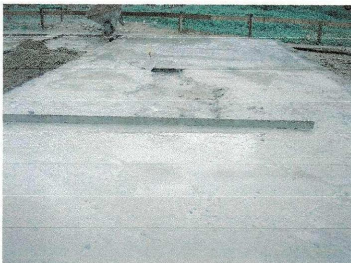
**Figura 40 – Lastro de Concreto**
