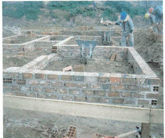
**Figura 36 – Alvenaria de Embasamento**
