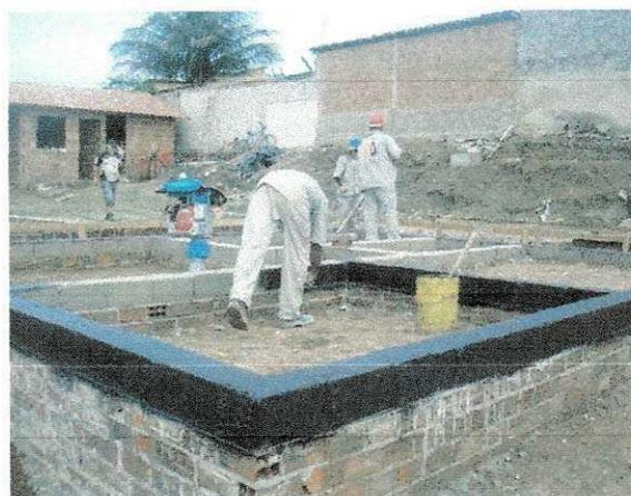
**Figura 38 – Impermeabilização do Respaldo**
