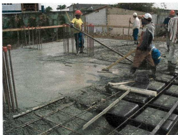
Figura 22 Acabamento da superfície da laje
