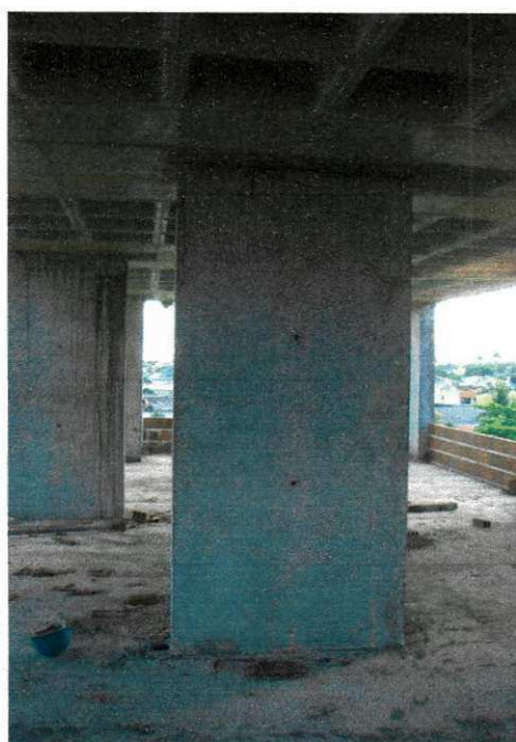
Figura 16 Retirada das fôrmas dos pilares
