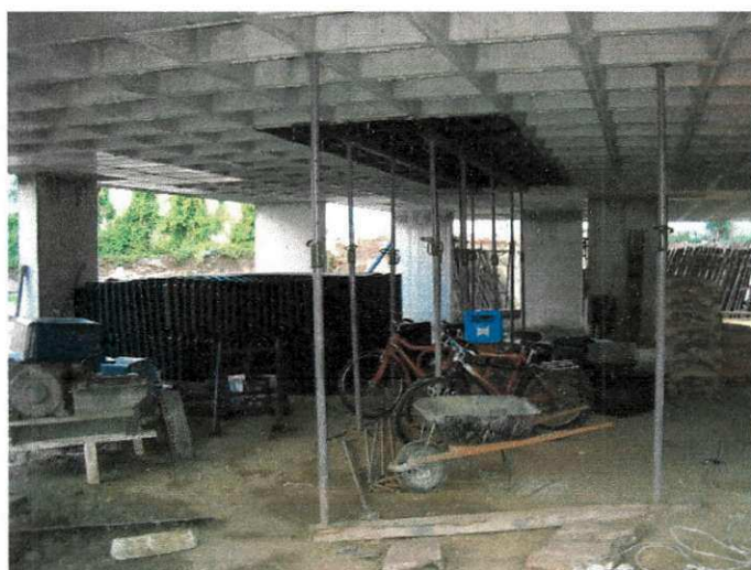
Figura 23 Retirada das fôrmas e escoramentos
