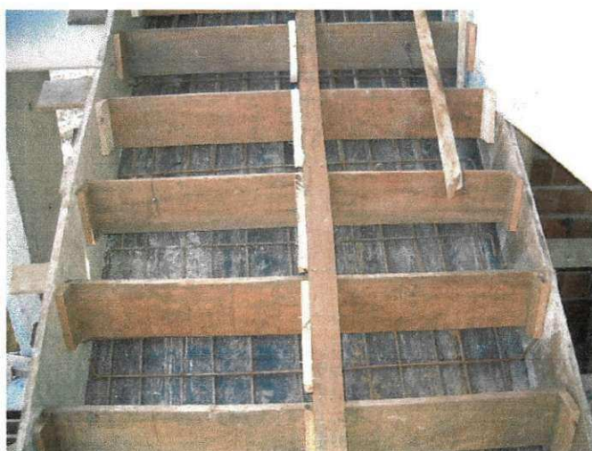
Figura 25 Fôrma da escada
