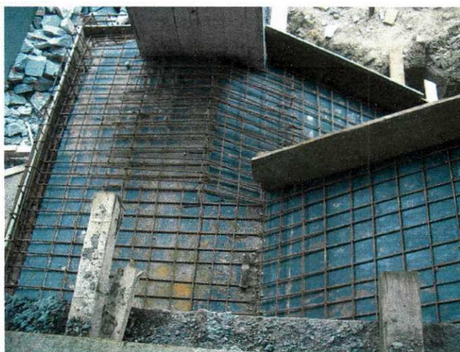
Figura 27 Ferragem concluída das escadas
