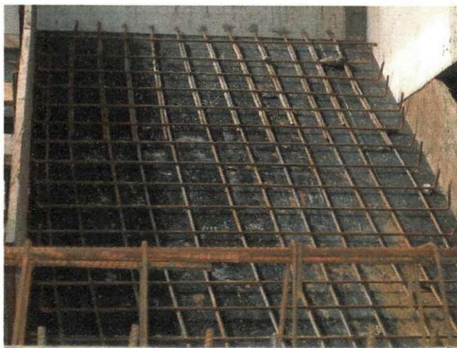
Figura 26 Ferragem das escadas
