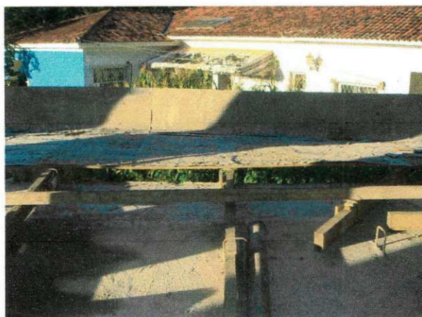
Figura 30 Bandeja de proteção
