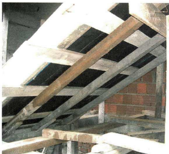
Figura 24 Fundo da fôrma da escada
