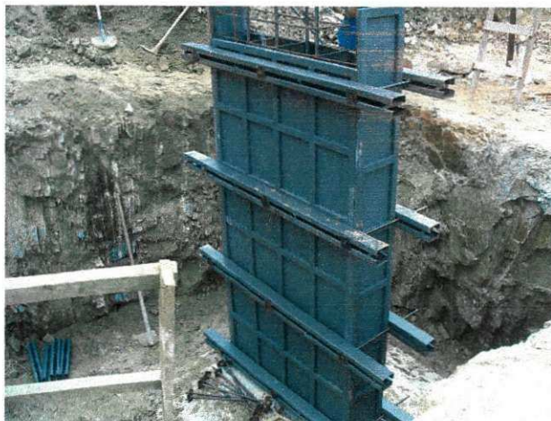
Figura 14 Fôrma dos pilares
