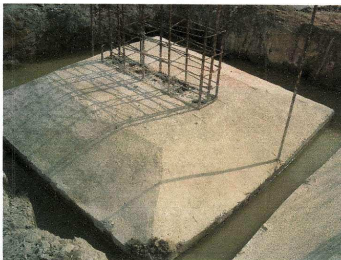
Figura 11 Retirada das fôrmas
