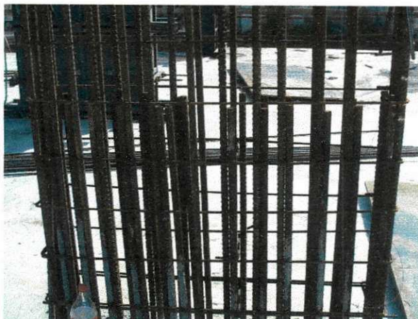
Figura 12 Ferragem dos pilares
