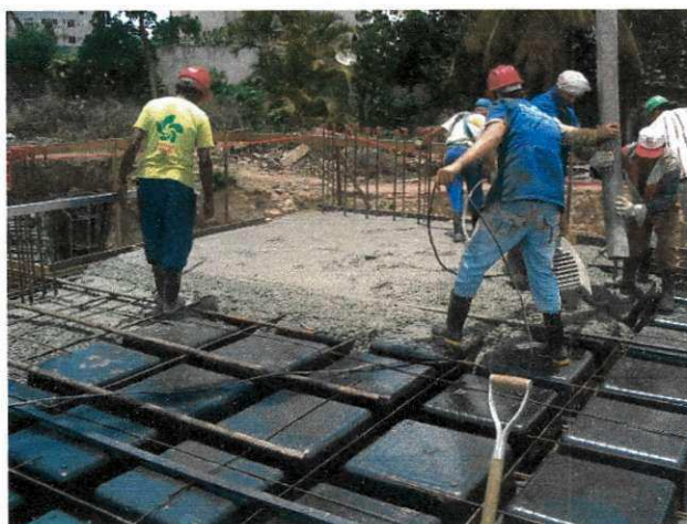
Figura 21 Concretagem das lajes e vigas
