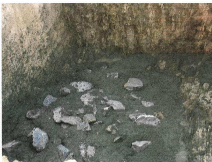
Figura 5 Nivelamento com concreto ciclópico
