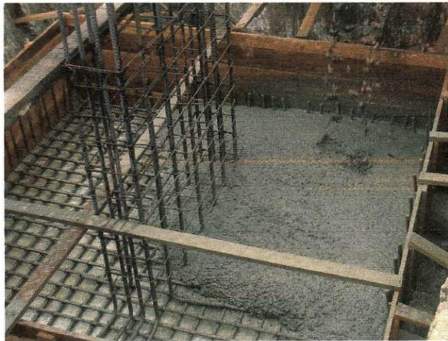
Figura 9 Concretagem das sapatas
