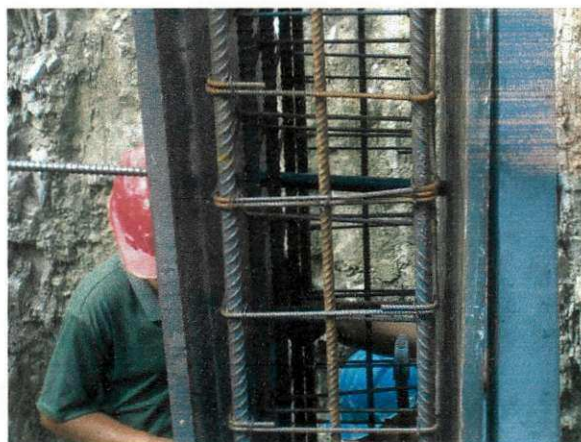
Figura 13 Colocação das fôrmas
