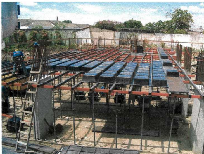
Figura 17 Colocação das fôrmas das lajes
