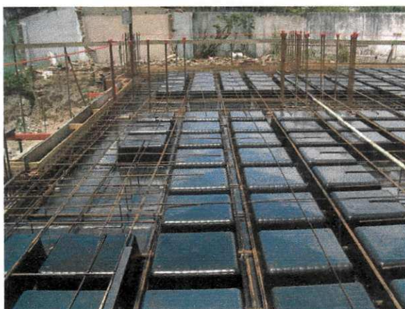
Figura 20 Ferragem das lajes
