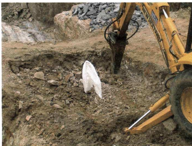
Figura 3 Escavação com Picão
