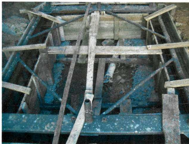
Figura 29 Instalação do elevador de serviço
