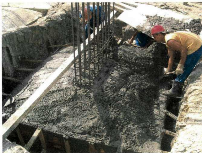
Figura 10 Acabamento das sapatas
