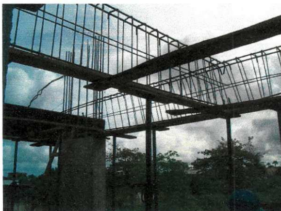
Figura 19 Ferragem das vigas
