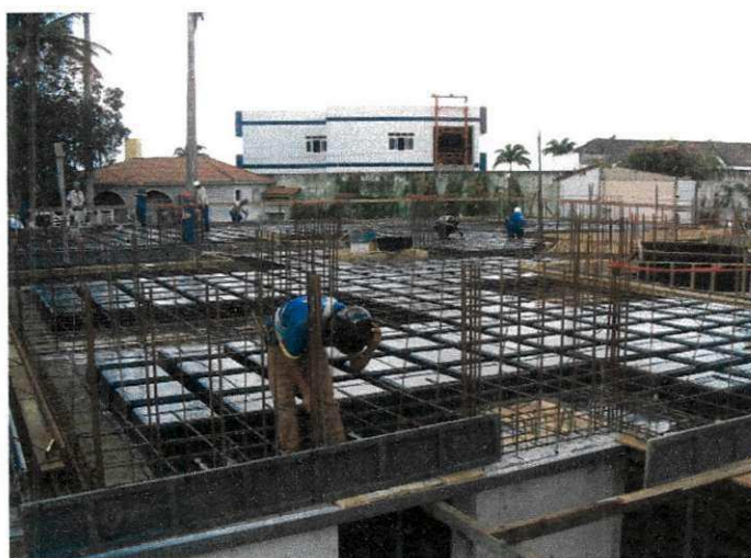
Figura 18 Armação das lajes
