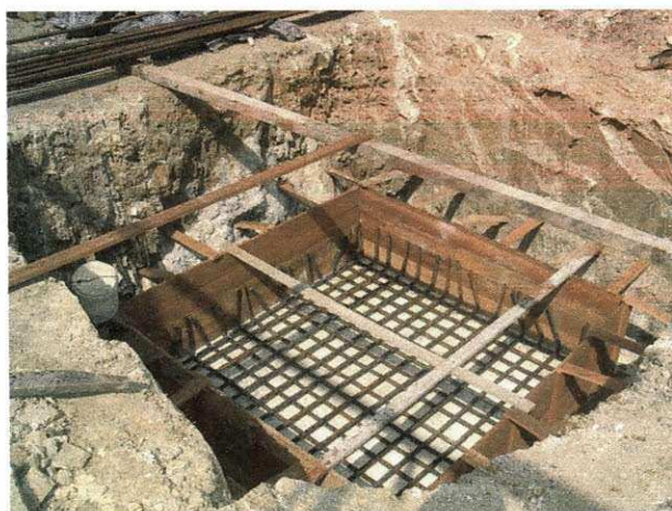
Figura 7 Ferragem das sapatas
