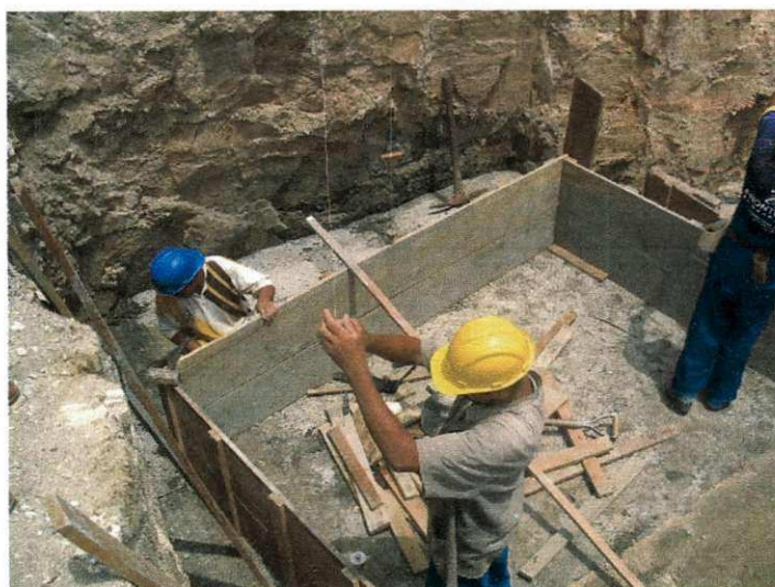
Figura 6 Armação das fôrmas utilizando o prumo piquete
