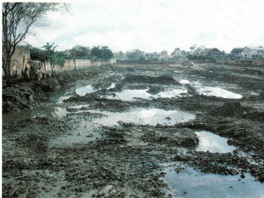
FIGURA 1 – Visão geral de início da obra
