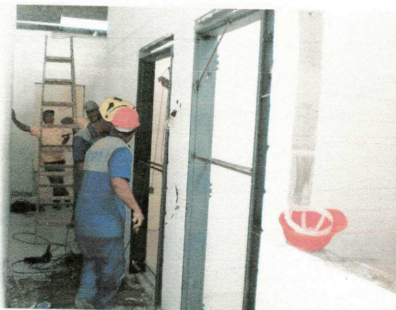
FIGURA 15 – Colocação de esquadrias
