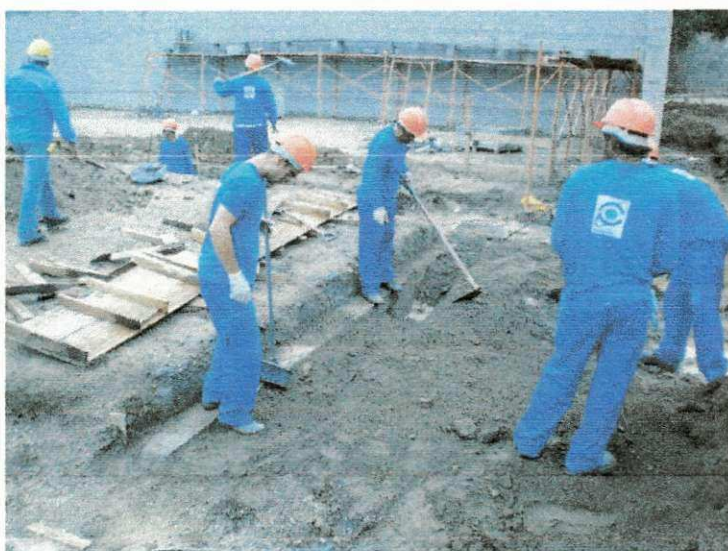
FIGURA 5 (a), (b) e (c) – Execução da viga baldrame
