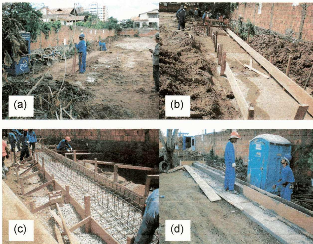
FIGURA 4 (a), (b), (c) e (d) – Execução da sapata corrida
