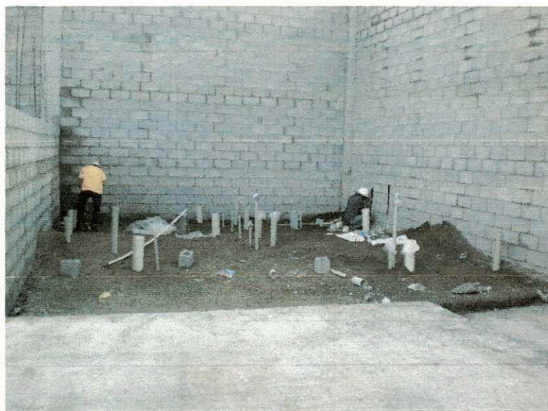
FIGURA 21 – Execução da rede de esgoto e água fria
