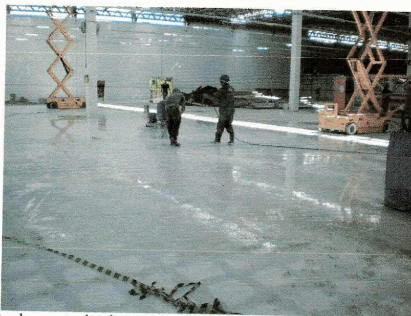
FIGURA 16 – Acabamento do piso
