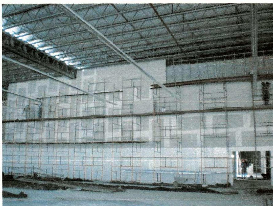
FIGURA 22 – Colocação de bandó e quadro e armação
