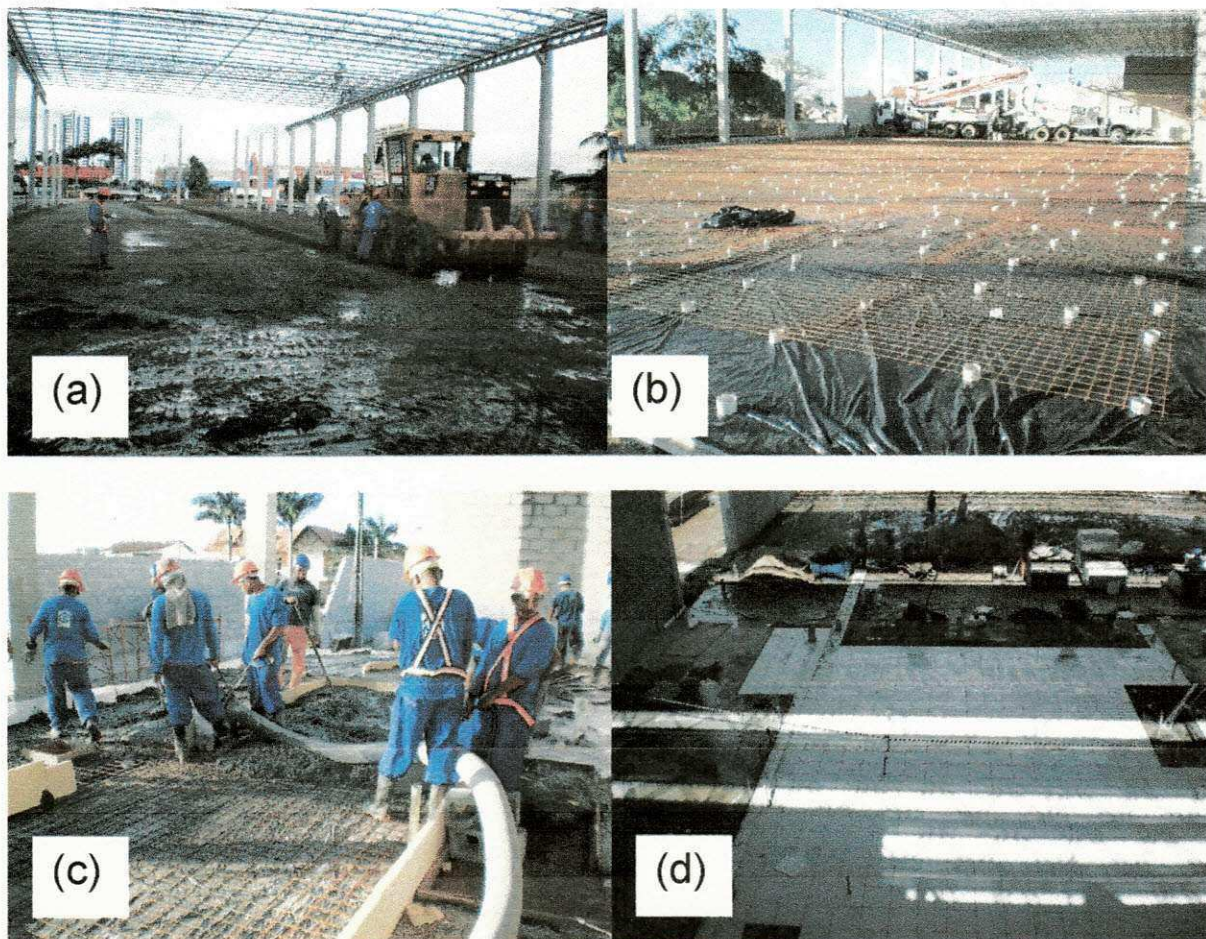
FIGURA 9 (a), (b), (c) e (d) – Execução do piso
