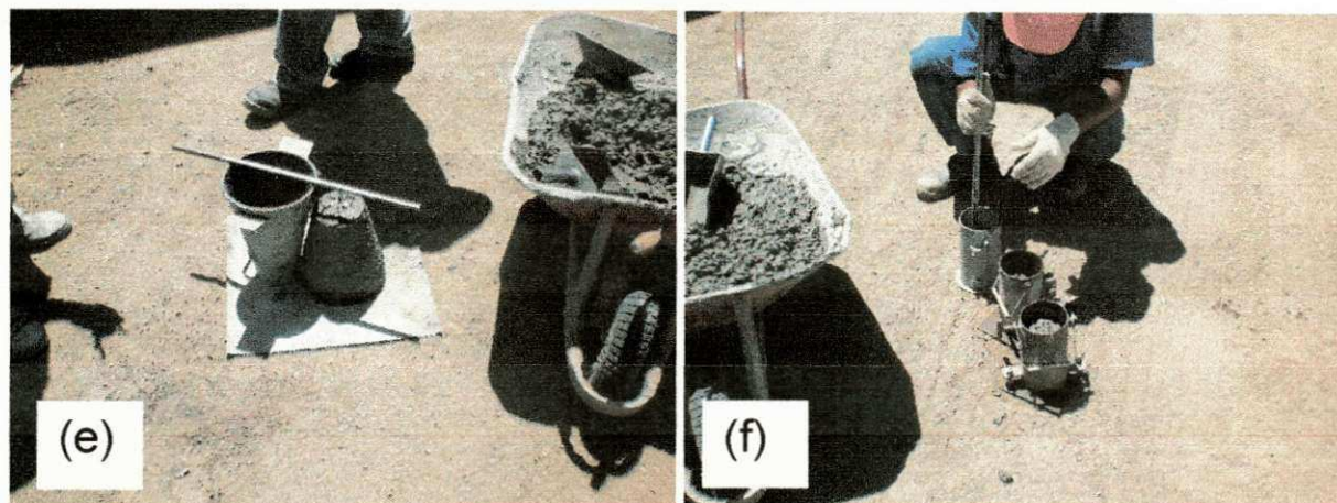
FIGURA 3 (a), (b), (c), (d), (e) e (f) – Execução da sapata isolada (sapata em bloco)
