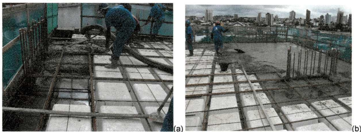
Figura 17 - Concretagem da laje.
