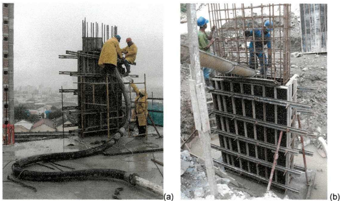
Figura 13 - Concretagem de pilar.
