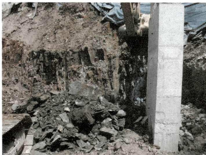
Figura 23 - Escavação para construção de muro de arrimo.
