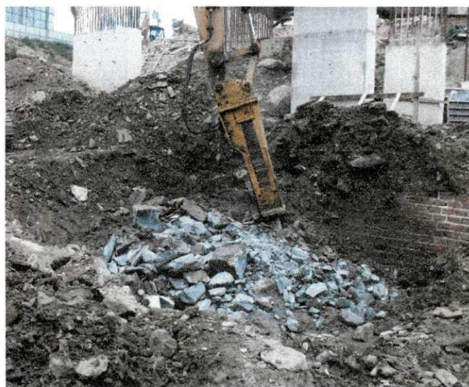
Figura 27 - Desmonte de rocha.
