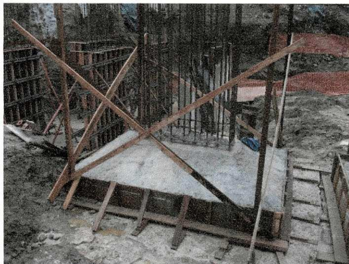
Figura 6 - Sapata concretada.
