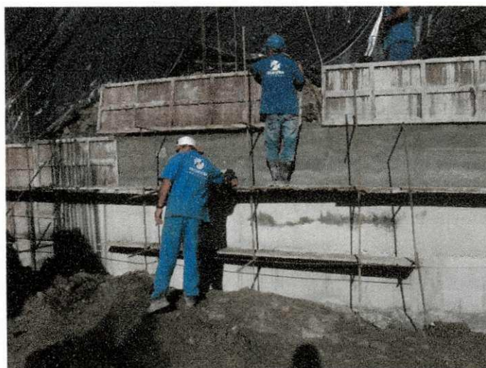
Figura 24 - Muro de arrimo.
