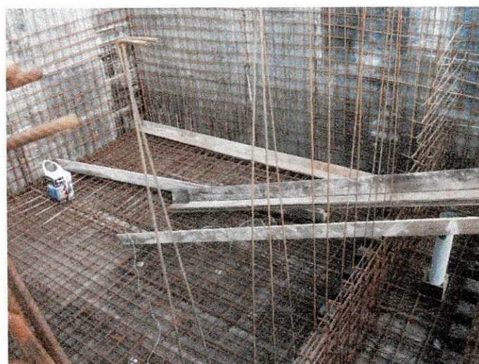
Figura 22 - Armação do fundo da caixa d'água.
