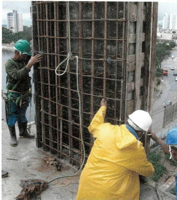
Figura 11 - Fechamento fôrma de pilar.
