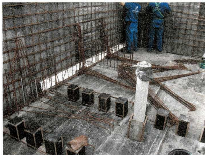
Figura 21 - Ferragem da Caixa d'água.
