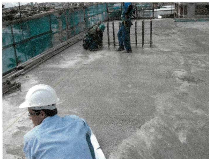
Figura 10 - Medição das posições dos pilares.
