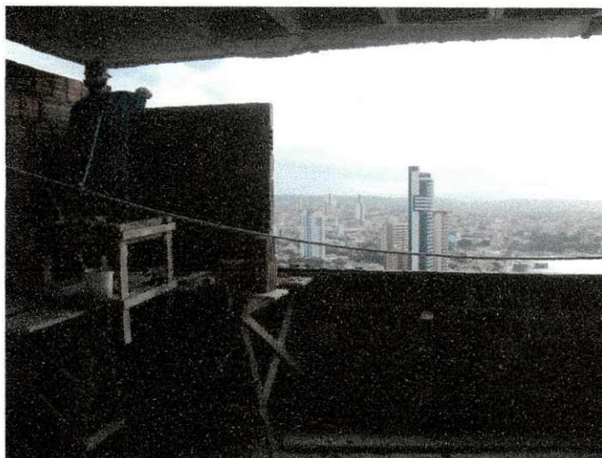
Figura 28 - Assentamento de alvenaria de fechamento.
