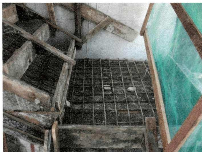
Figura 20 - Armação e fôrma do patamar da escada.
