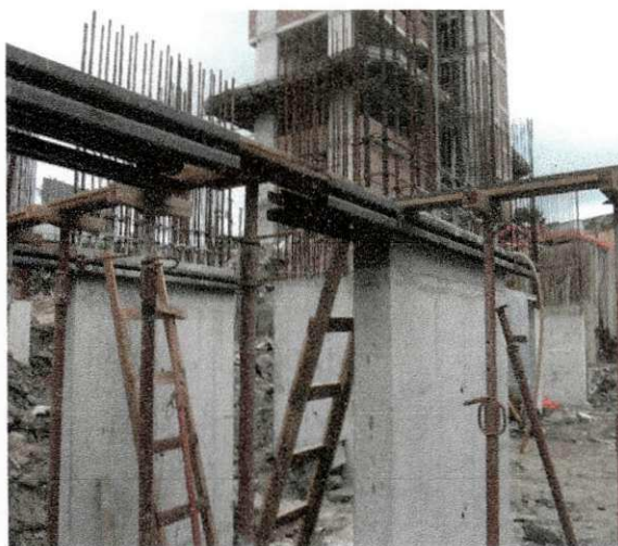
Figura 15 - Execução de fôrmas de vigas.
