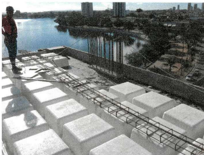
Figura 14 - Colocação de vigas.
