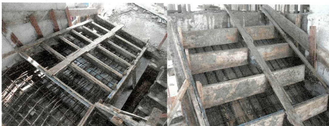
Figura 19 - Armação e fôrma dos degraus da escada.
