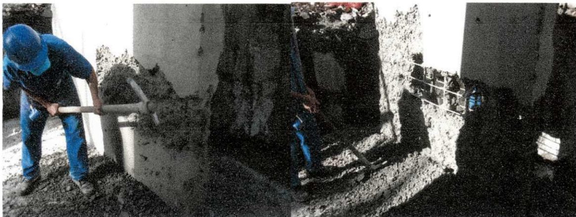
Figura 34 - Demolição dos pilares.
