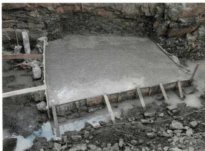
Figura 7 - Camada de regularização.
