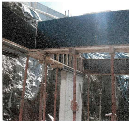
Figura 15 - Execução de fôrmas de vigas.
