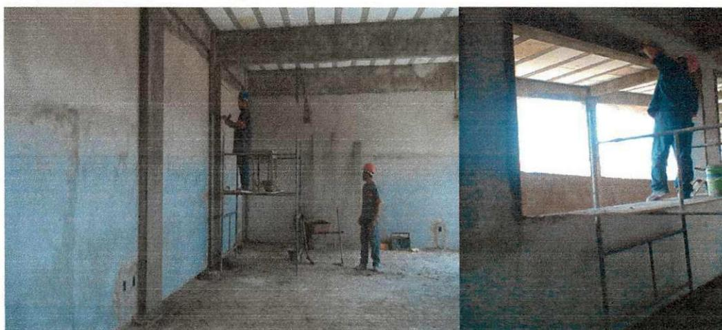
**Figura 28: Acabamento fino – Capição dos pilares e janelas**
