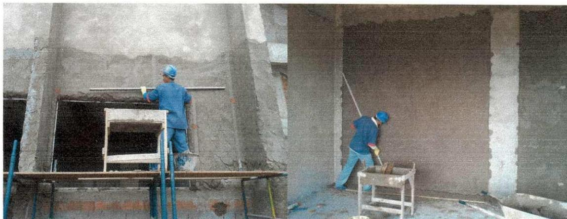
**Figura 27: Sarrafeamento dos panos de alvenaria**
