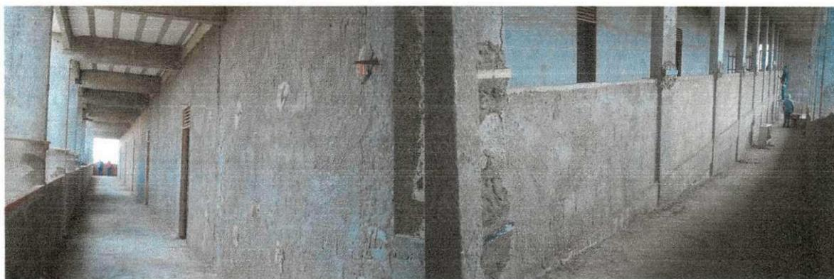
Figura 25 - Emestramento para aplicação do reboco
