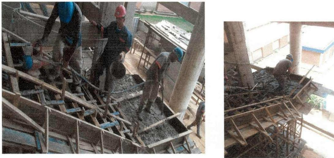
**Figura21 - Utilização do vibrador na concretagem da escada**
