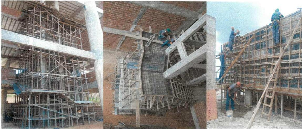
**Figura20 - Escoramento das escadas e do reservatório**
