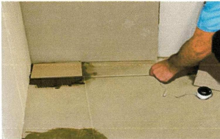
Figura 9: Marcação do esquadro do revestimento cerâmico
