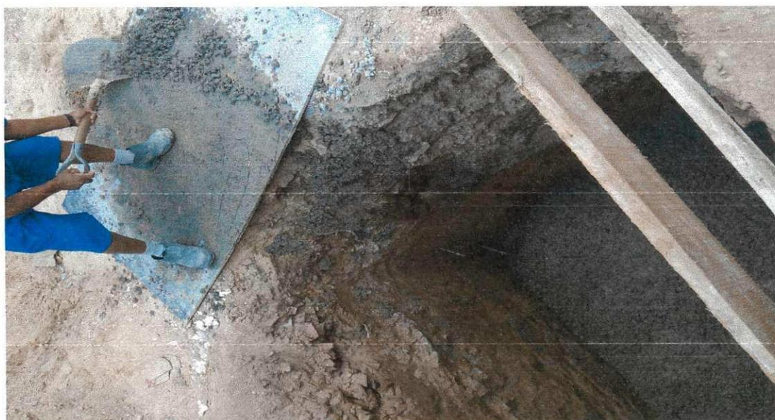
Figura 13: Aplicação do concreto para nivelamento da fundação
