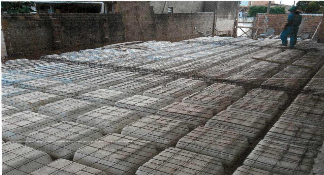
Figura 25: Armadura da Laje Nervurada
