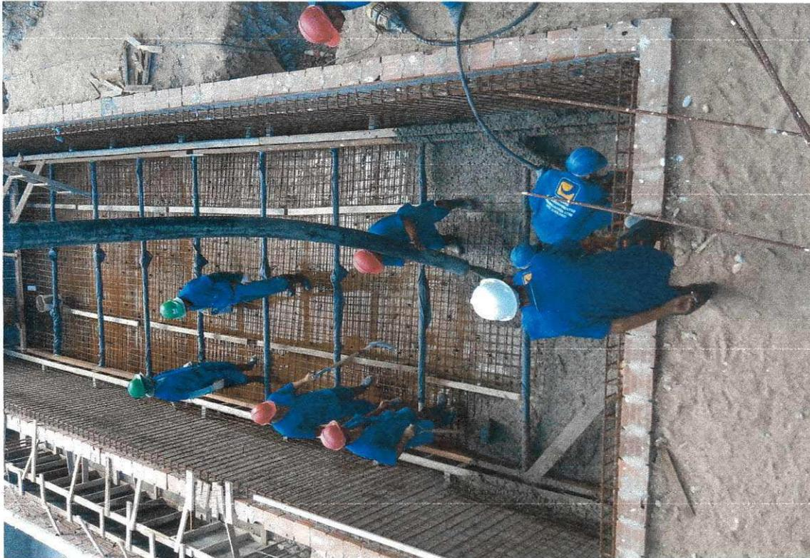
Figura 20: Concretagem do Reservatório da Torre A.
