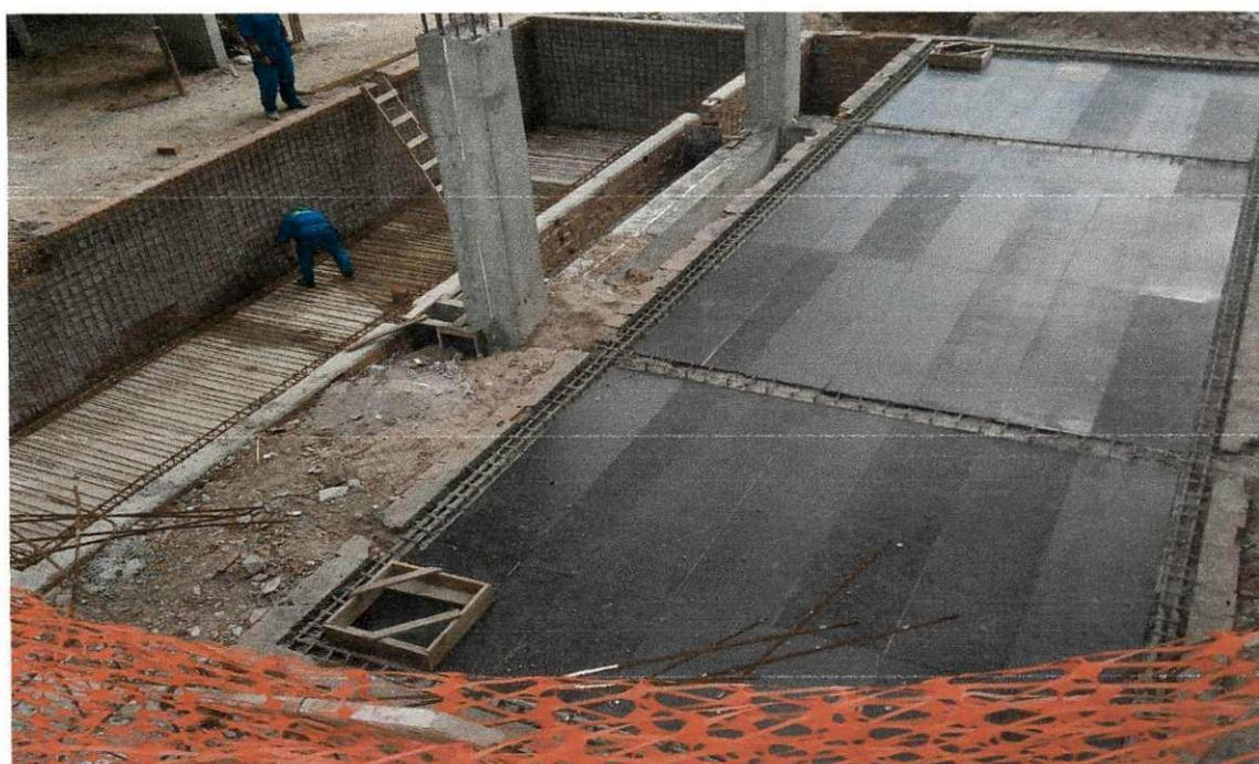
Figura 23: Localização do assoalho para instalação das Ferragens da Tapa do Reservatório da Torre A.
