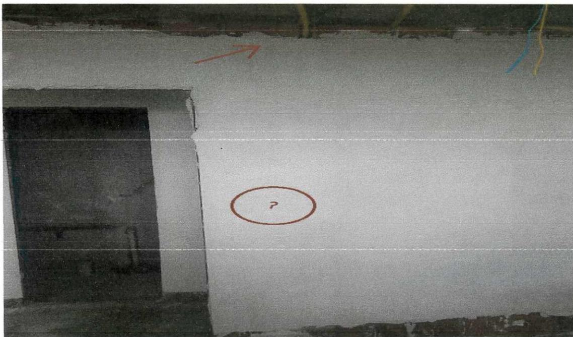
Figura 47: Falha do serviço Revestimento de Gesso
