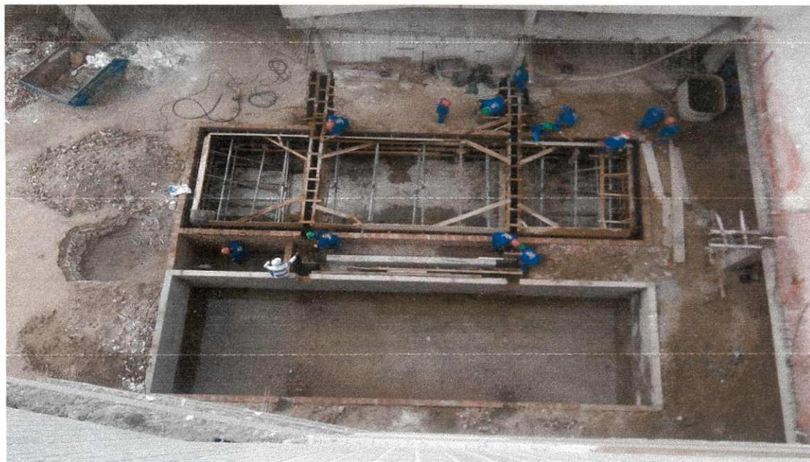
Figura 22 Reservatório da Torre A pronto para a Concretagem das suas Laterais e Vigas Baldrames montadas.
