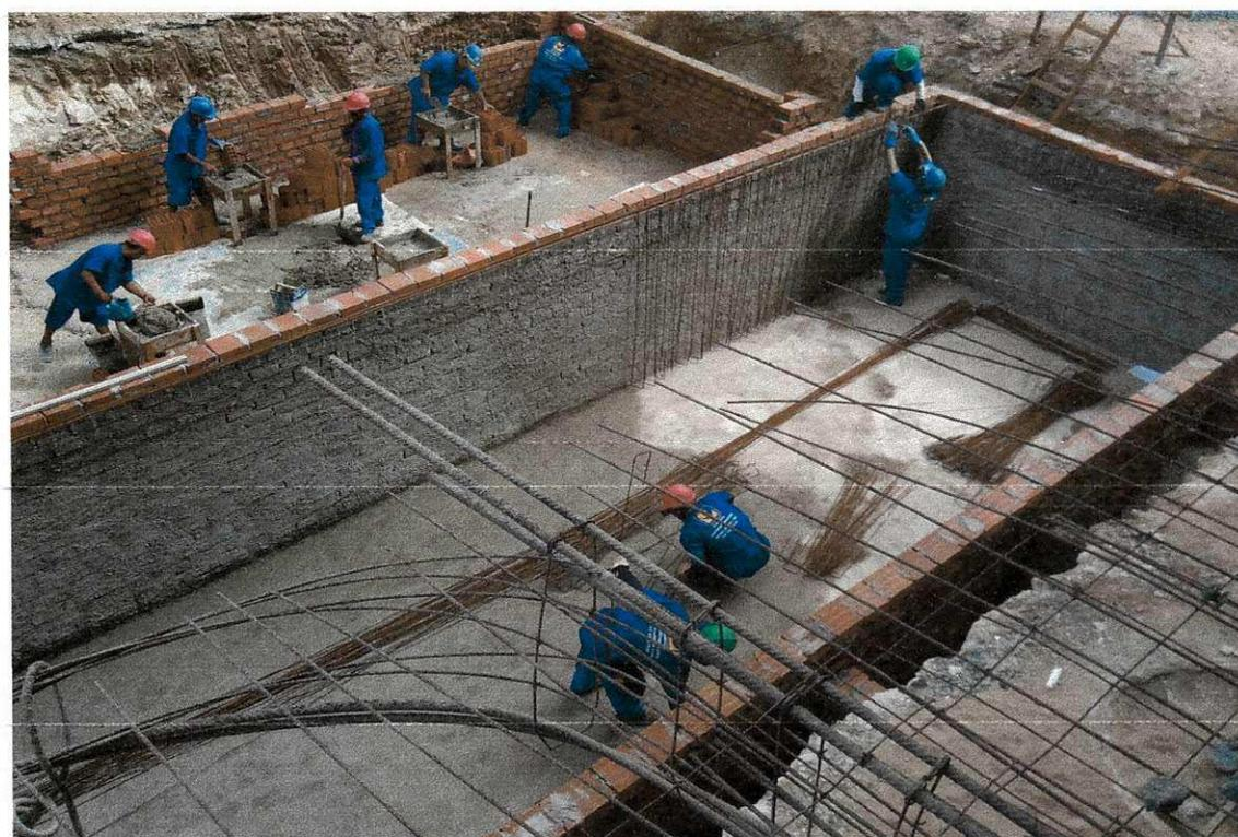
Figura 19: Alvenaria de Vedação e Início de Aplicação das Ferragens.
