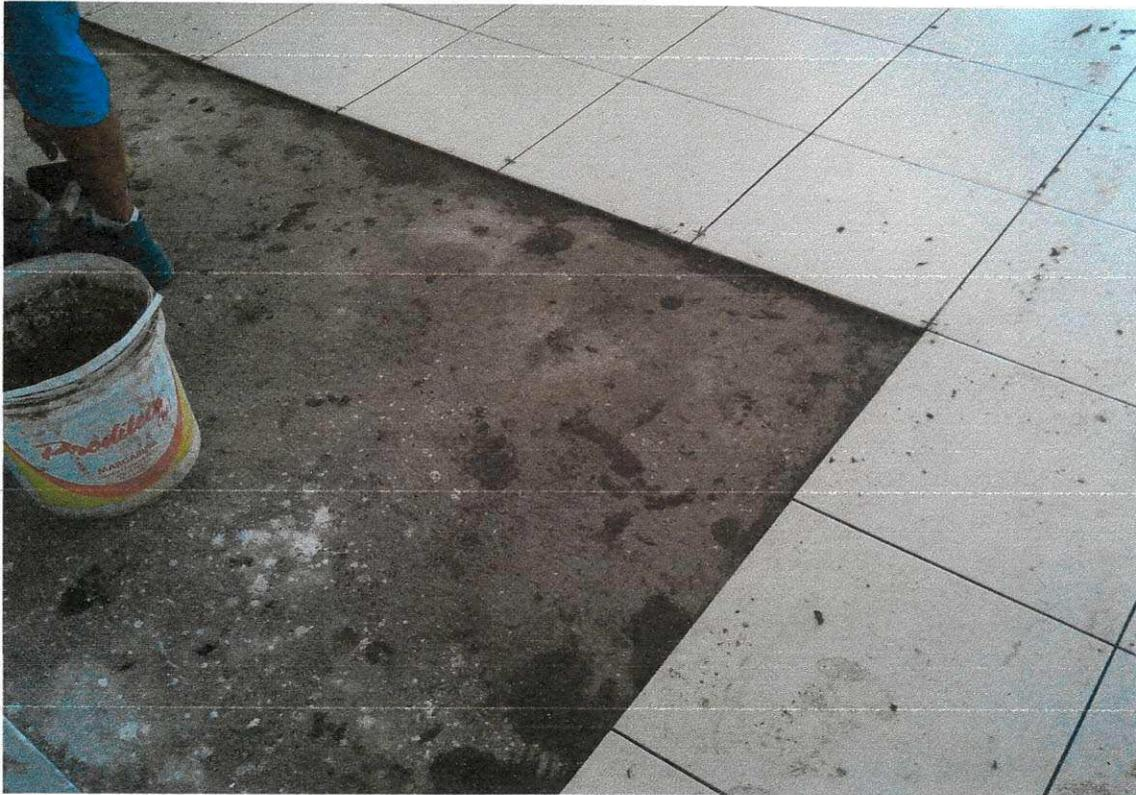
Figura 33: Contrapiso umedecido para receber o revestimento cerâmico
