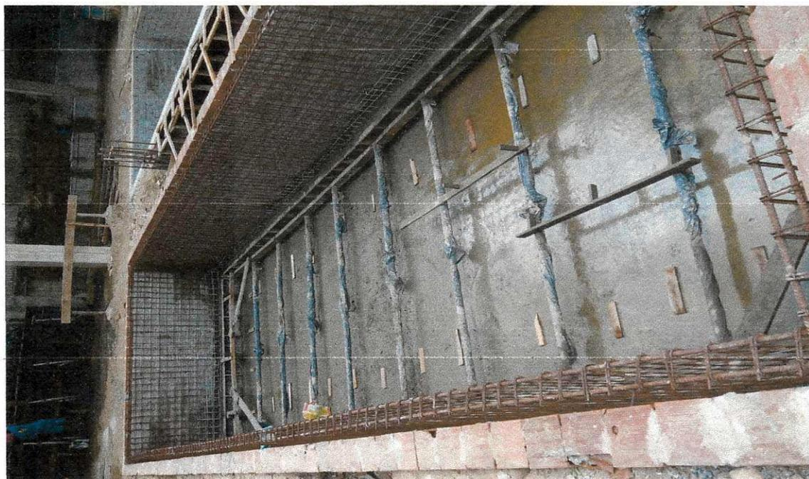
Figura 21: Base do Reservatório Concretado.
