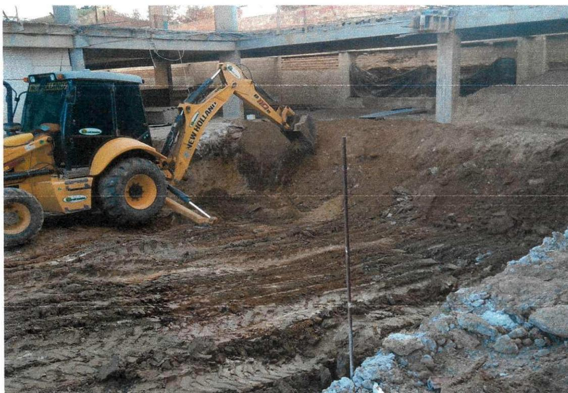
Figura 15: Escavação do Terreno para instalação dos Reservatórios Inferiores
