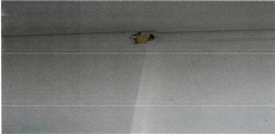
Figura 52: Conduíte Exposto após o Revestimento de Gesso
