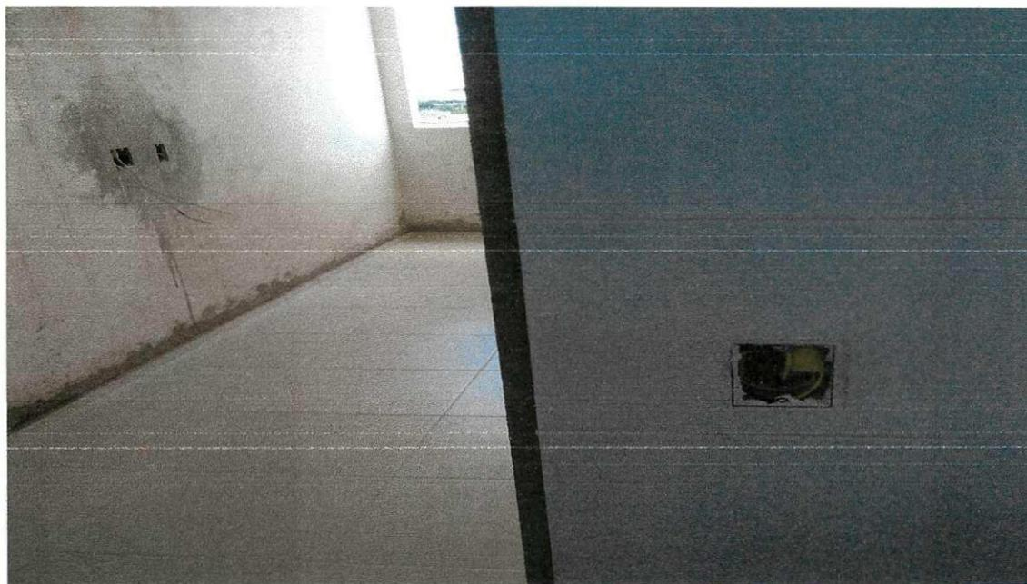
Figura 50: Revestimento com falha de recobrimento da parede.
