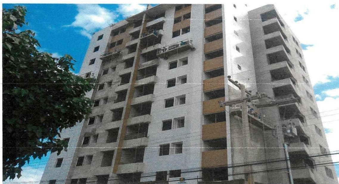
Figura 43: Aplicação das Pastilhas na Fachada Leste e Norte - A
