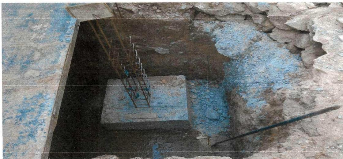
Figura 14: Sapata Concretada e Pescoço do Pilar
