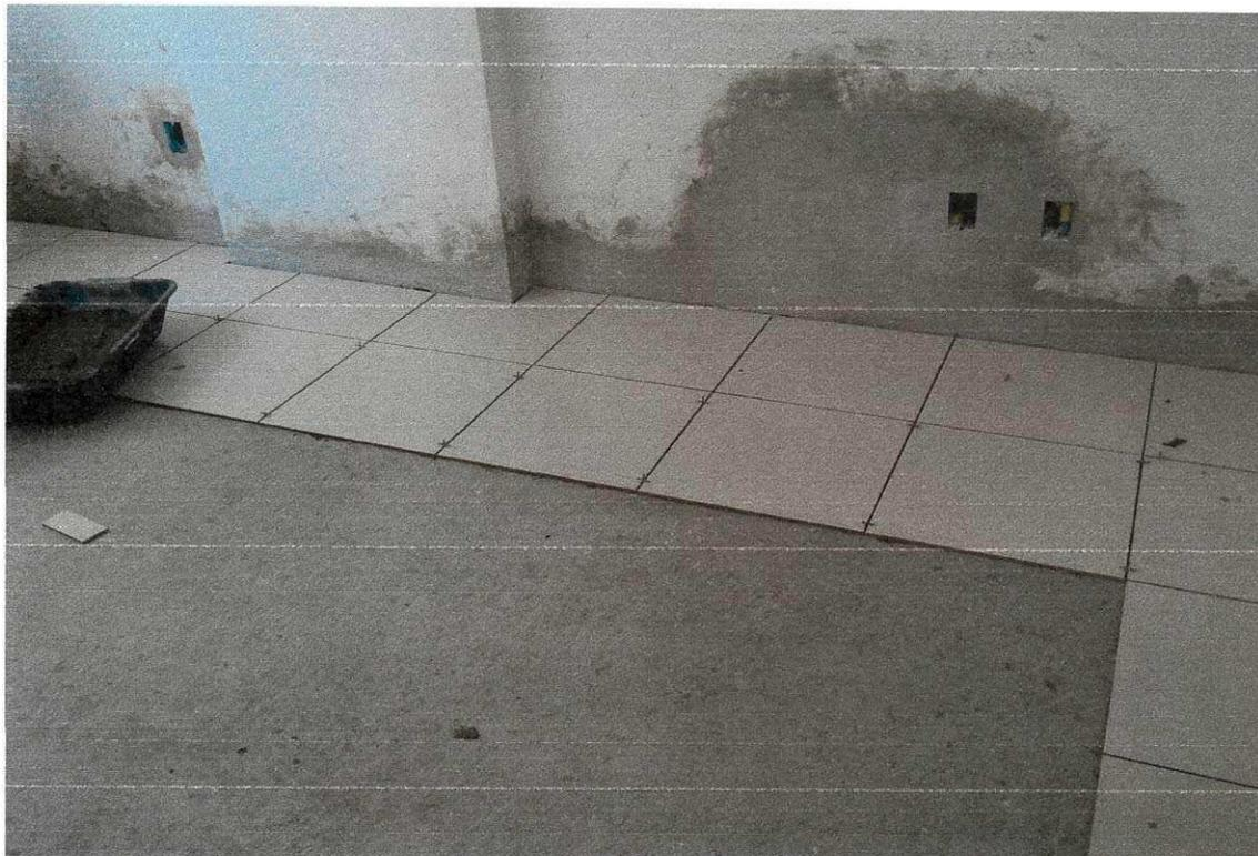
Figura 35: Cerâmica com aplicação dos espaçadores
