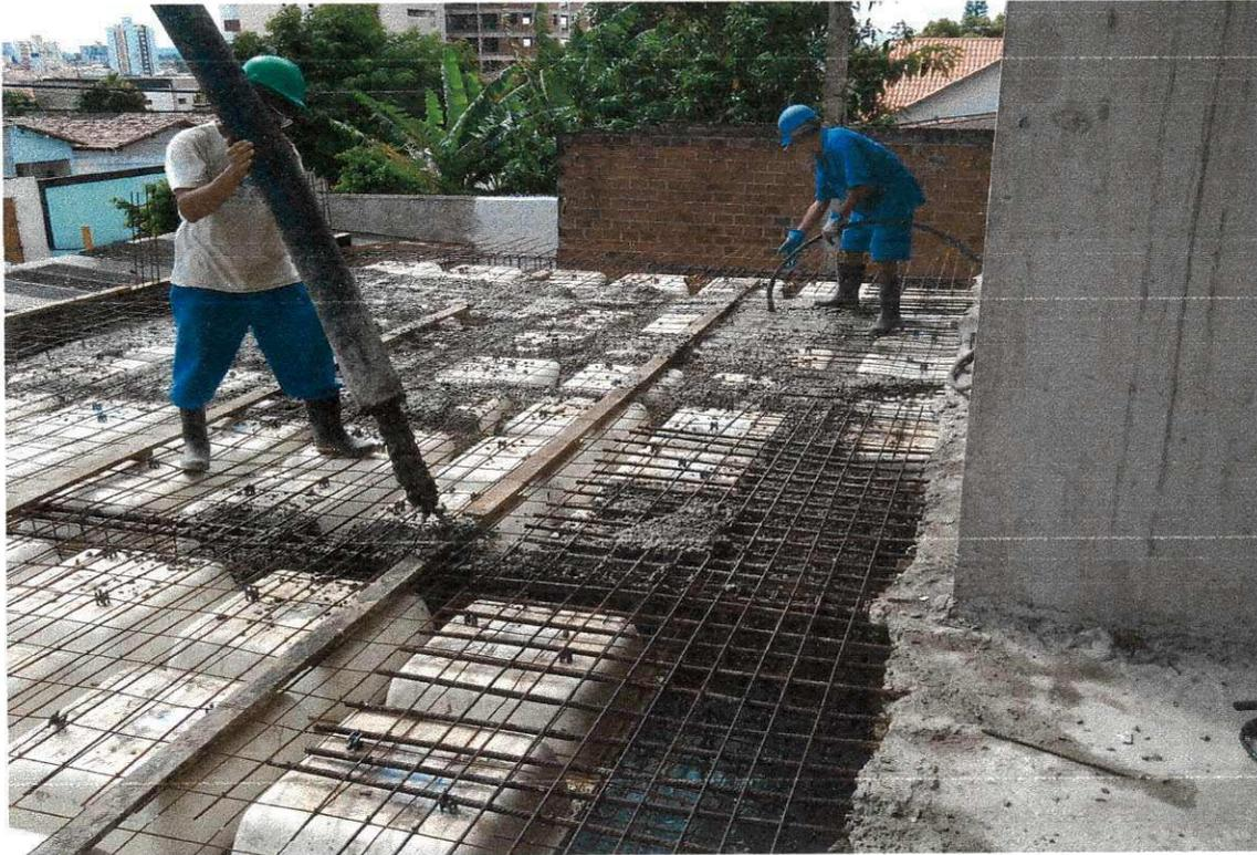
Figura 26: Concretagem da Parte Maciça da Laje
