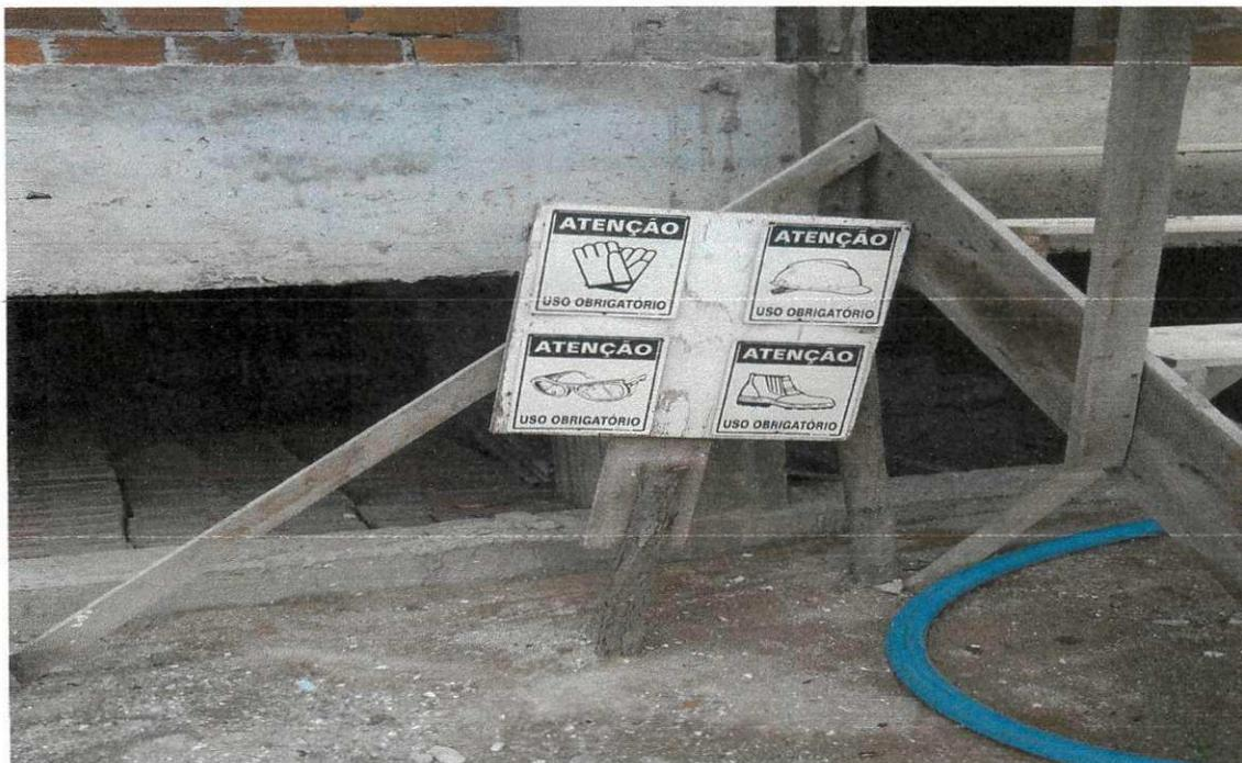
Figura 44: Placa de EPI's Obrigatórios na Obra
