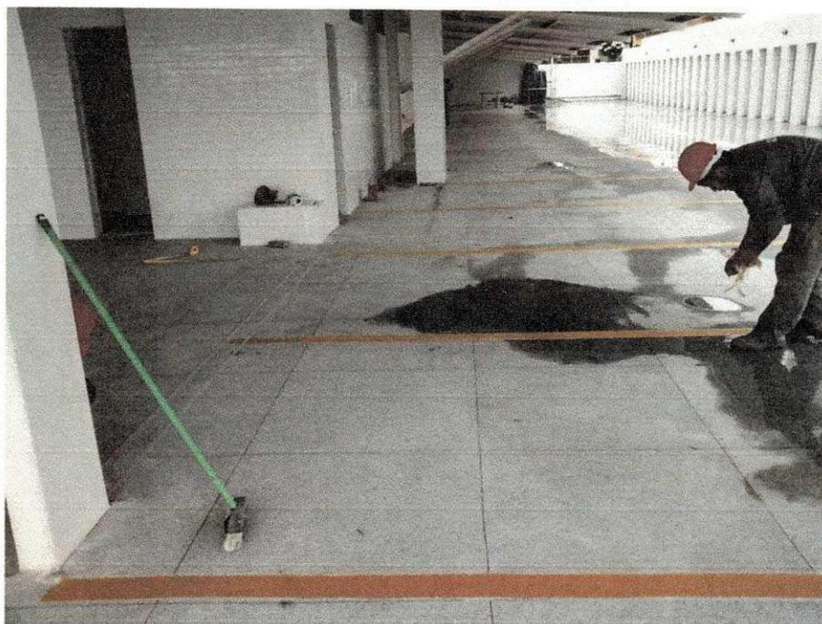
Figura 23 - Demarcação das vagas de garagem.
