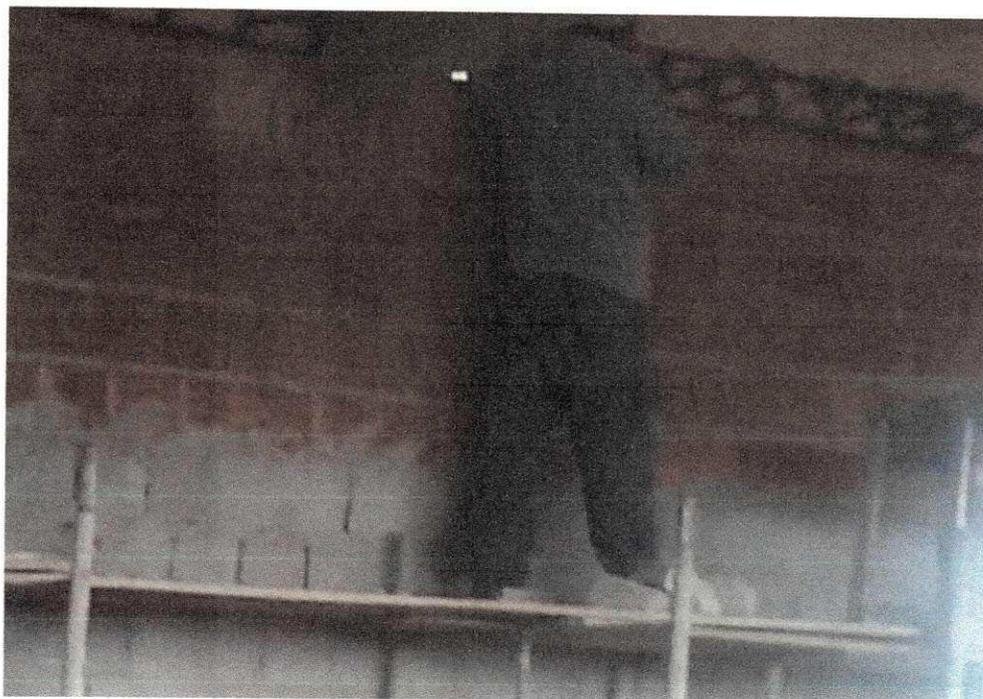
Figura 14 - Assentamento de cunhas na parte superior da alvenaria (encunhamento).
