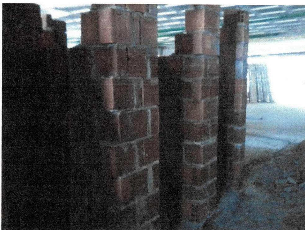
Figura 15 - Alvenaria dos depósitos, no subsolo.
