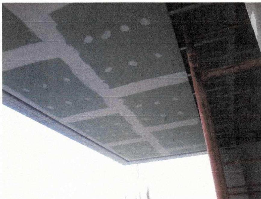
Figura 29 - Forro de gesso acartonado em execução.
