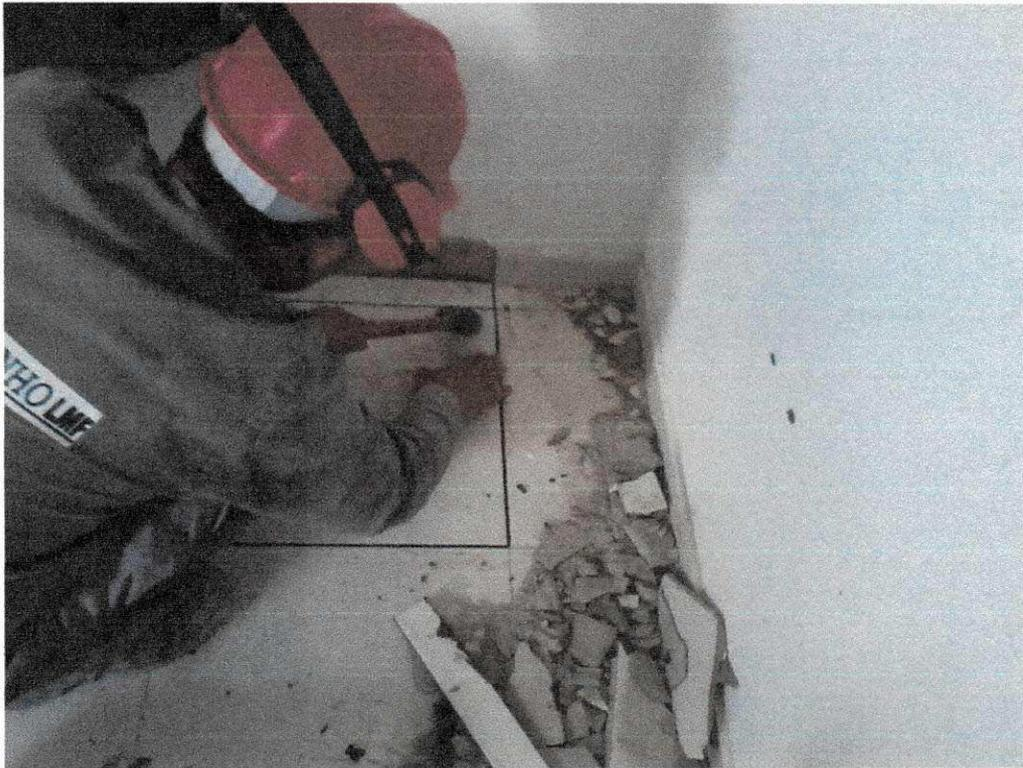
Figura 11 - *Check list*: substituição de uma cerâmica que estava fora de nível por uma nova.
