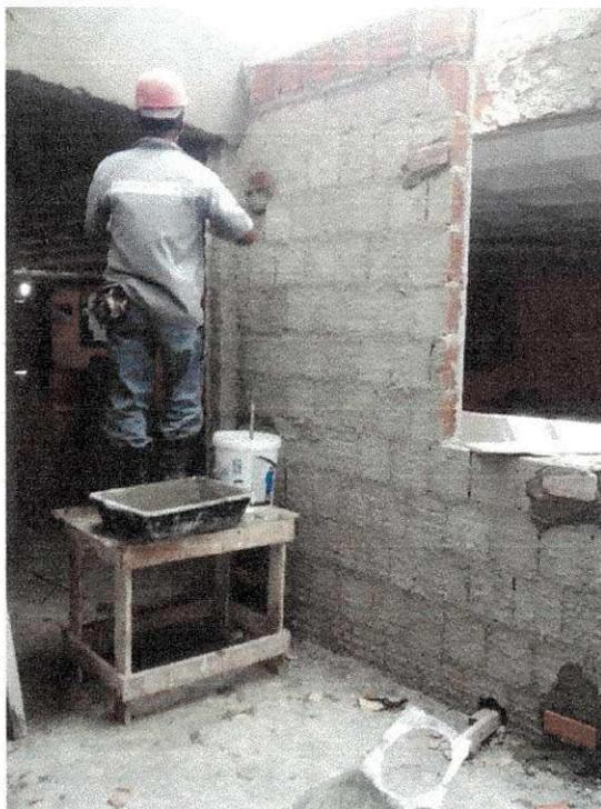
Figura 17 - Parede de alvenaria já chapiscada sendo emestrada.
