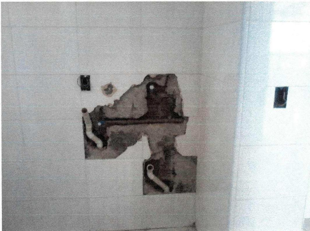
Figura 10 - *Check list*: pontos de água com vazamento (serviço de reparo em andamento).
