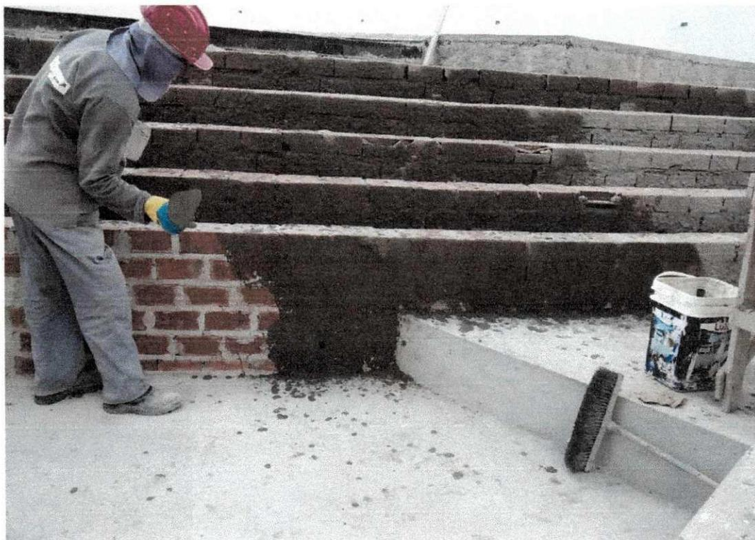
Figura 16 - Aplicação do chapisco na alvenaria
