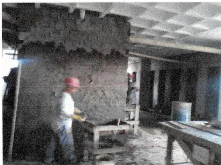
Figura 18 - Pedreiro fazendo uma "cheia" de argamassa na alvenaria.
