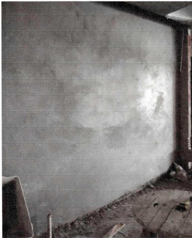
Figura 19 - Resultado do acabamento após o sarrafeamento da argamassa na parede.
