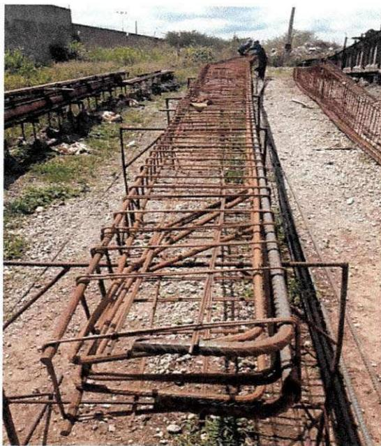
**Figura 4 - Armação de um Pilar 25cm x50cm x9m**
