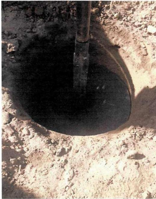
Terminada as escavações são feitas bases de concreto ciclópico com uma profundidade de 1 metro todas niveladas para que não haja diferença de altura entre elas, depois da cura que dura 7 dias os pilares são colocados nas bases.
