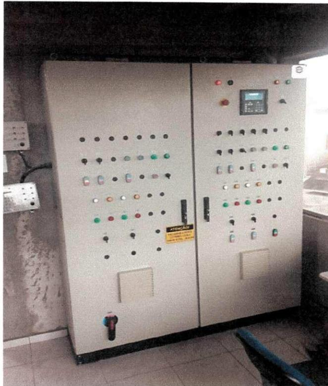
A central de processamento é responsável pela correta dosagem do concreto, o traço de concreto é medido por massa (kg). A dosagem de concreto da Incopost foi desenvolvida pela empresa ATECEL e fica armazenado na central, uma vez armazenado, ela só é alterado caso haja alguma mudança na granulometria dos agregados.
