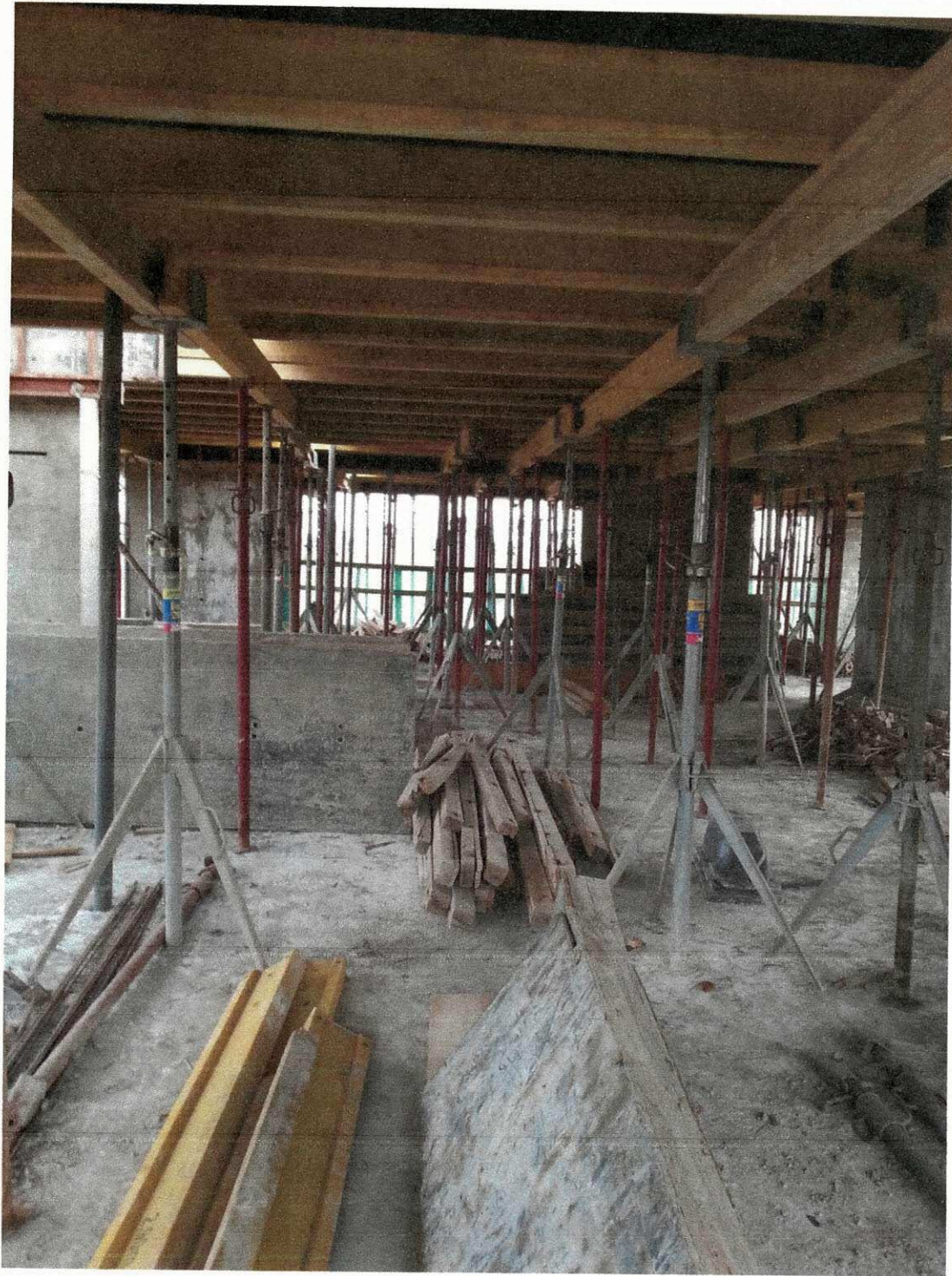
Figura 7-d: sistema de escoramento metálico para lajes
