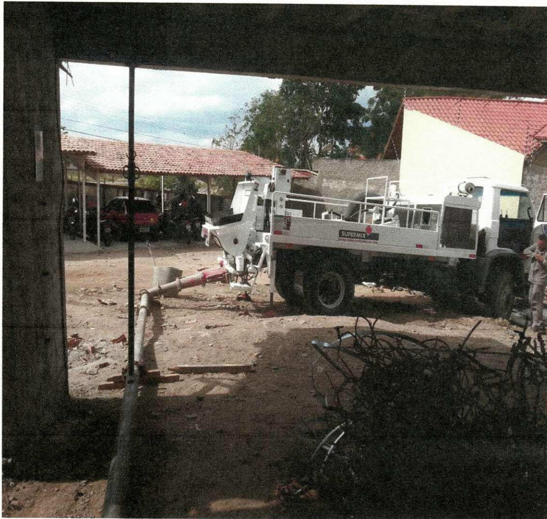
Figura 8: caminhão bomba utilizado para bombeamento do concreto
