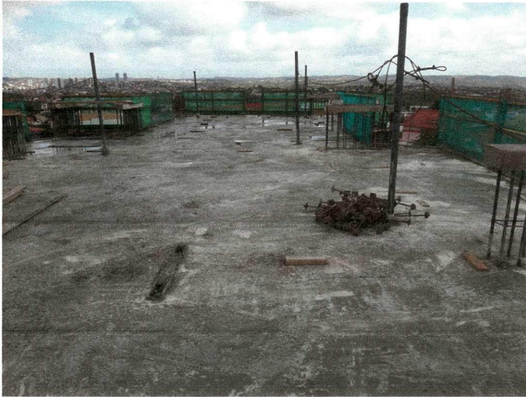
Figura 13: cura úmida após concretagem
