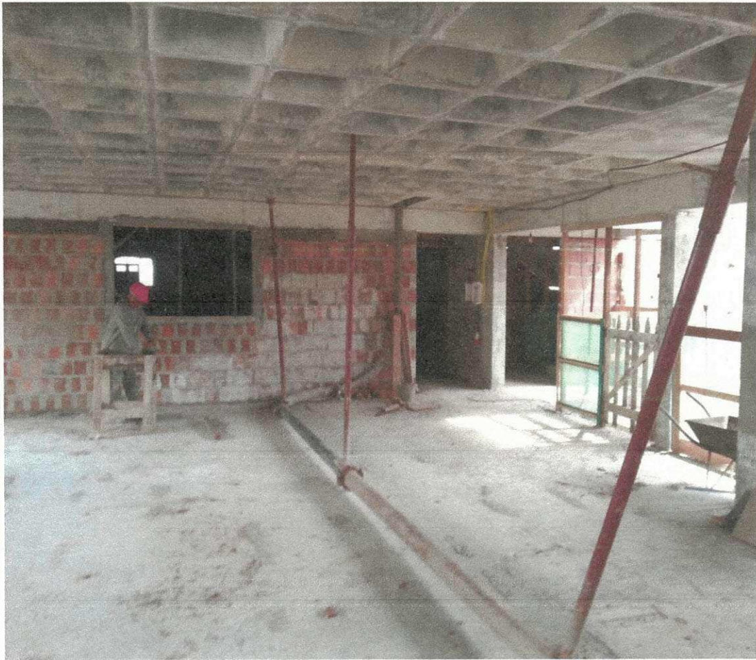
Figura 9-a: tubulação de aço utilizada para condução do concreto bombeado
