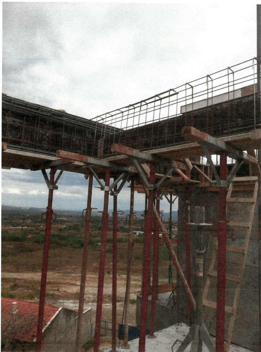
Figura 6-c: montagem de vigas
