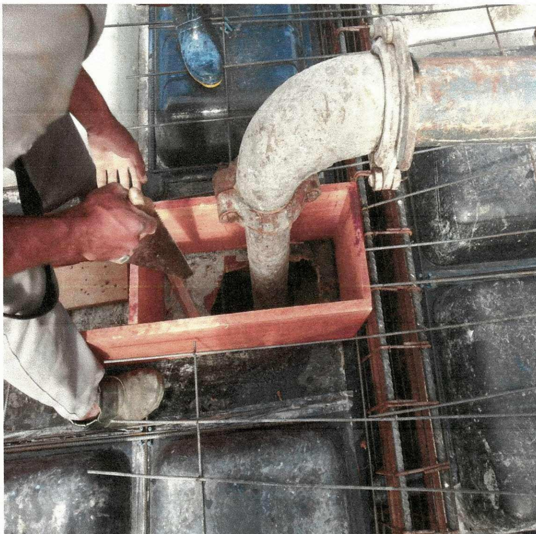
Figura 9-b: tubulação de aço utilizada para condução do concreto bombeado
