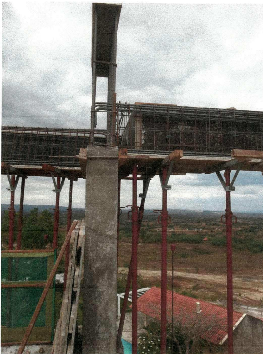
Figura 65-b: montagem de vigas
