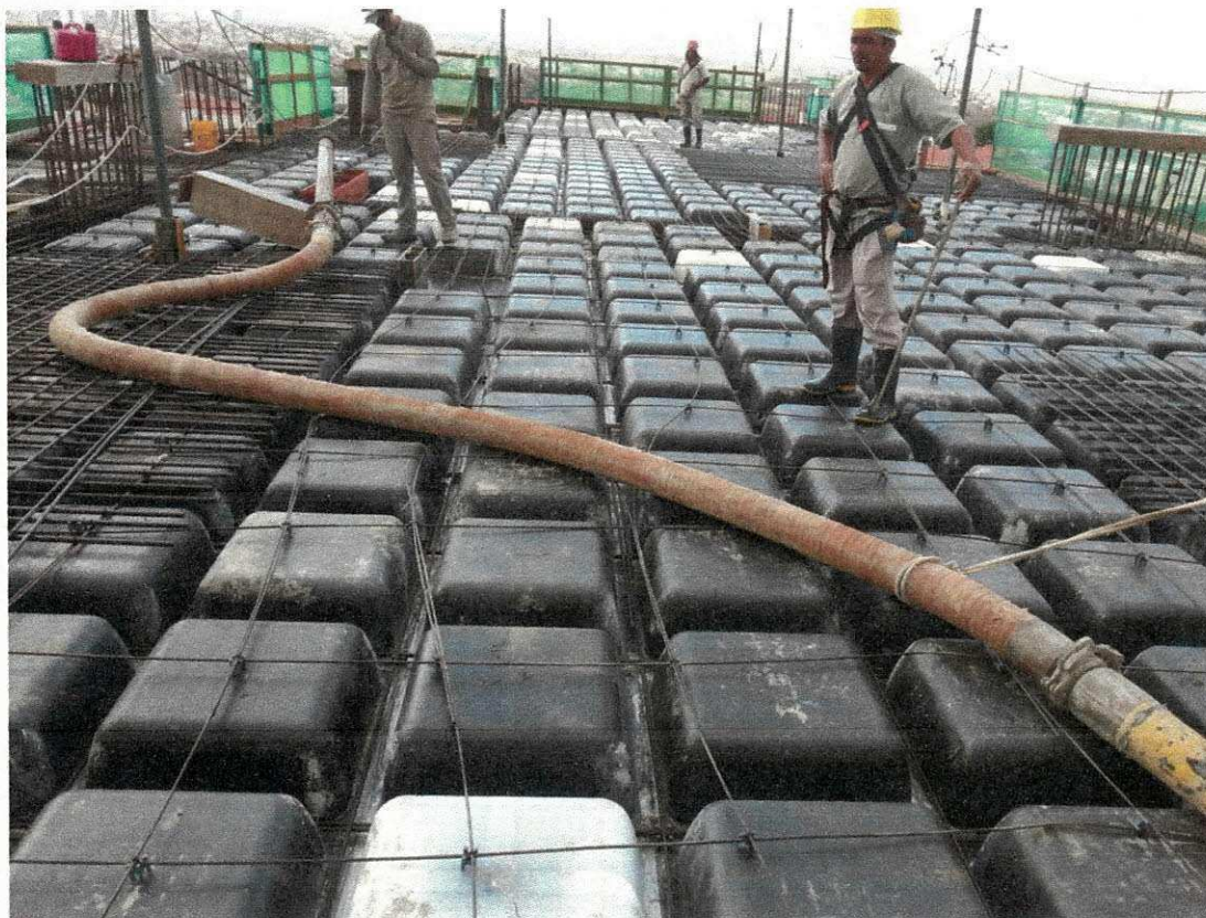
Figura 9-c: tubulação de aço utilizada para condução do concreto bombeado
