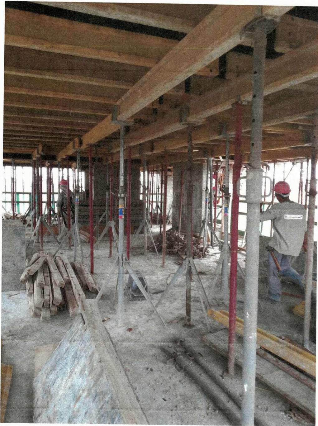
Figura 7-b: sistema de escoramento metálico para lajes
