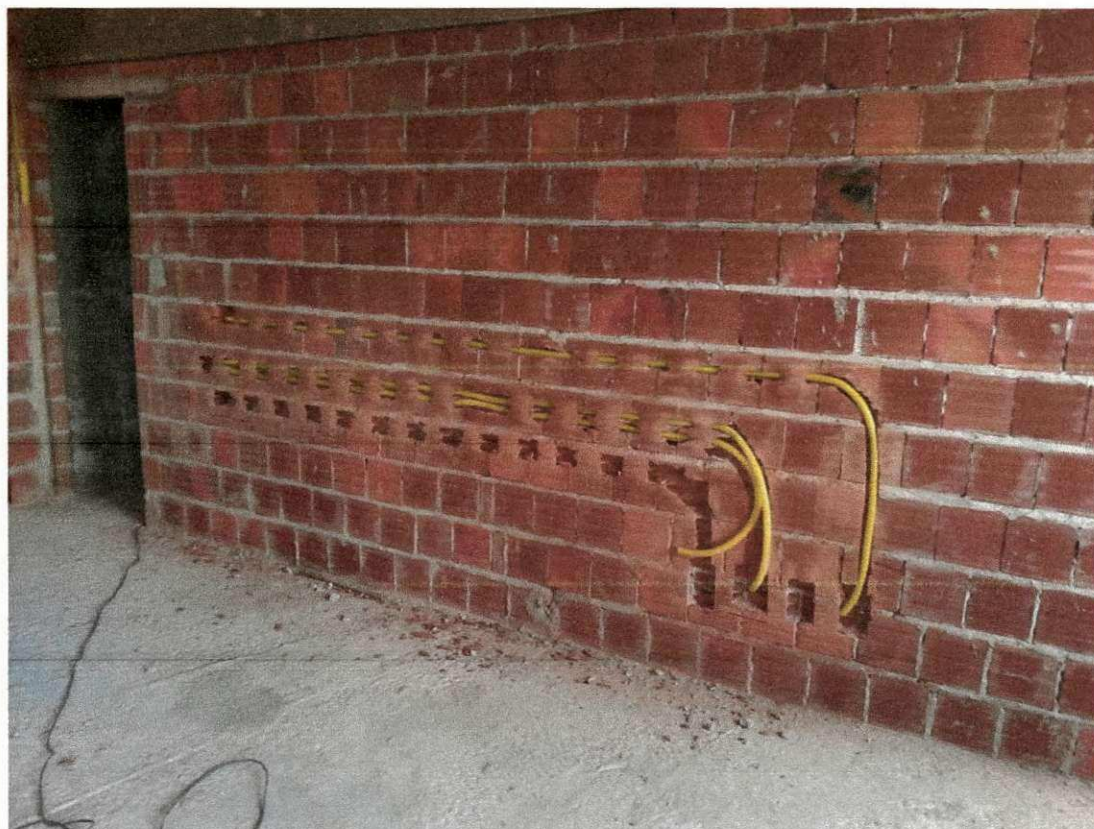
Figura 21: instalação de eletrodutos nas paredes
