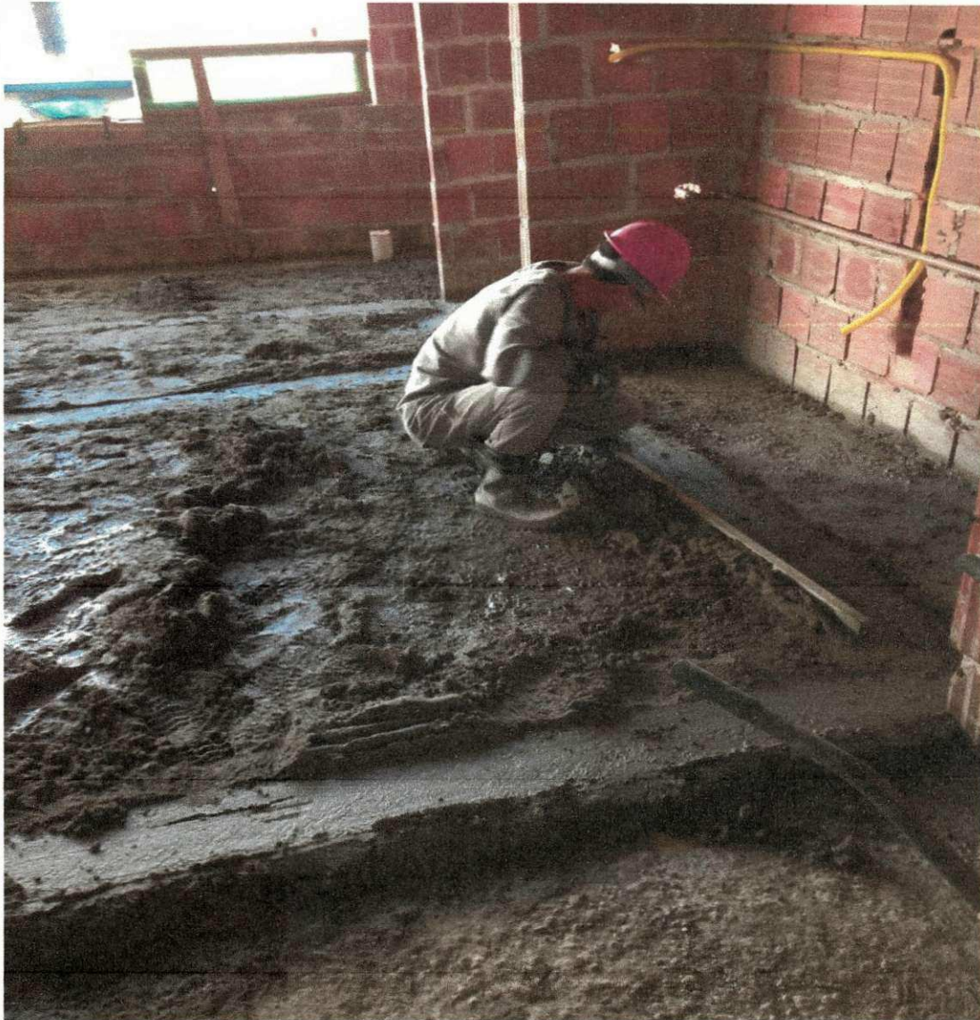
Figura 20-b: execução de contrapiso
