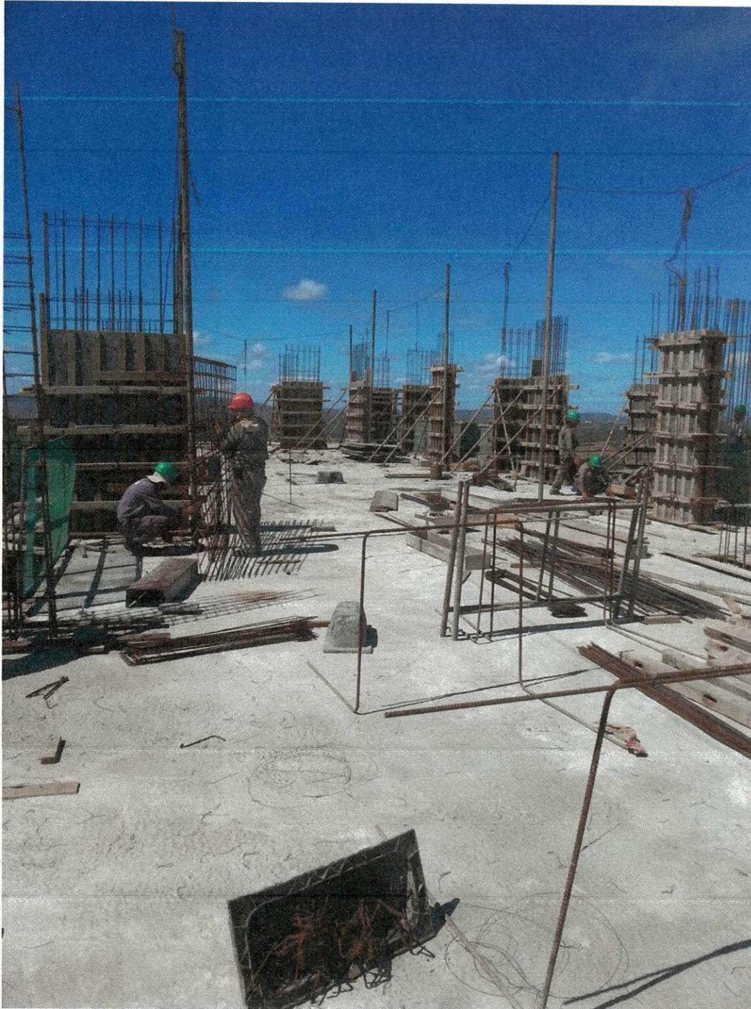
Figura 5-b: montagem de pilares
