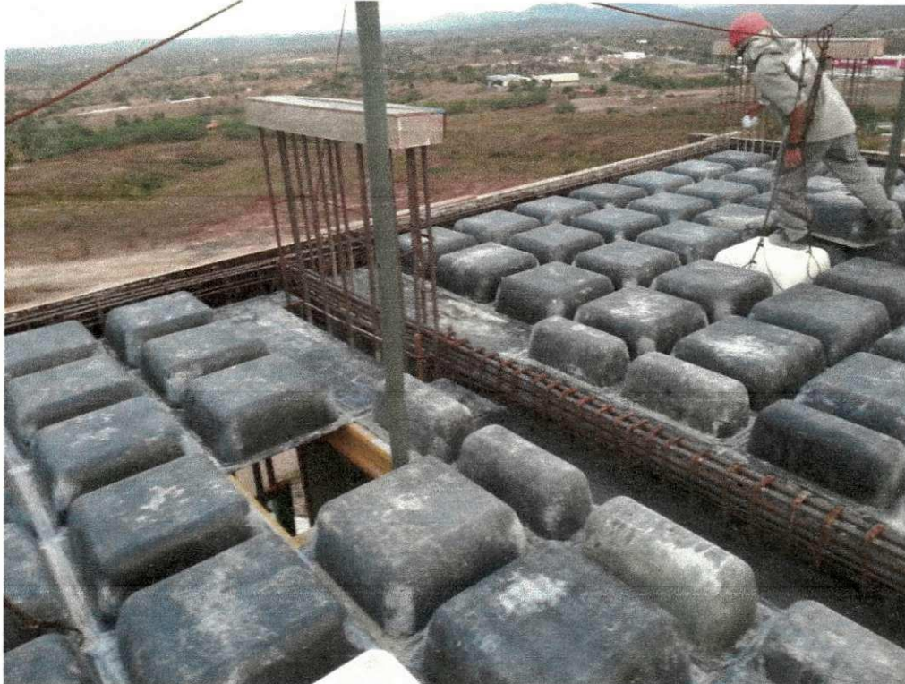
Figura 6-d: montagem de vigas
