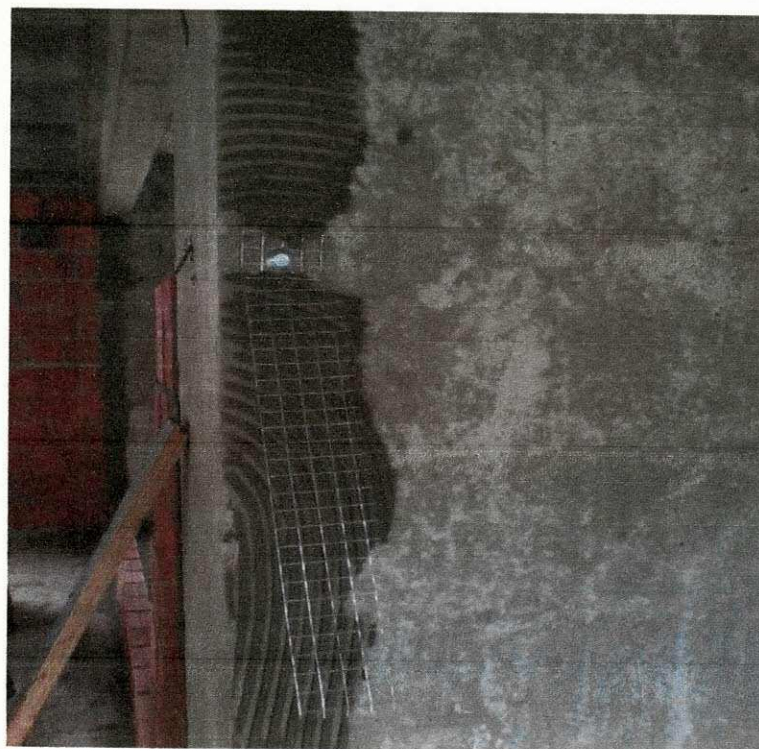
Figura 18: telas galvanizadas para ancoragem na alvenaria
