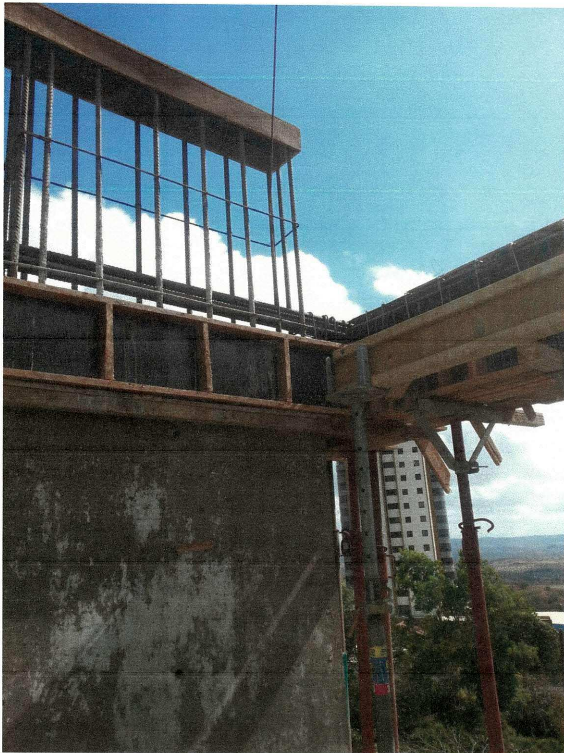
Figura 6-a: montagem de vigas
