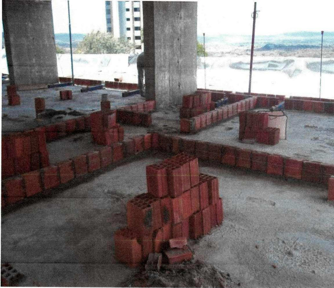
Figura 15: marcação de alvenaria
