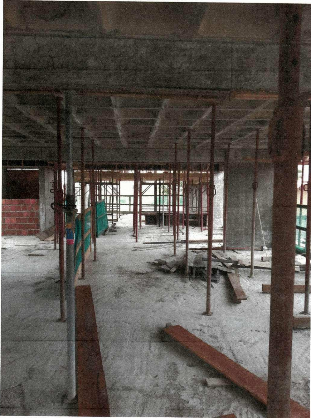
Figura 14: desforma de lajes
