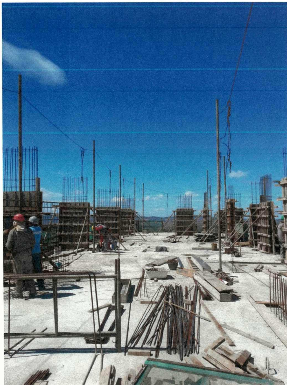
Figura 5-a: montagem de pilares
