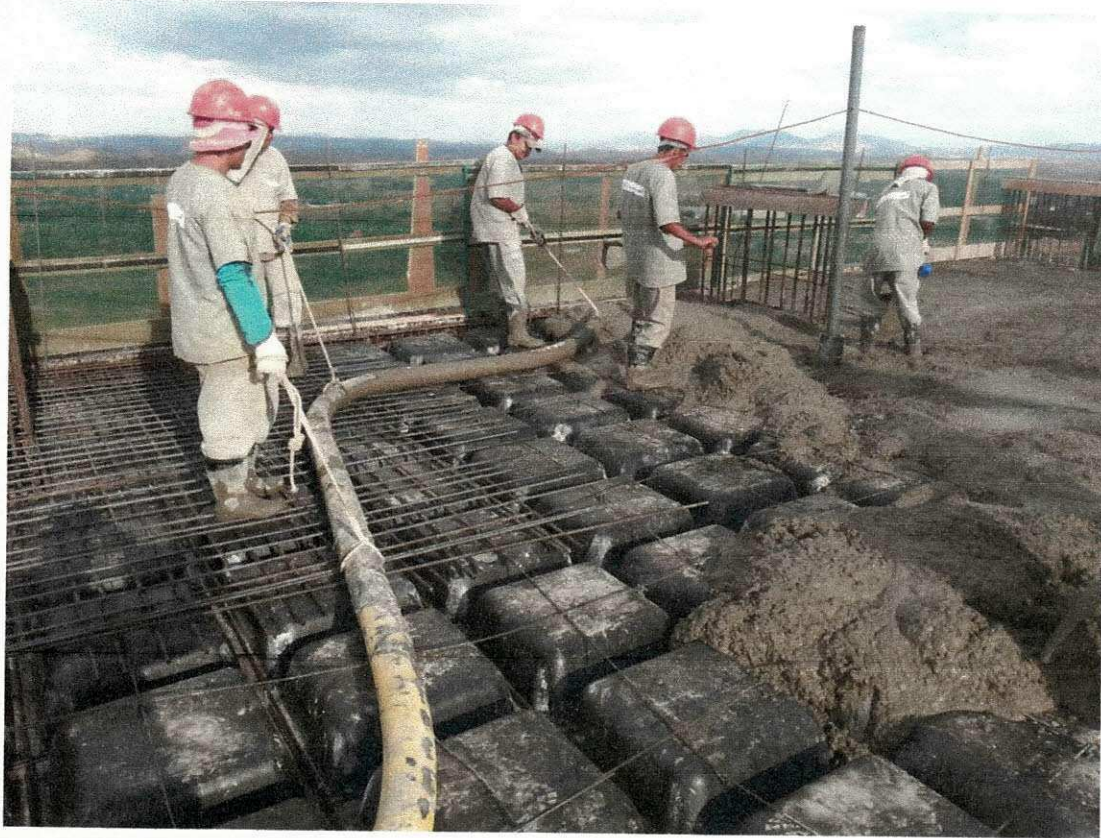
Figura 10-a: lançamento do concreto bombeado
