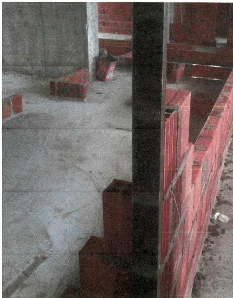
Figura 16: utilização do escantilhão para orientação das fiadas
