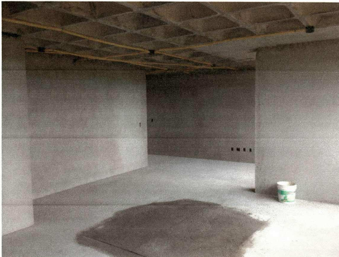
Figura 19-b: revestimento com massa única
