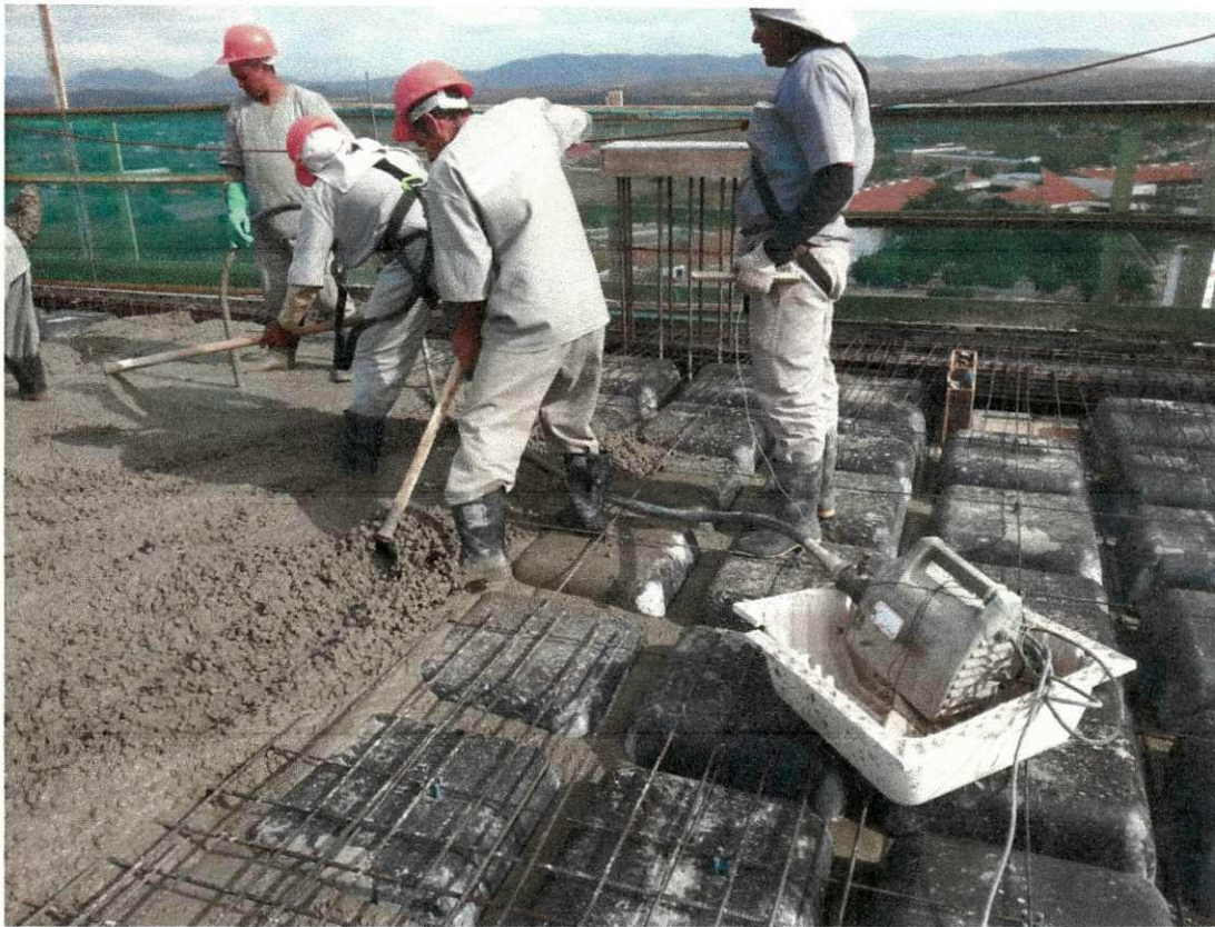
Figura 11: adensamento do concreto
