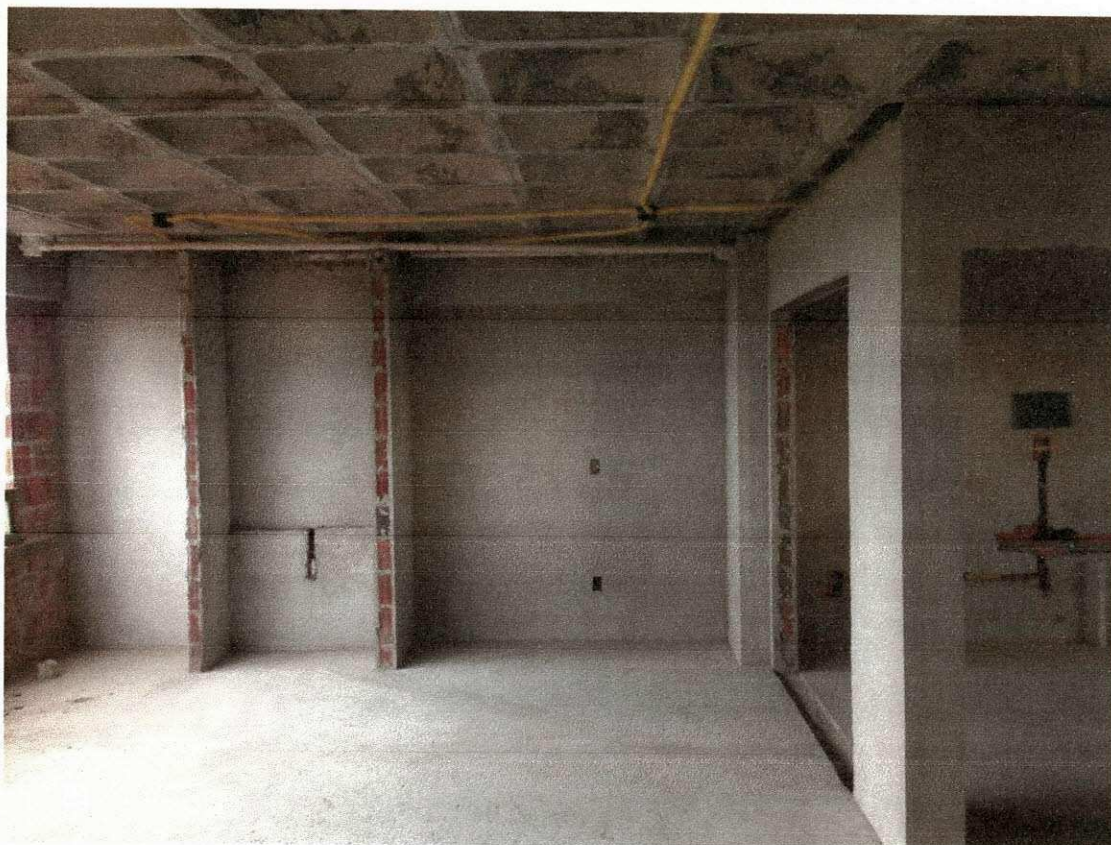
Figura 19-a: revestimento com massa única
