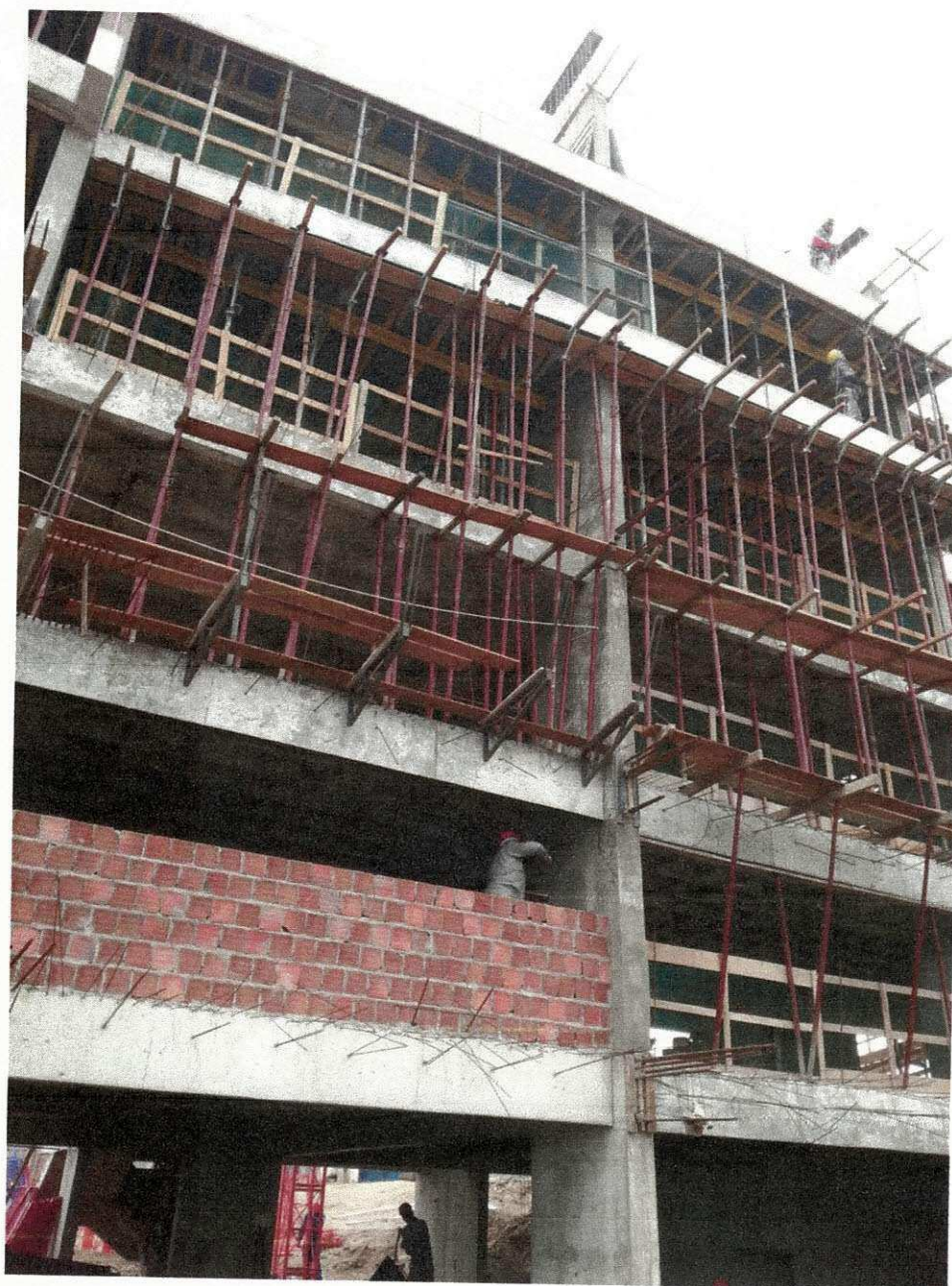
Figura 7-c: sistema de escoramento metálico para lajes
