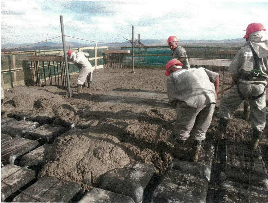
Figura 10-b: lançamento do concreto bombeado
