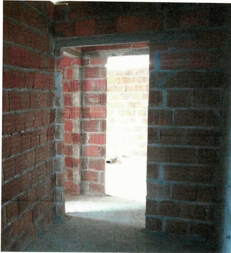
Figura 17: implantação das vergas nos vãos das portas
