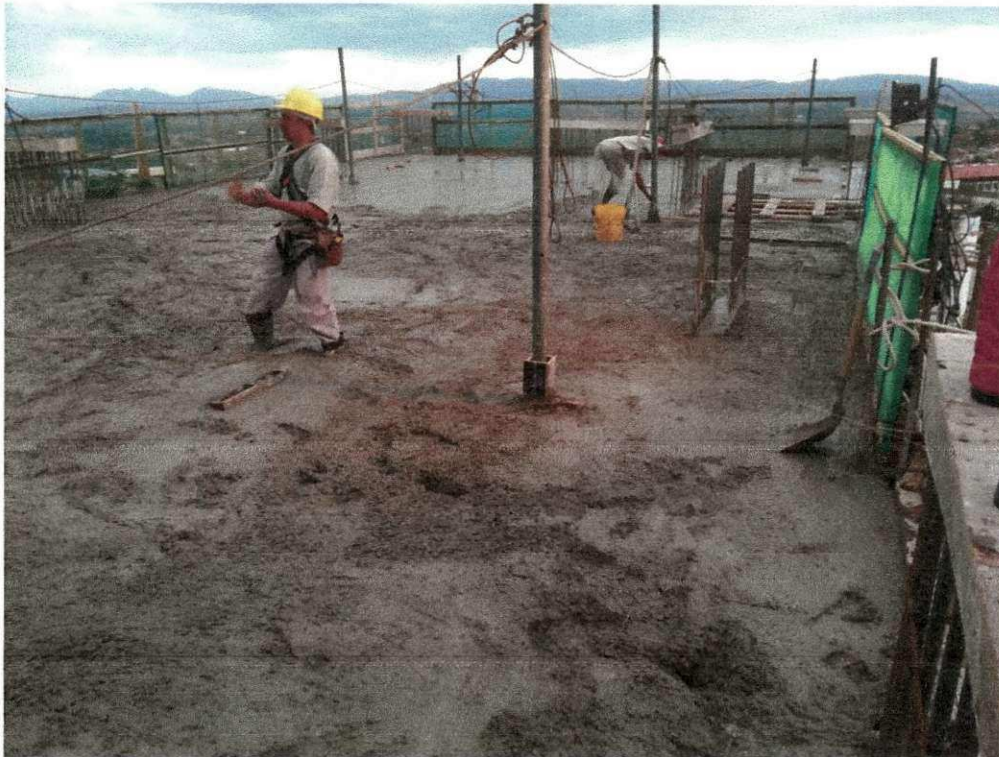
Figura 12: nivelamento do concreto
