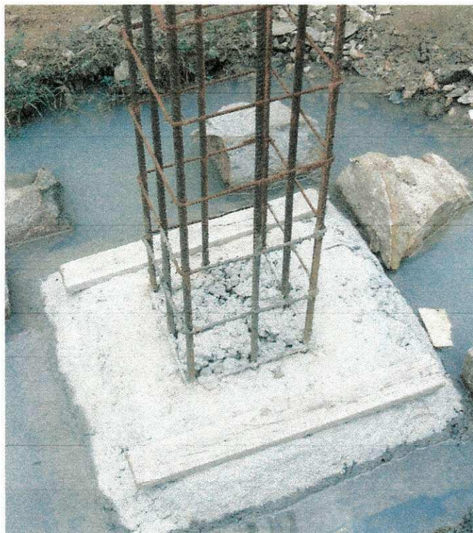
Figura 10. Sapata isolada com armadura de espera para moldagem do pilar
