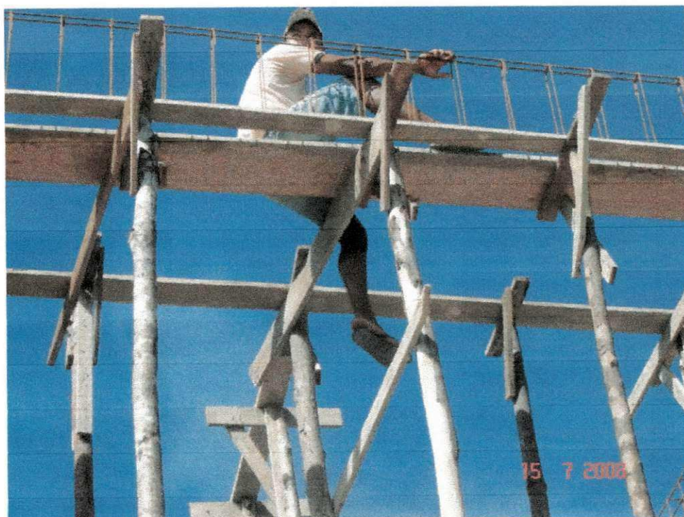
Figura 6. Detalhe das armaduras das vigas.
