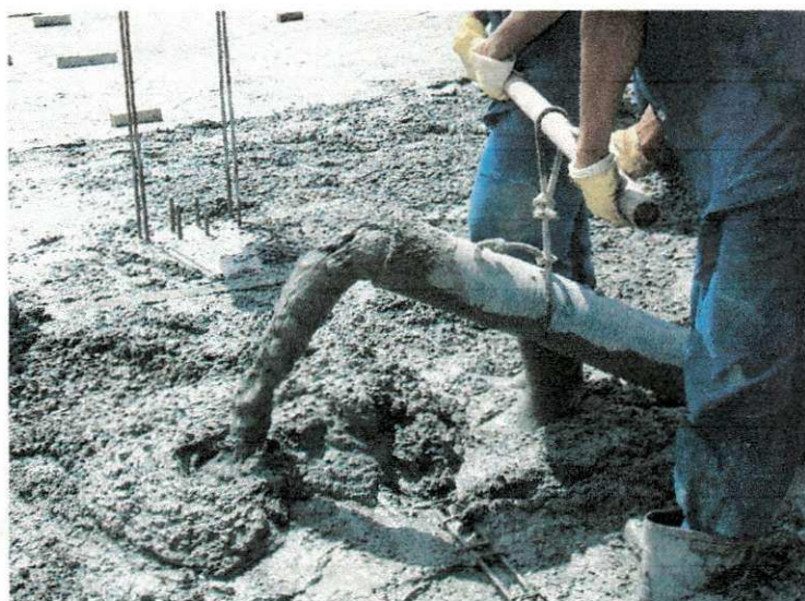
Figura 4. Lançamento do concreto usinado
