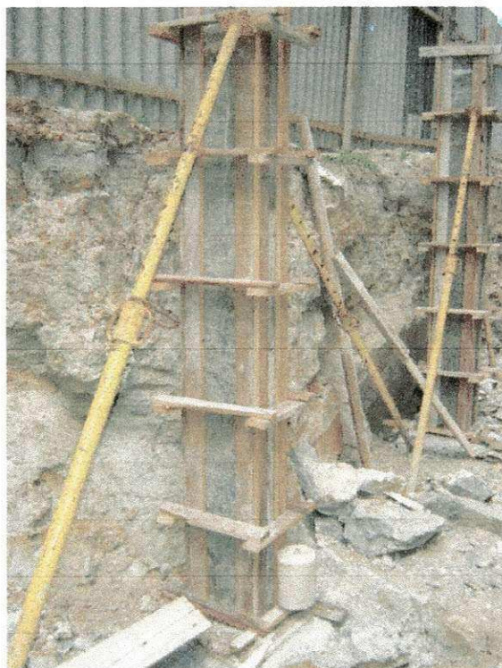
Figura 1. Fôrma de madeira para pilar
