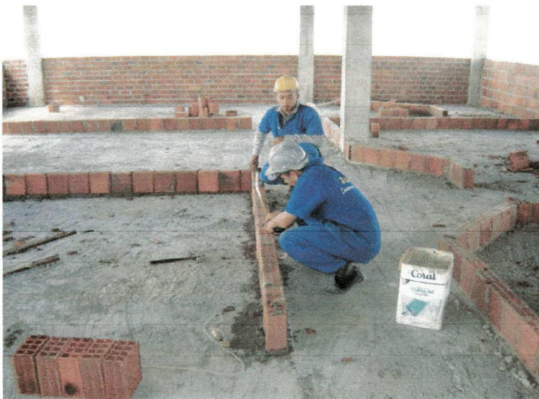
Figura 11. Detalhes dos processos de marcação e levantamento de alvenaria.
