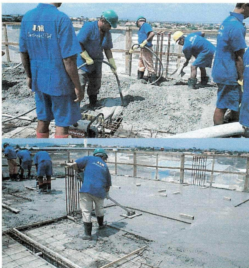
Figura 8. Concretagem de lajes e vigas (Pinheiro, 2006).
