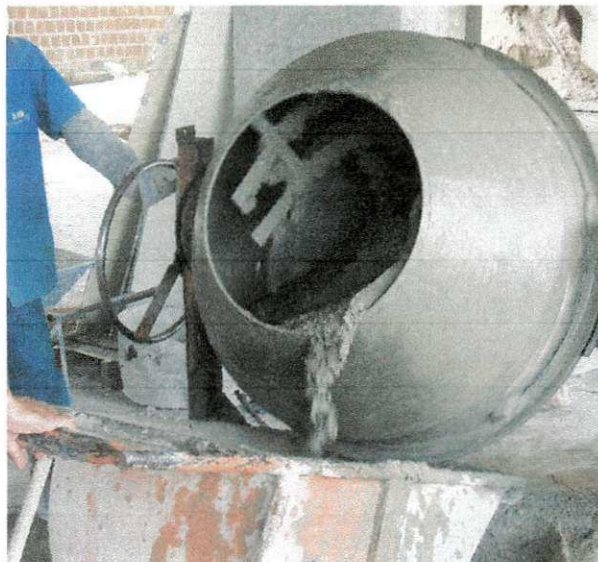
Figura 3. Preparação do concreto na betoneira
