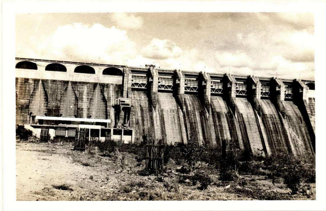
2 - Barragem da Pedra - Vertedores e Usina
