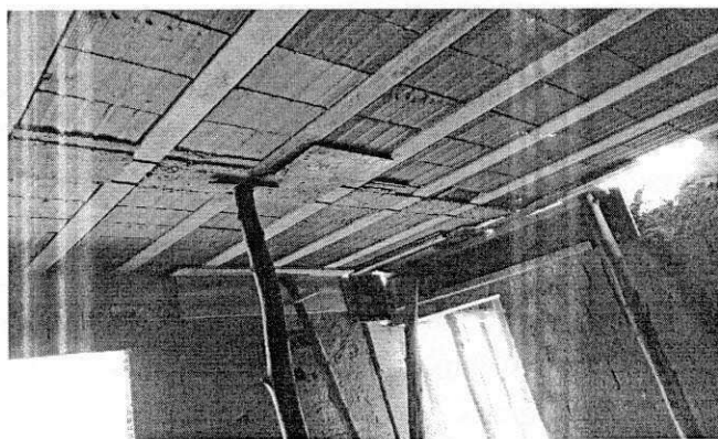
Foto 3.15 – Laje com escoras.
