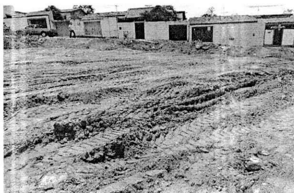
Foto 3.4 – Terreno limpo em terraplenagem.
