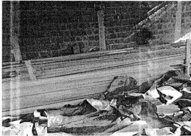
Foto 3.2 – Barracão para depósito de madeira para cobertura.
