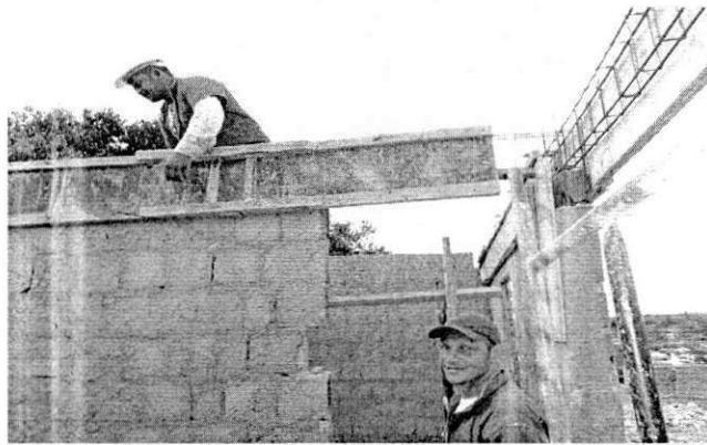
Foto 3.13 – Fôrmas das vigas.
