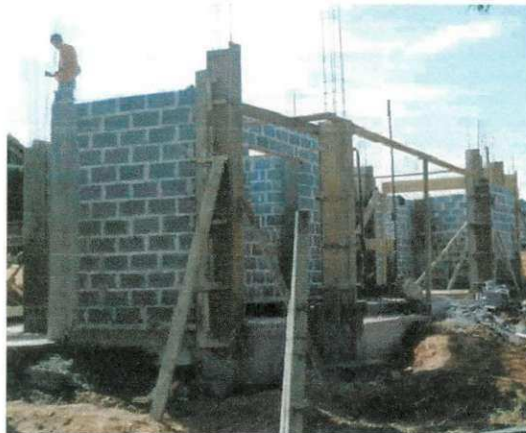
Figura 01- Fôrmas em Pilares
