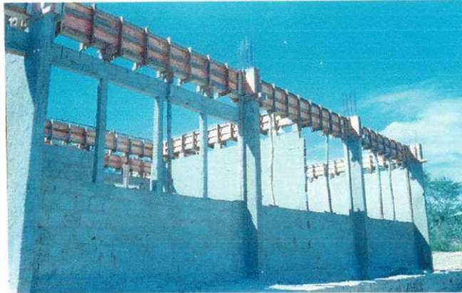
Figura 02-Fôrmas em Vigas
