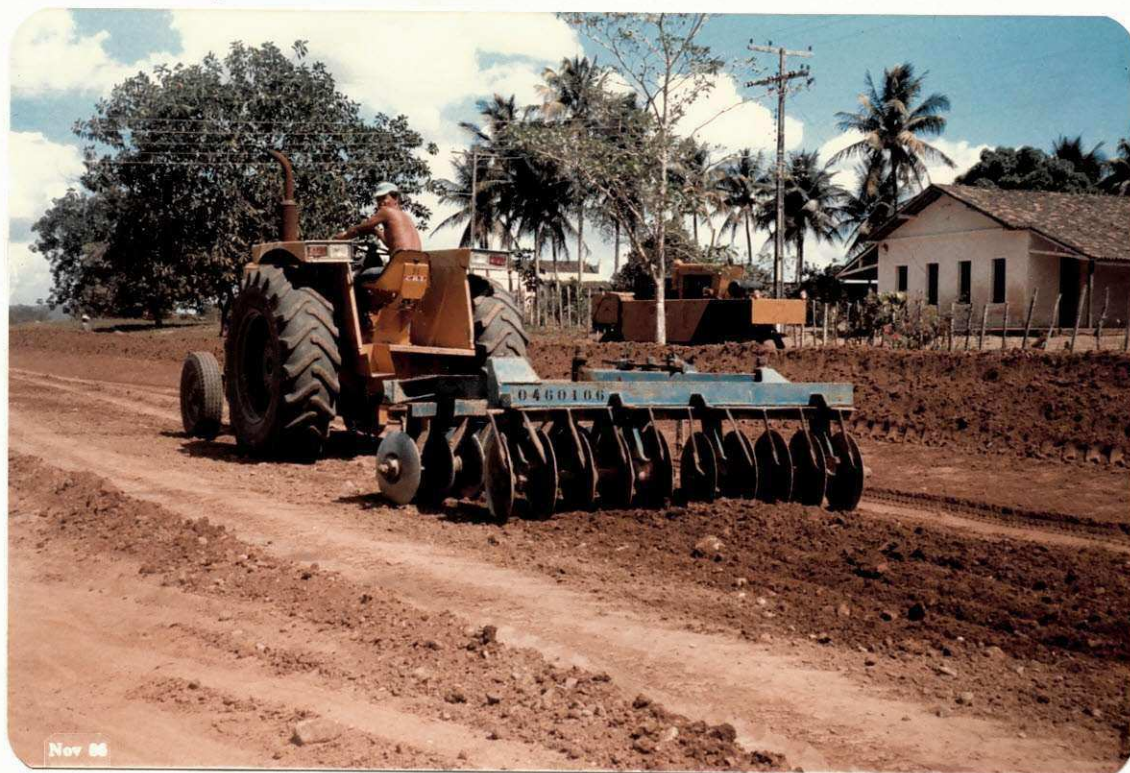
Grade-de-Disco utilizada para gradear o material (no caso trecho de base.)
