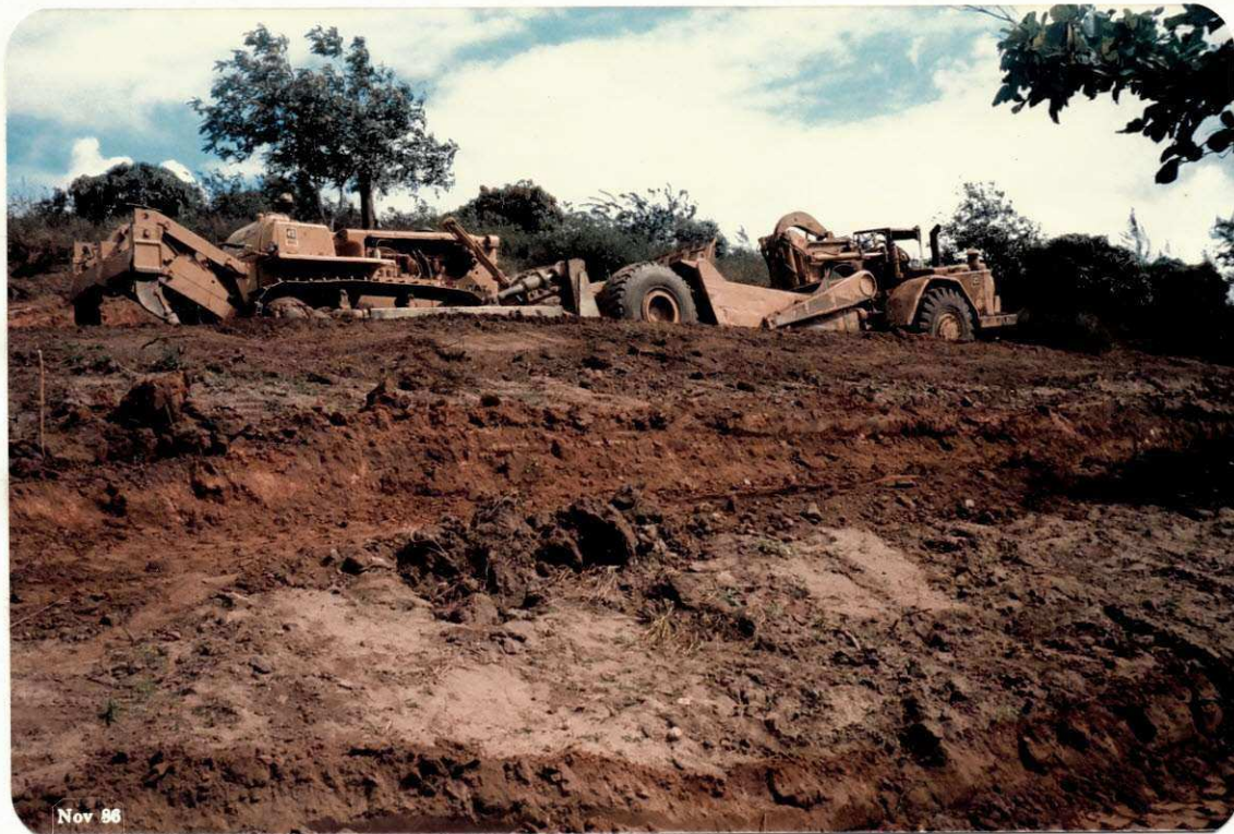
D8 empurrando um Moto-Scraper que esta atuando na regularização de um corte na rodovia. (Juracy Palhano).
