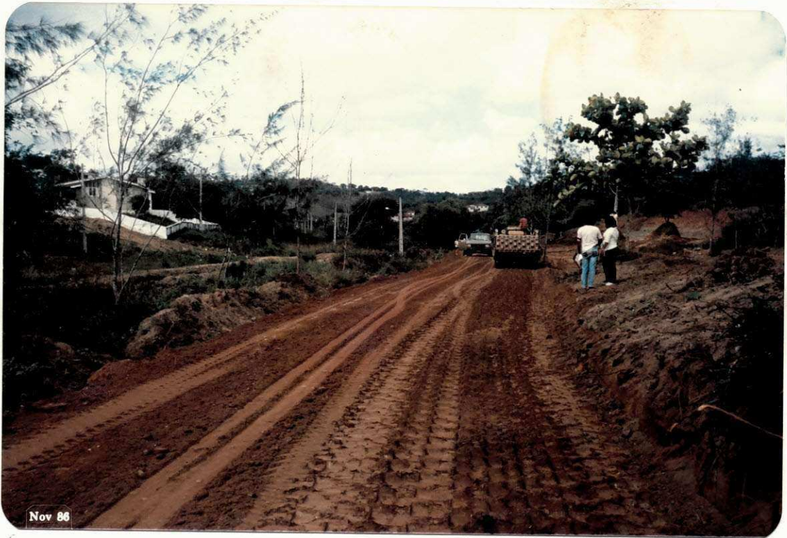
Rolo pé-de-carneiro, compactando camada de material argiloso (Juracy palhano.)
