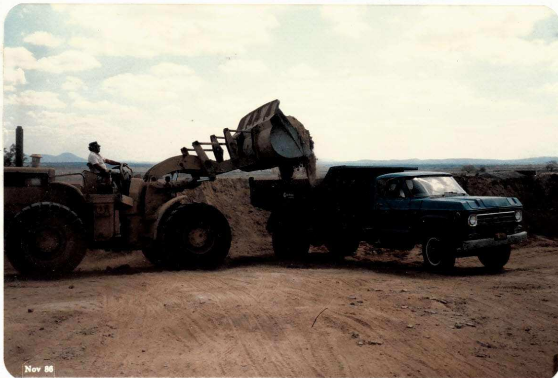
Carregadeira colocando material de base no caminhão basculante. (Jazida de Base.)
