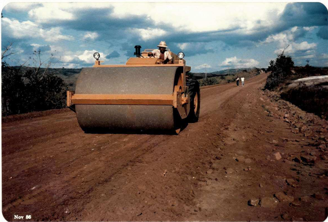
Rolo Liso Vibratorio, compactando camada de material arenoso. (base). Trecho de C. Grande-Massaranduba.
