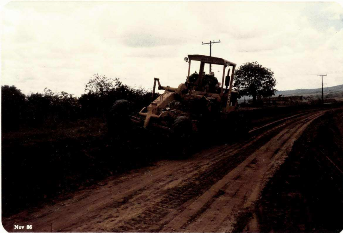
Patrol espalhando material de base no trecho.
