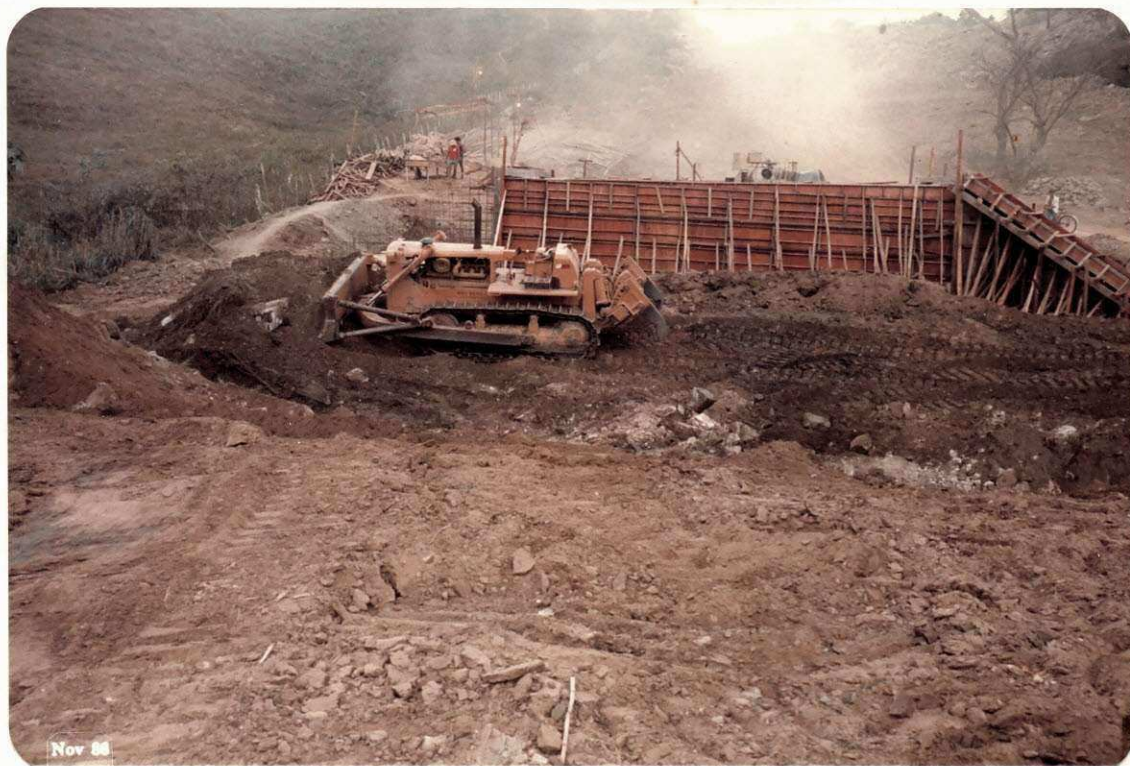
DH8 espalhando camada de aterro ao lado do BTCC.
