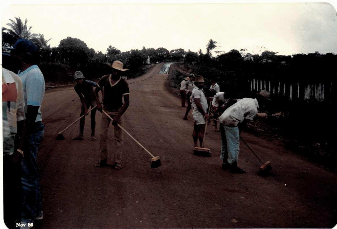
Material de base sendo varrido para receber a Imprimação, que pode ser vista já executada ao fundo.
