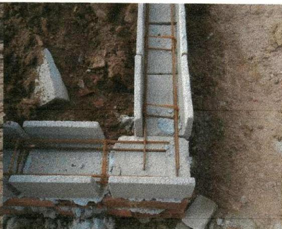
Foto 04: Ferragem colocadas na canletas.
