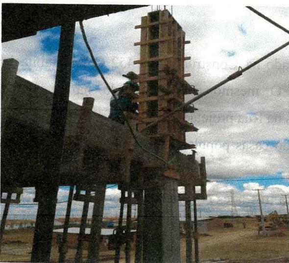
Foto 13: Montagem da forra dos pilares
