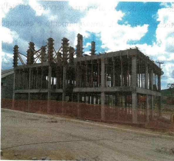
Foto 11: Estrutura de concreto armado
