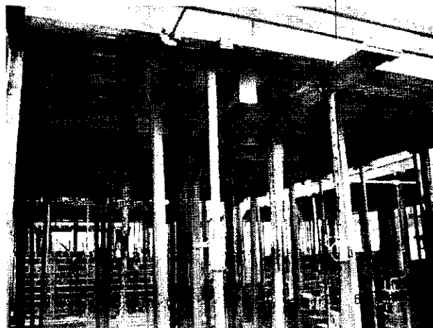
Figura 1. Escoramento do foyer 1
