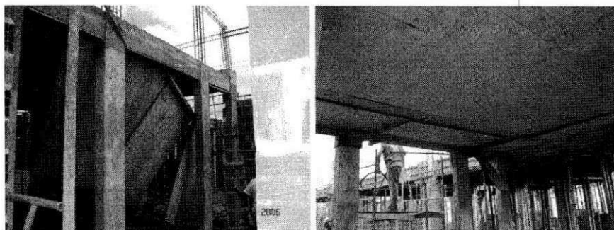
Figura 3. Desforma do foyer 2
