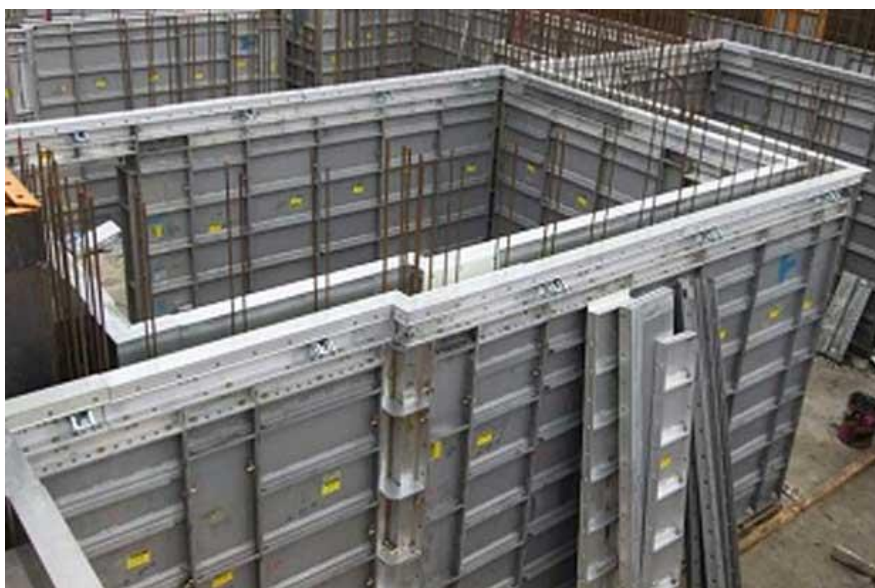
Figura 01: Exemplo do uso de formas de alumínio.
