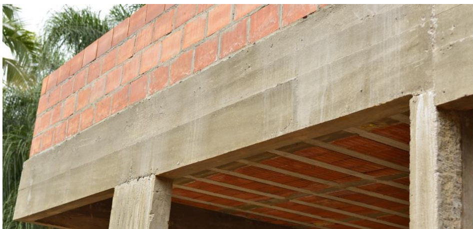
Figura 07: Viga em concreto armado.
