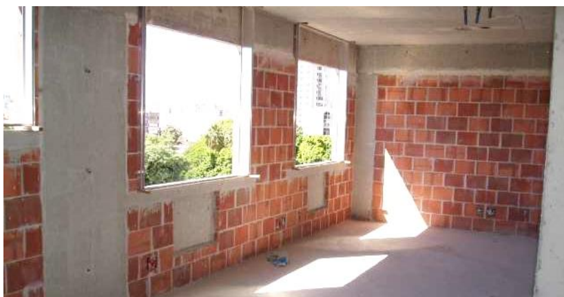
Figura 09: Exemplo de alvenaria de vedação.
