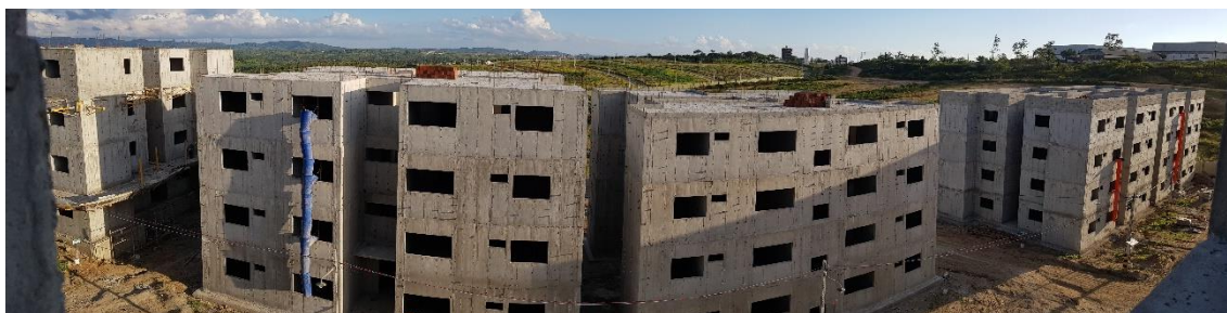
Figura 20: Vista panorâmica da construção do Residencial Sol Nascente.
