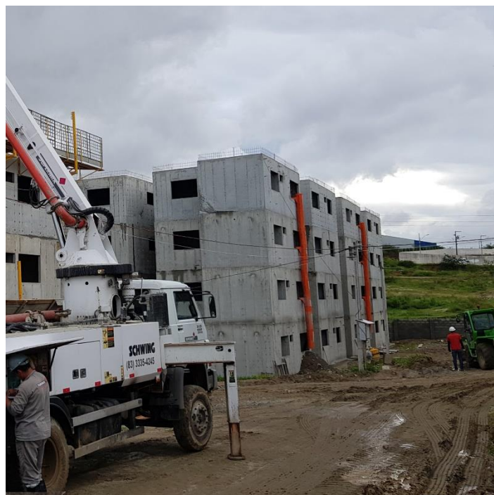
Figura 15: Estrutura de bloco feita em paredes de concreto.
