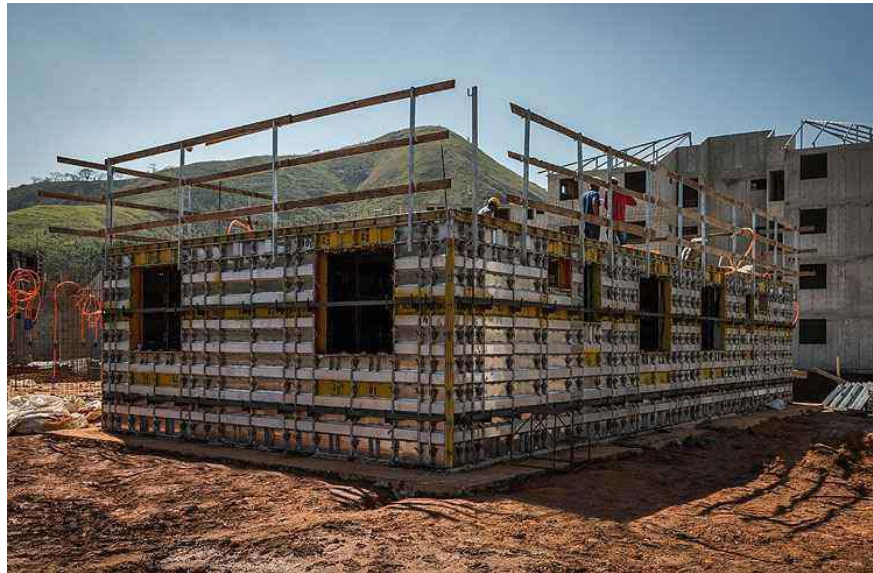
Figura 11: Exemplo do uso de formas metálicas, nesse caso de alumínio.
