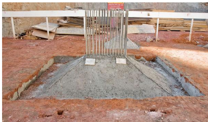
Figura 06: Exemplo de sapata de concreto armado.
