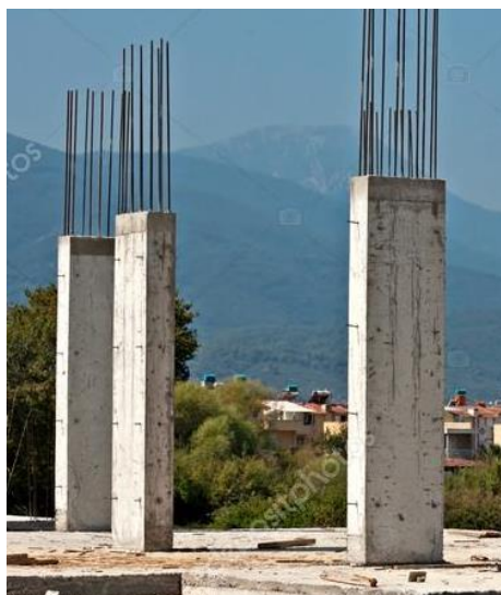
Figura 08: Exemplo de pilar de concreto armado.
