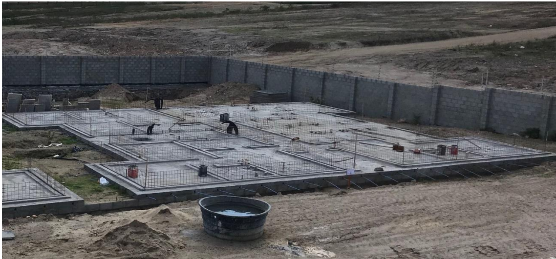
Figura 14: Radier após a concretagem.
