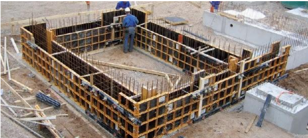
Figura 04: Formas para concreto armado.
