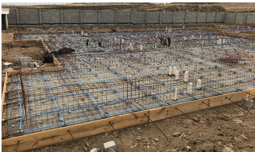
Figura 13: Radier preparado para concretagem.
