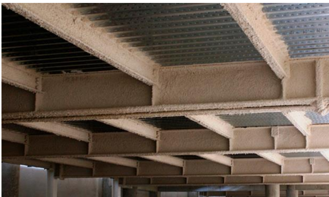
Figura 4: Argamassa projetada em vigas metálicas
