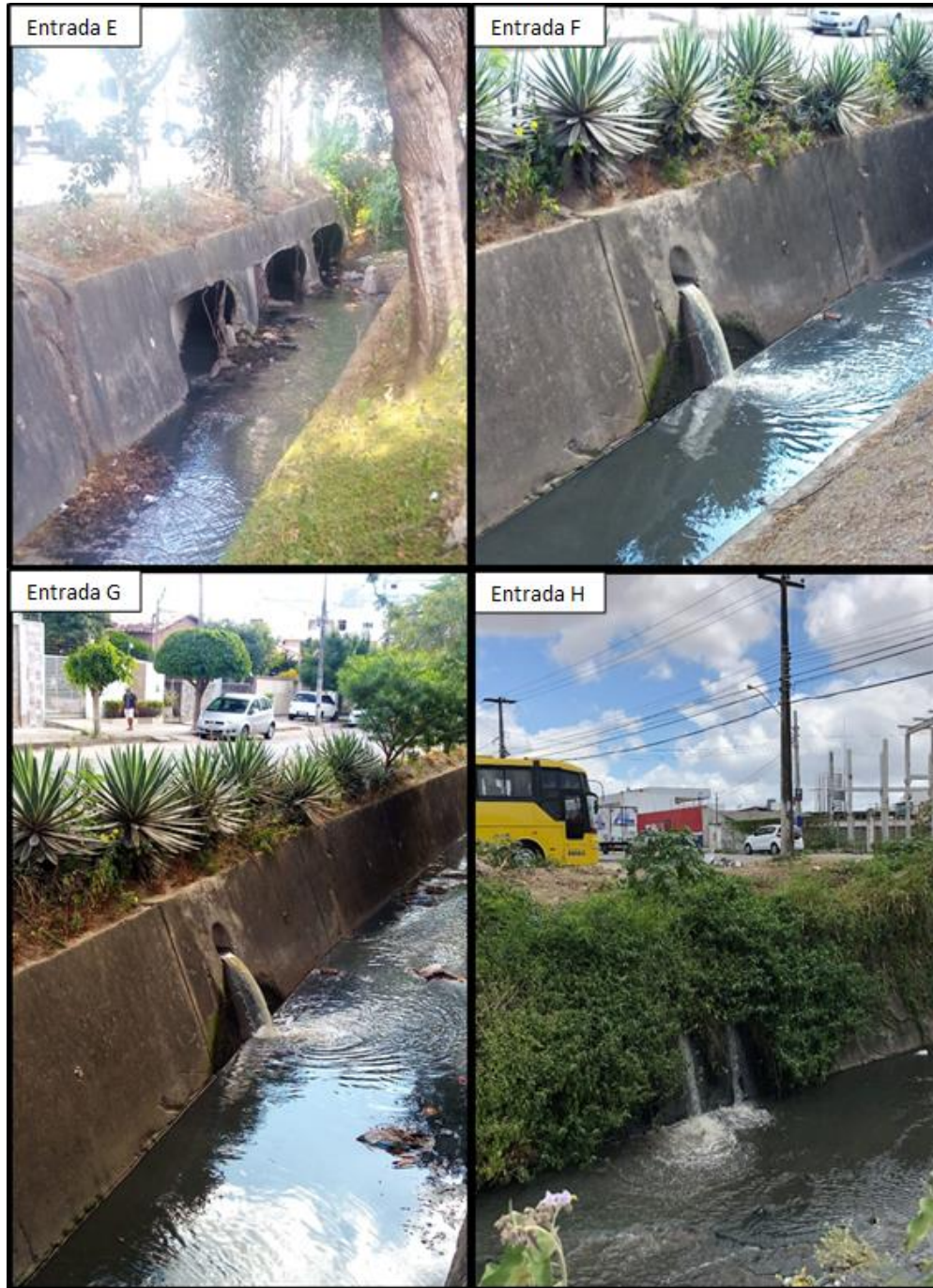
Figura 7 – Documentário fotográfico das contribuições de esgoto das Entradas E, F, G e H no canal do Prado
