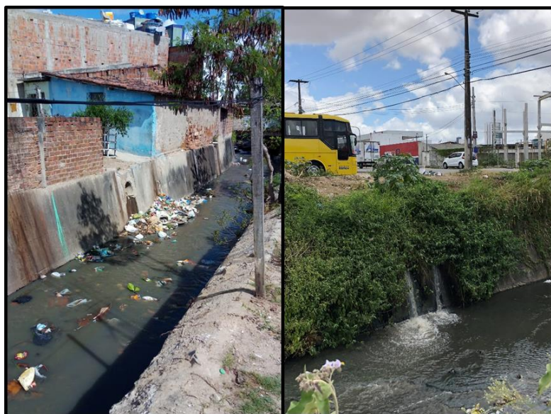
Figura 14 – Acúmulo de resíduos sólidos e vegetação no Canal do Prado
