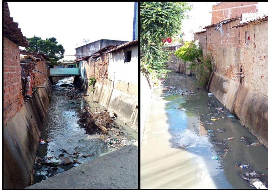
Figura 8 – Documentário fotográfico das contribuições de esgoto das Entradas I, J no canal do Prado
