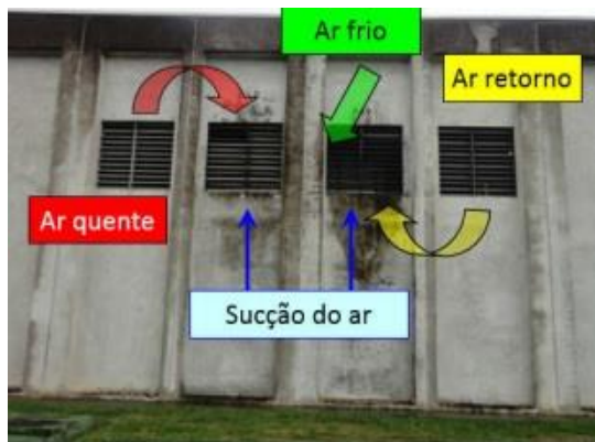
FIGURA 15: AJUSTE DE DAMPERS DA CTA'S: ANTES.
