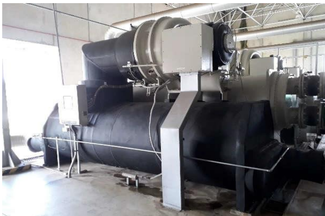
FIGURA 22: DESATIVAÇÃO DE CHILLER.
