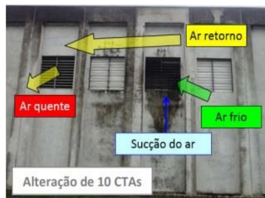
FIGURA 16: AJUSTE DE DAMPERS DA CTA'S: DEPOIS.
