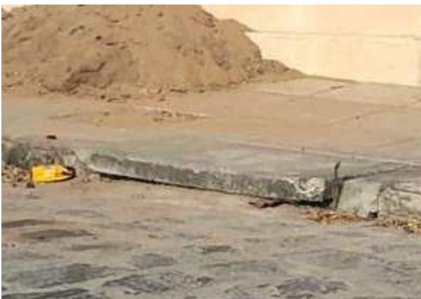
Figura 7: Boca de Lobo obstruída pelo pavimento
