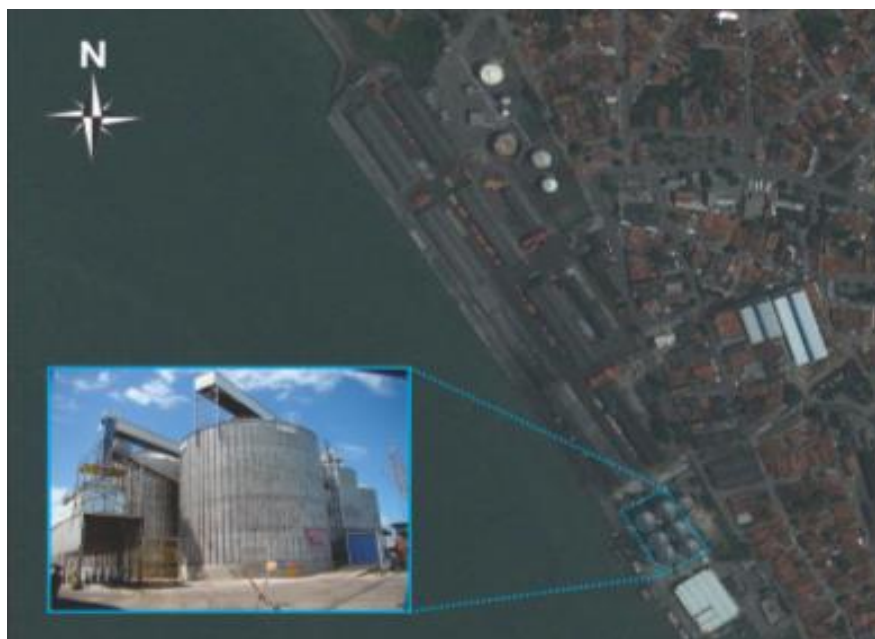
Figura 13: Localização dos silos no porto de Cabedelo.
