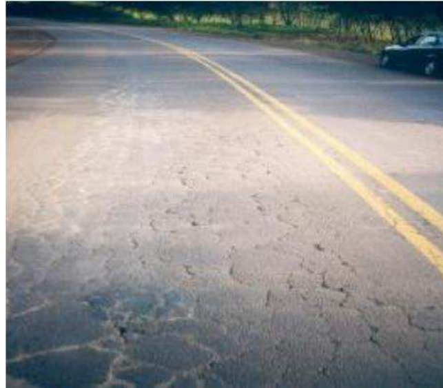
Figura 15 -Trincas Interligadas
