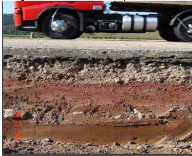
Figura 6- Camadas estruturais do pavimento flexível
