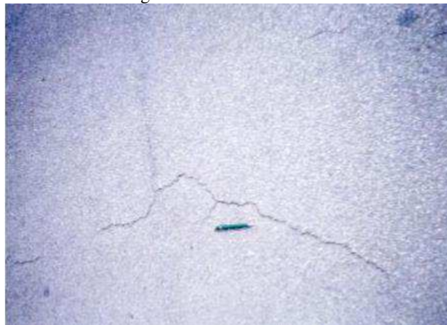
Figura 14 - Trincas isoladas
