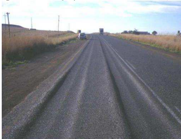
Figura 13- Deformação permanente em trilha de roda (ATR)
