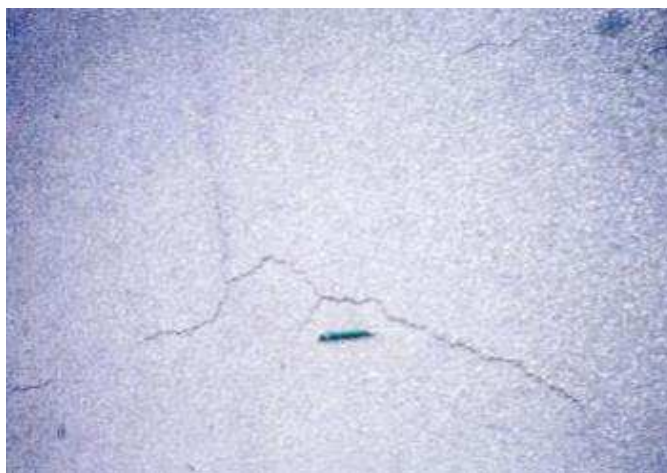
Figura 1: Trincas isoladas.
