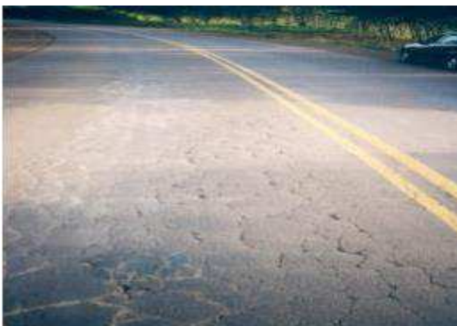
Figura 2: Trincas intercaladas.
