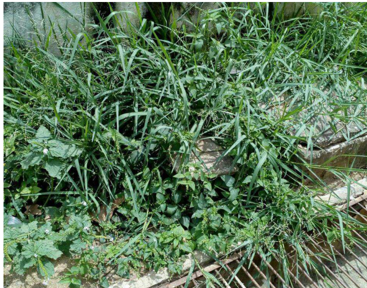
Figura 25 - Hidrômetro do banco Santander na UFCG encoberto pela vegetação
