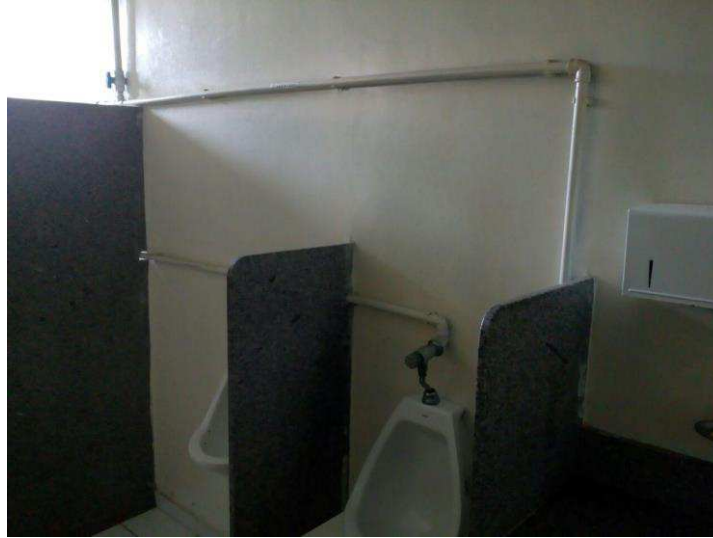
Figura 24 - Encanação do banheiro masculino no térreo do bloco CR
