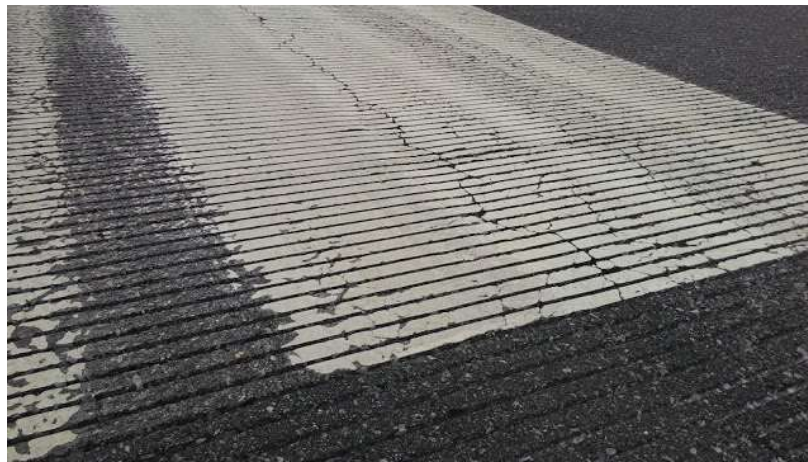
Figura 18: Estriamento do Aeroporto Lauro Carneiro de Loyola (Joinville, SC).
