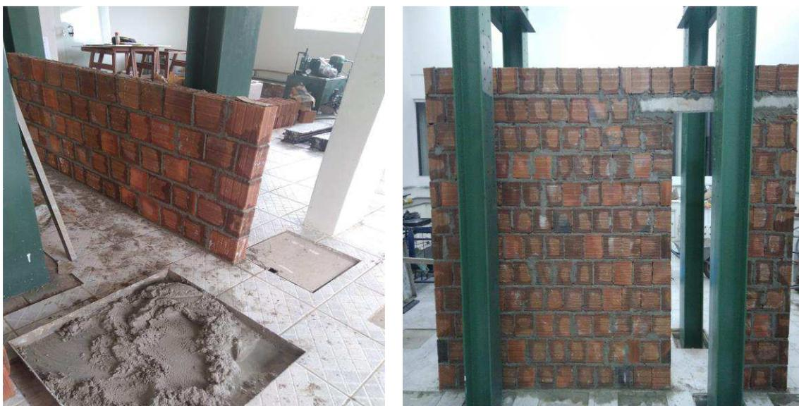
Figura 3.10: Execução das alvenarias de vedação no Laboratório de Estruturas – UAEC – UFCG.
