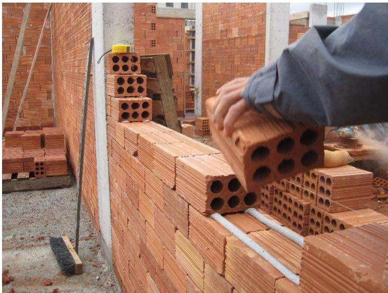
Figura 2.3: Aplicação de juntas de argamassa nos sistemas de vedações verticais.
