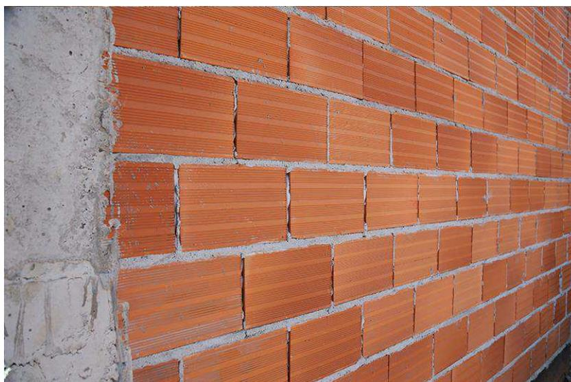
Figura 2.2: Exemplo de blocos cerâmicos 9x19x39cm usados em alvenarias a espelho (cutelo).
