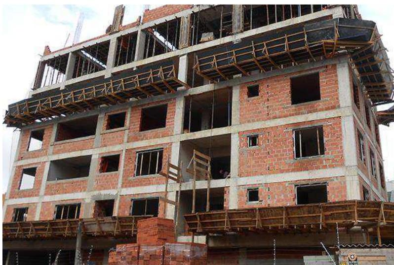
Figura 2.4: Construção de uma edificação utilizando alvenaria de vedação em blocos cerâmicos.
