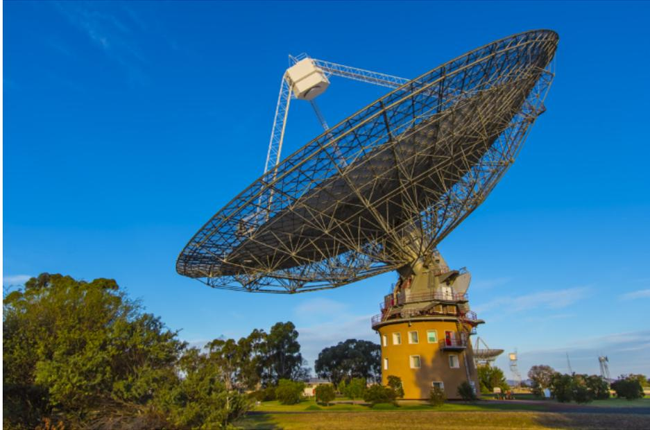
Figura 7 – Radiotelescópio Parkes, construído na Austrália com um prato de 64 m, que foi fundamental para a descoberta das FRB. Fonte: Dyer (2012) [25].
