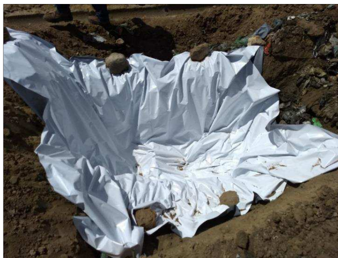
Figura 12 – Acomodação da manta sintética na cava
