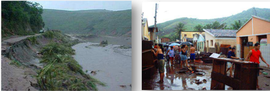
Figura 11. Desastre ambiental, provocado por falhas na construção da Barragem de Camará, município de Alagoa Grande-PB.
