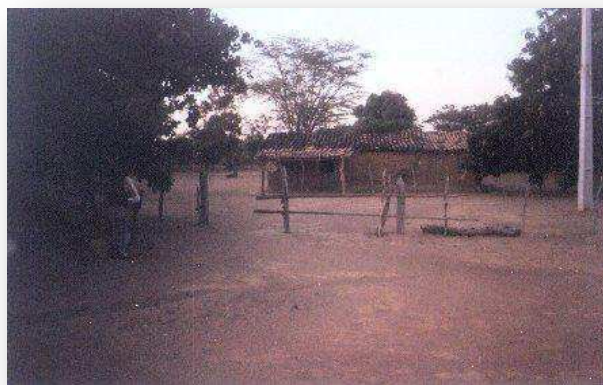
Figura 114. Aspecto geral de uma habitação do tipo taipa – sem energia elétrica. Zona rural de Araripina-PE. Coordenadas da figura: -07° 29' 1,9" e - 40° 22' 18,7".
