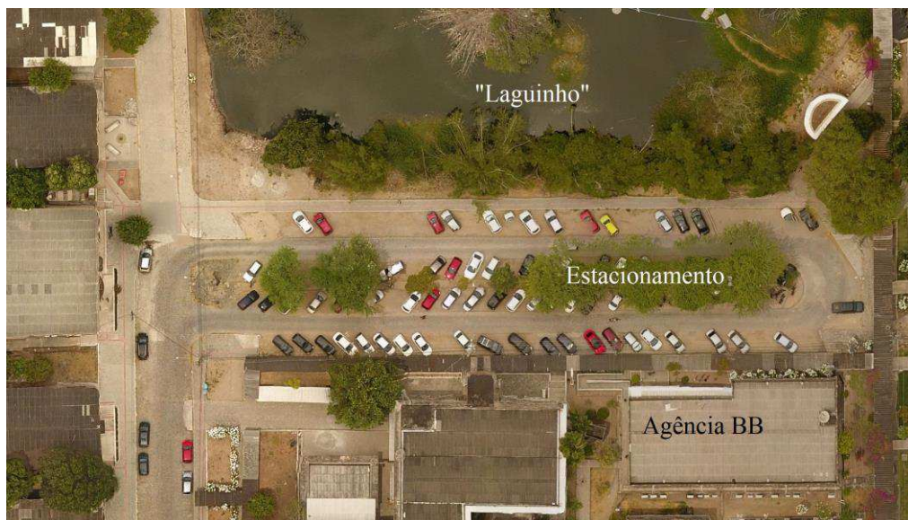
Figura 9: Vista aérea do estacionamento antes da instalação do pavimento permeável.
