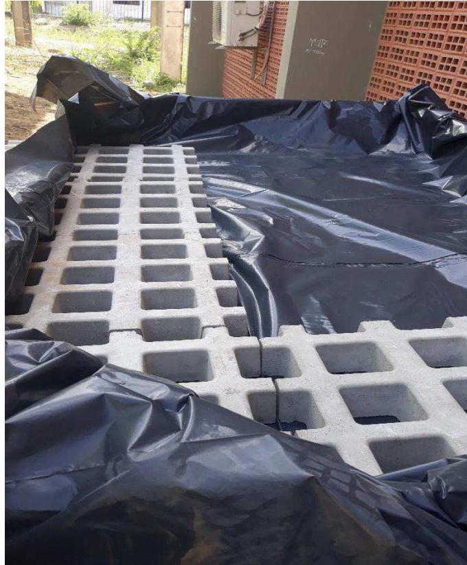
Figura 21: Colocação dos cobogramas sobre a lona.
