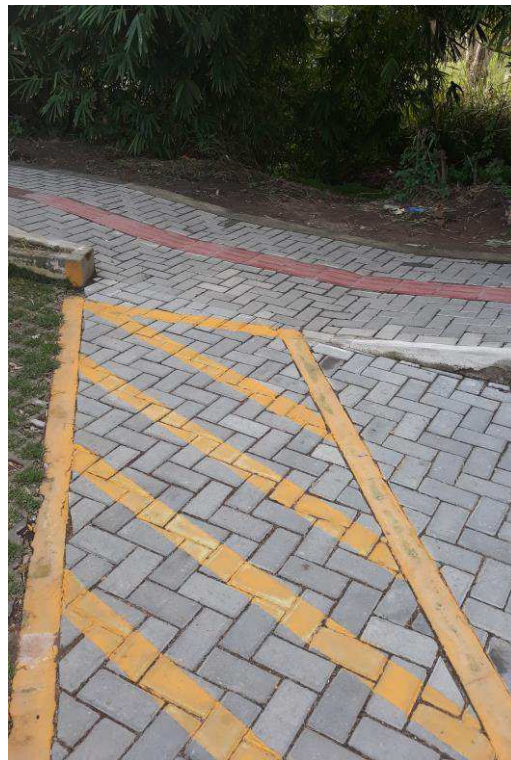
Figura 13: Rebaixamento da passarela.
