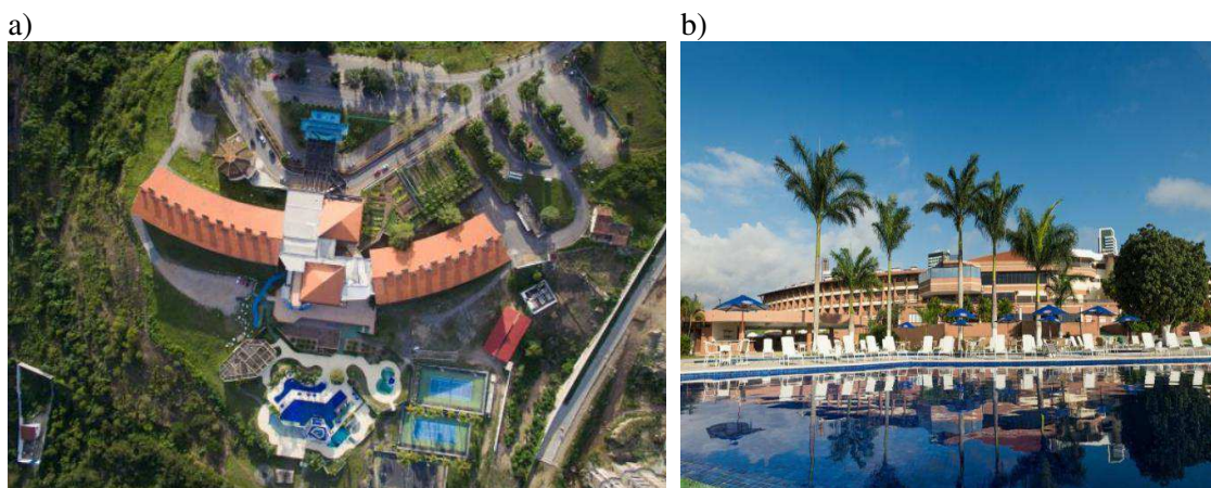
Figura 4 - a) Localização do Garden Hotel e b) Vista frontal do Garden Hotel.
