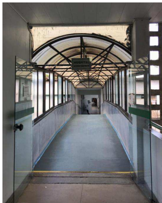
Figura 10 - Porta de acesso à outra edificação do HUAC
