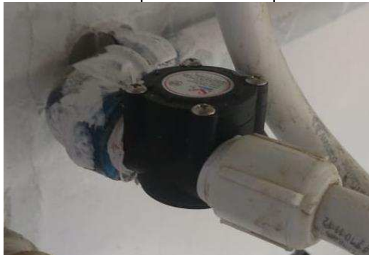
Figura 14 - Sensor de fluxo posicionado no ponto de saída de água
