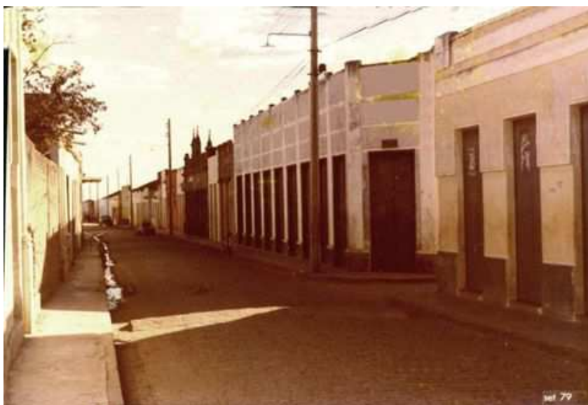
Figura 13: Rua do Comércio antes da inundação
