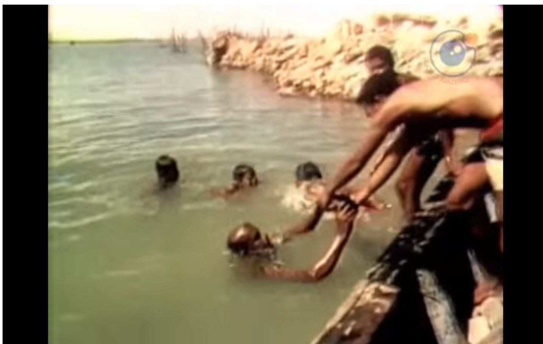
Figura 15: Moradores resgatando parte da alvenaria das casas submersas
