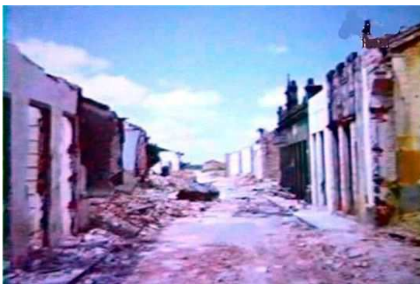
Figura 14: Rua do Comércio semi-destruída
