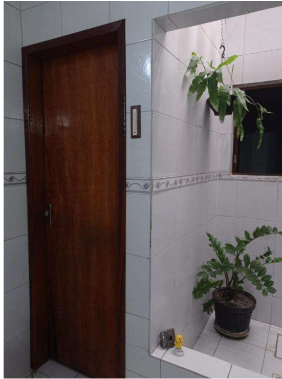
Figura 19 - Paredes 3 e 5 (respectivamente) no espaço emissor.
