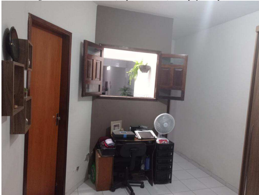
Figura 13 – Paredes 6 e 2 (respectivamente) no espaço receptor
