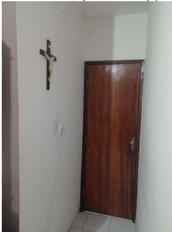
Figura 16 – Paredes 5 e 3 (respectivamente) no espaço receptor
